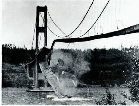
Figura 29: Ponte de Tacoma em colapso
