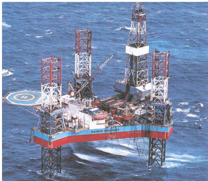
Figura 1 - Unidade auto-elevat ria de perfuraç o com heliponto em balanço
