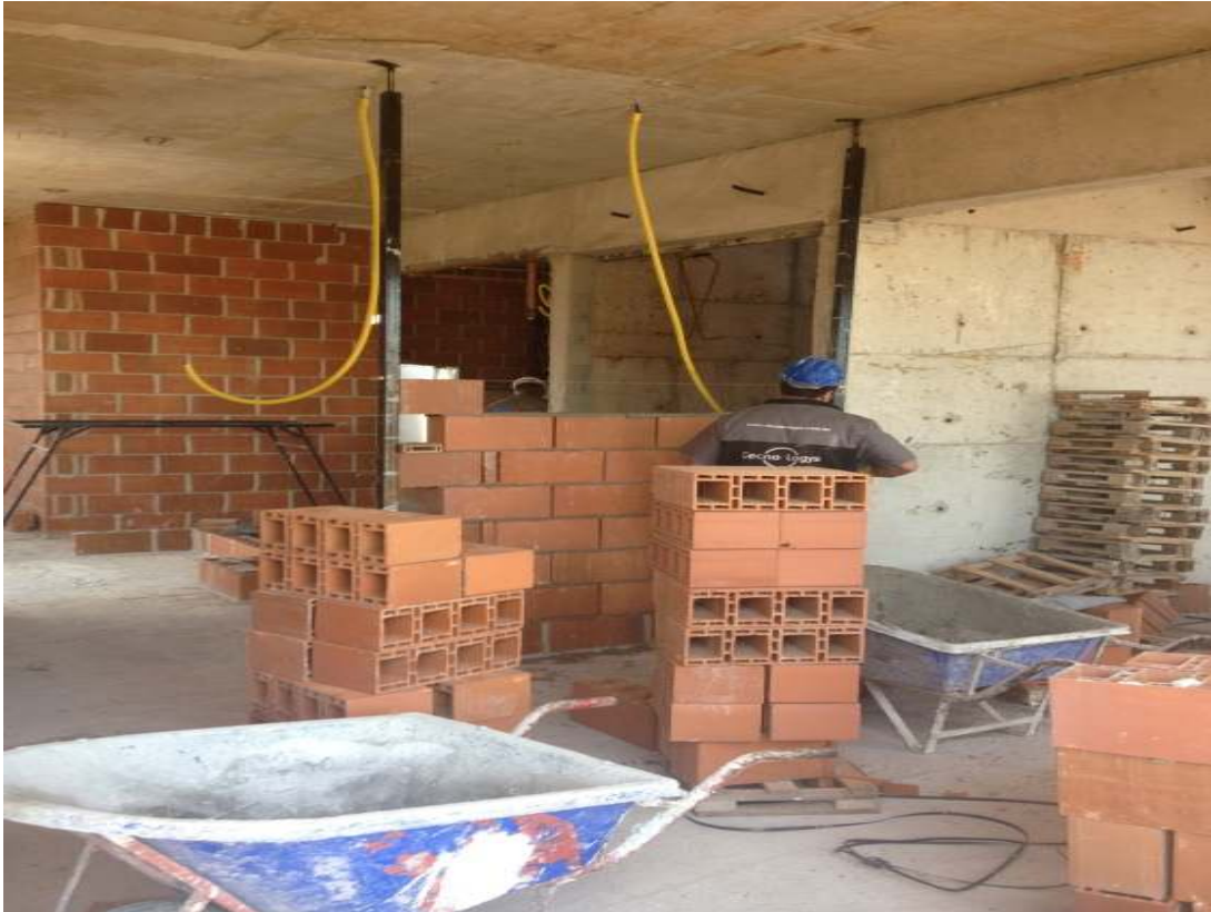
Figura 27 – Elevação da alvenaria com passagem dos condutes entre os blocos (Foto tirada pelo autor).
