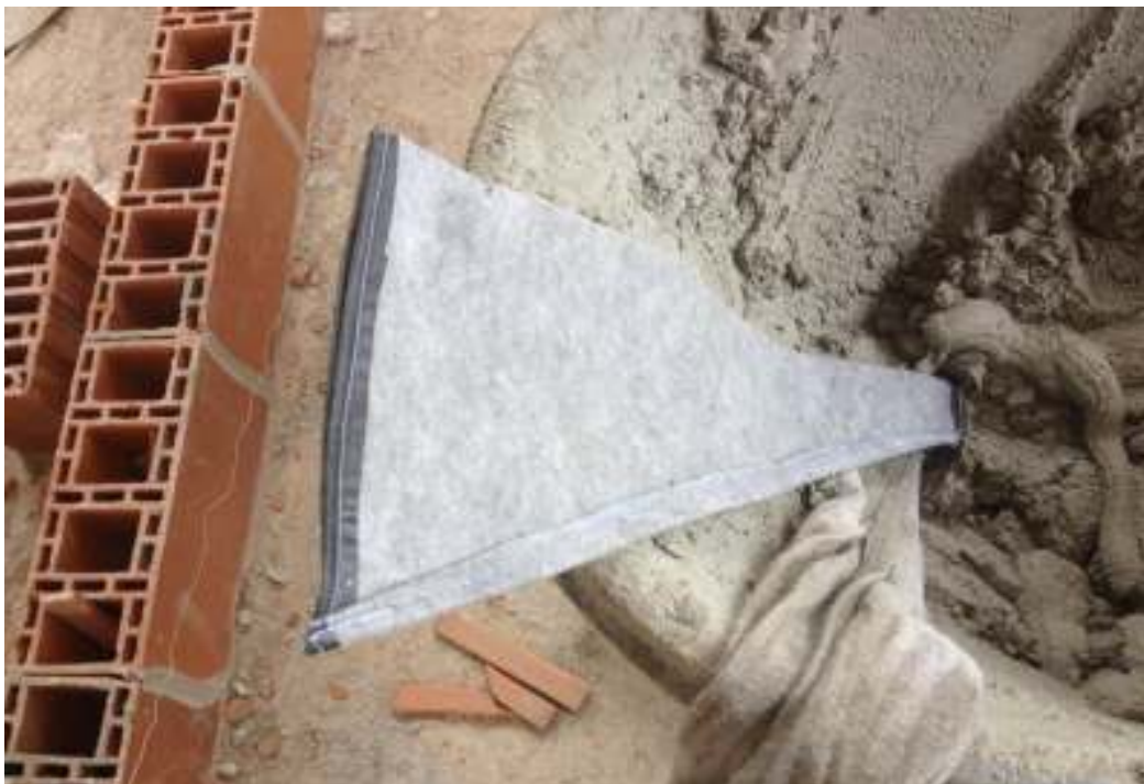
Figura26 – Execução da marcação da 1ª fiada (Foto tirada pelo autor).
