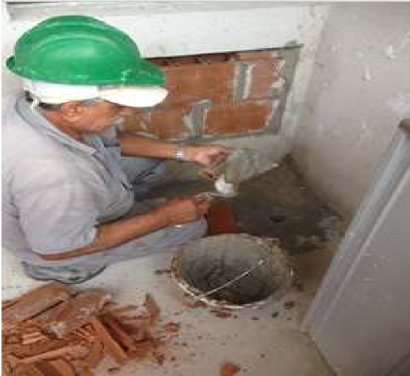
Figura 30: retrabalho – incompatibilidade de projetos flex (Foto tirada pelo autor).
