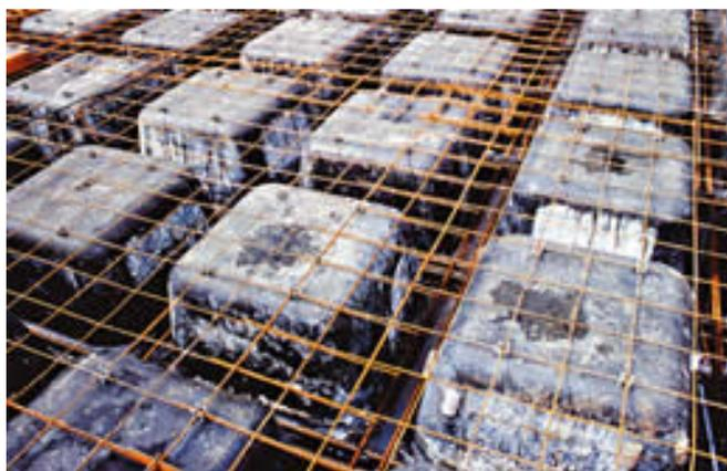
Figura 9 - Laje nervurada com cubas de plástico antes da concretagem (Fonte: Techné – Moldura Leve)
