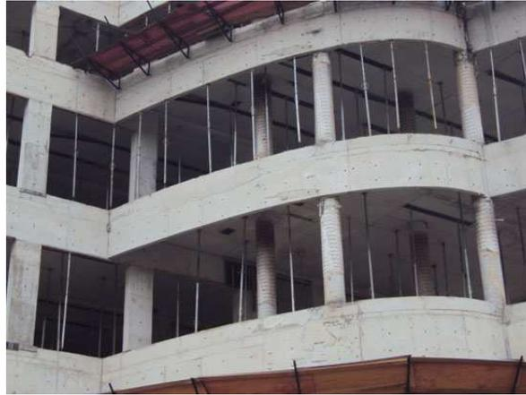
Figura 11 - Pilares com seção transversal circular concretados com fôrmas de papelão (Fonte: site da Dimbu)
