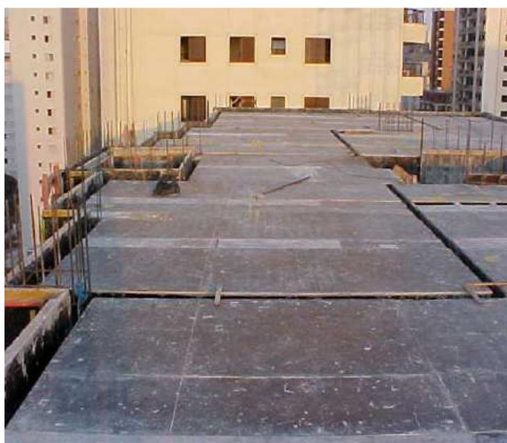
Figura 25 - Chapas de compensado pregadas nas suas posições definitivas (ZORZI, 2004)
