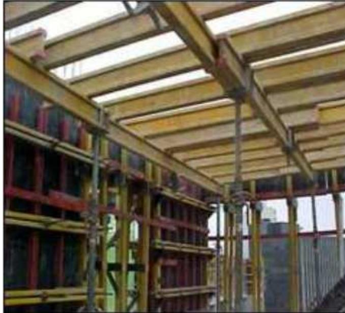
Figura 23 – Vigas inferiores suportadas pelas escoras e travadas pelos forçados (ZORZI, 2004)
