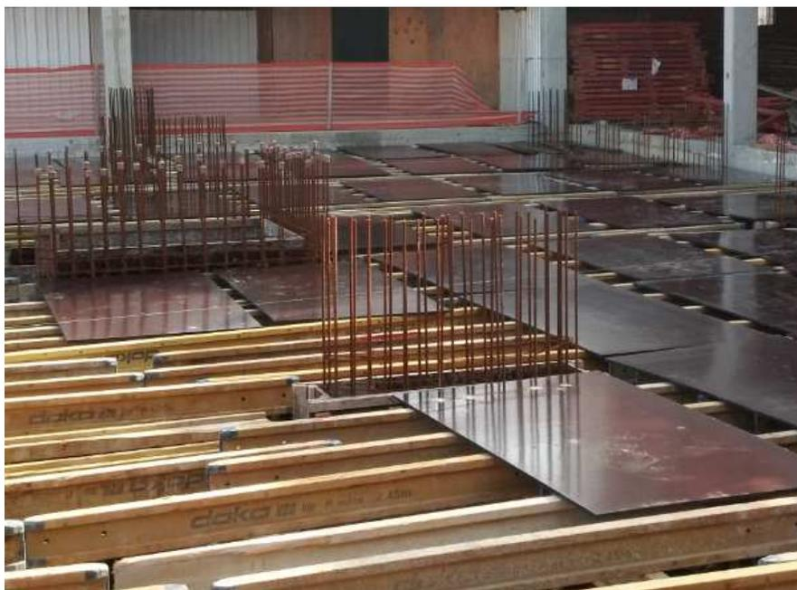
Figura 24 - Lançamento dos painéis no vigamento superior de acordo com o projeto (Fonte: foto tirada pelo autor)
