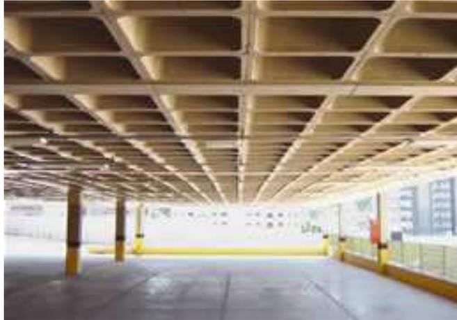
Figura 10 - Laje nervurada após a concretagem (Fonte: Techné - Moldura Leve)
