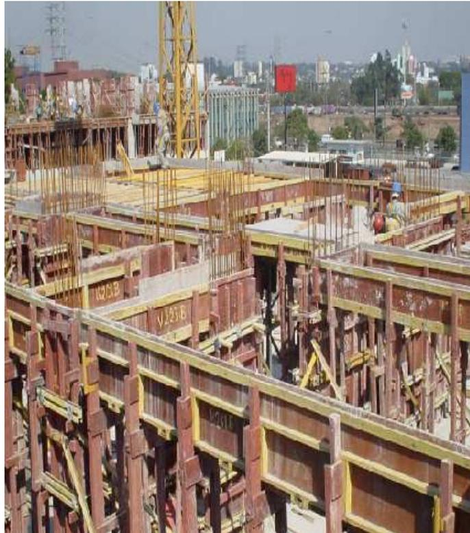
Figura 22 - Painéis laterais e de fundo das vigas apoiados nos garfos e na boca dos pilares (ZORZI, 2004)
