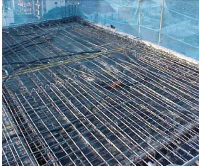
Figura 26 - Laje pronta com as armaduras e instalações posicionadas de acordo com o projeto (ZORZI, 2004)
