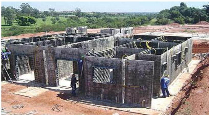
**Figura 9: - Paredes de concreto armado**
