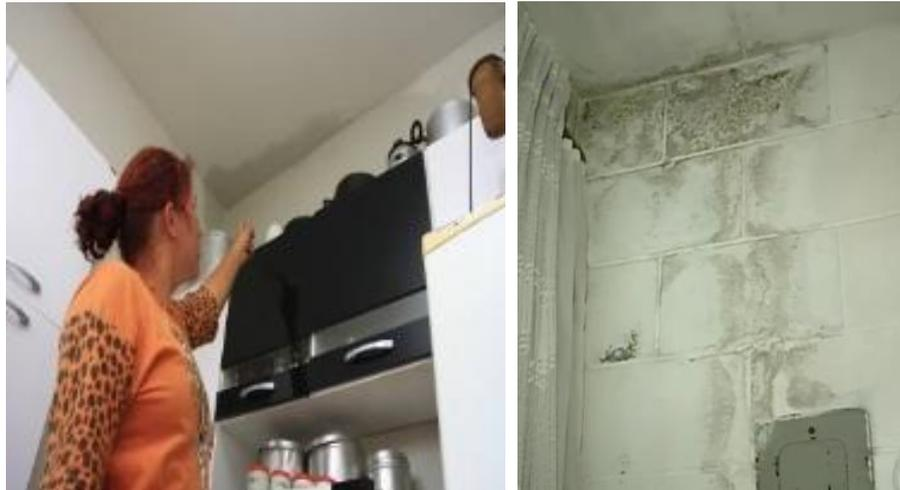
**Figura 17: infiltração e umidade na parede**
