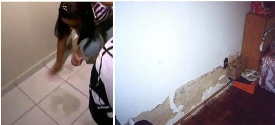
**Figura 18: Mancha no piso e empolamento de tinta**
