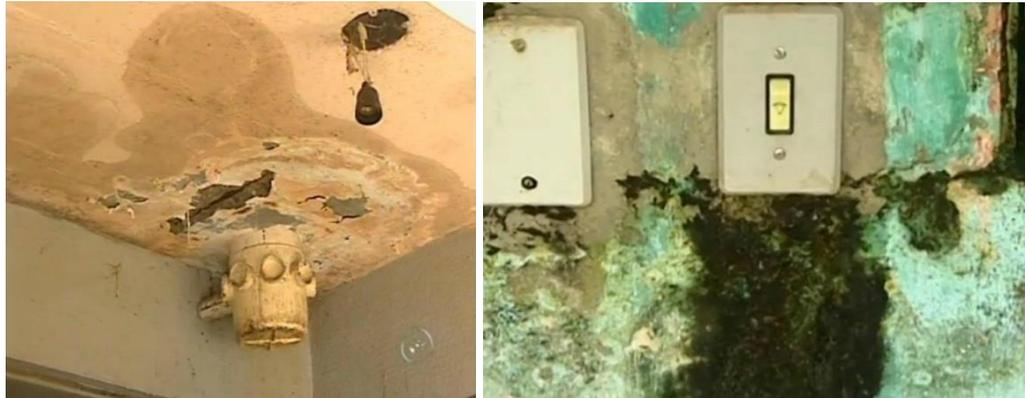
**Figura 19: Infiltração no teto e na parede**
