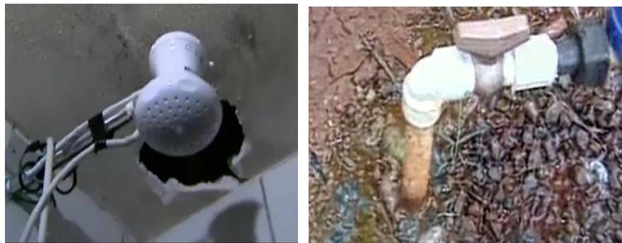
**Figura 22: Encanamento deficiente do chuveiro e vazamento no registro**
