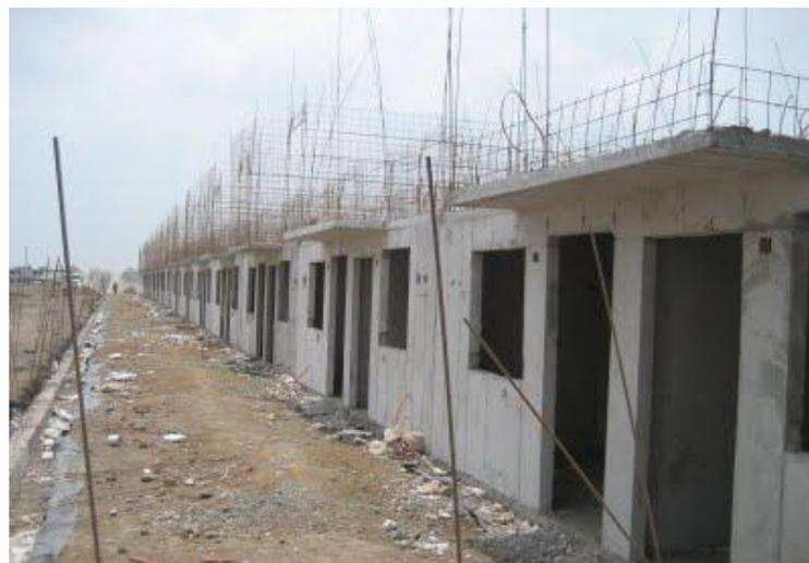
**Figura 10: Casas semi-prontas em concreto armado**
