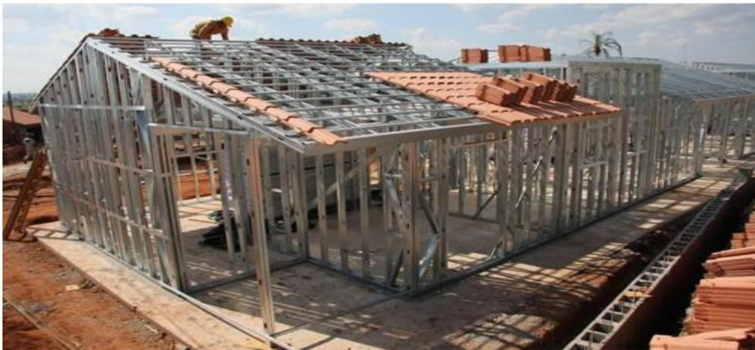
**Figura 7: Montagem da casa em steel frame**
