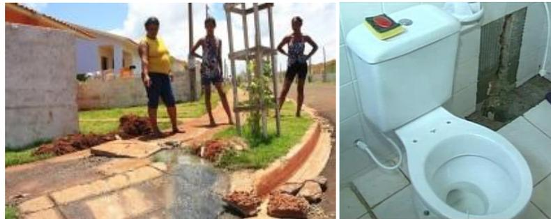
**Figura 24: Vazamento do esgoto e encanamento deficiente do banheiro**
