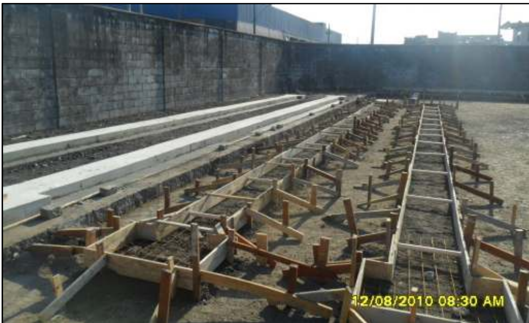
Fig85. Confeção dos berços para apoio das vigas pré-moldadas
