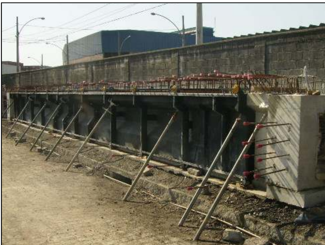
Fig95. Montagem da fôrma metálica escorada na lateral para não ocorrer tombamento
