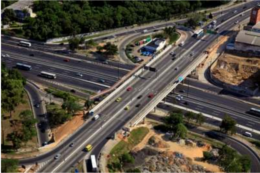
Fig106. Foto aérea do viaduto de Manguinhos (Abril/2011) Fonte: Empresa Angular, contratada para tirar as fotografias aéreas das obras
