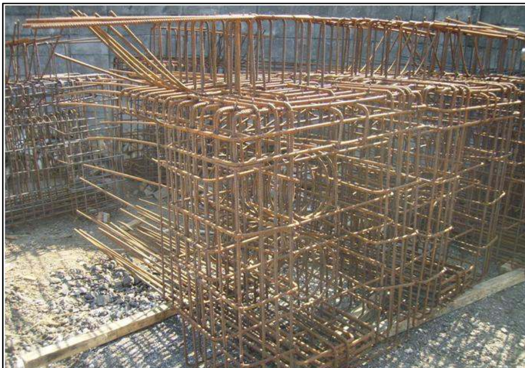
Fig88. Armadura da cabeça da viga
