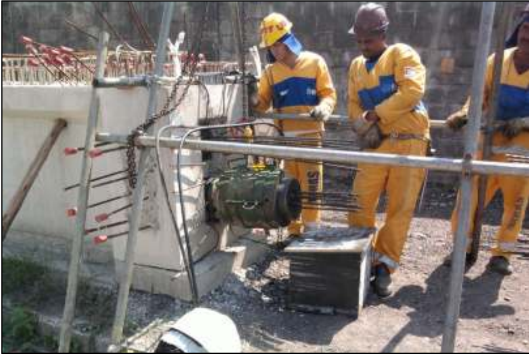
Fig97. Protensão das vigas longarinas
