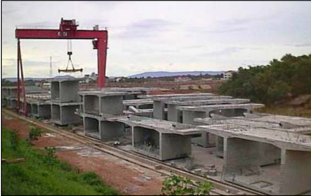
Fig6. Pátio de pré-moldados - sistema Long-Line Fonte: Bridge Construction Methods By David Trayner
