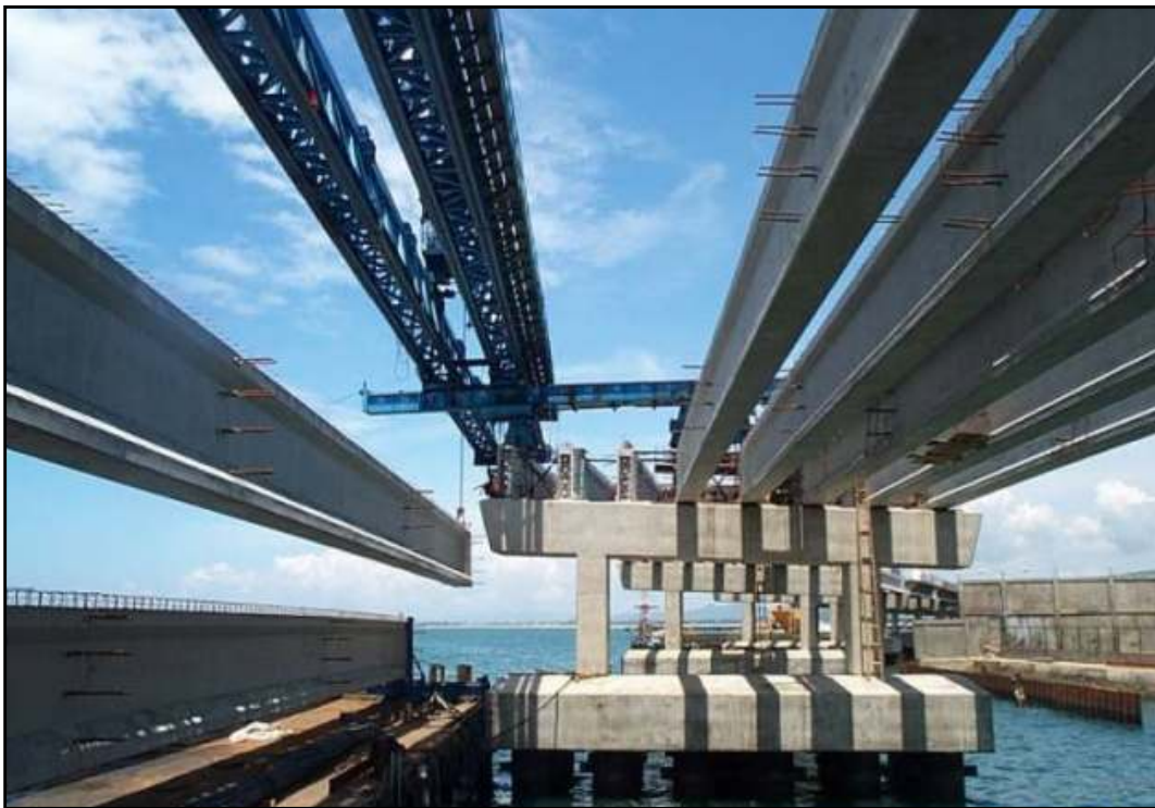
Fig26. Lançamento de vigas pré-moldadas através de Treliza Lançadeira. Obra Cebu South Coastal Road, Philippines, 2002 Fonte: Bridge Construction Methods By David Trayner
