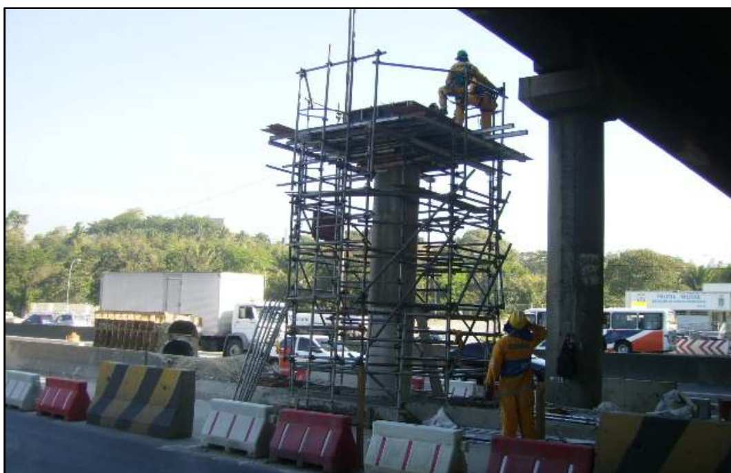
Fig83. Pilar P13 já concretado, ainda com a fôrma da segunda etapa e montagem da fôrma e armação do capitel
