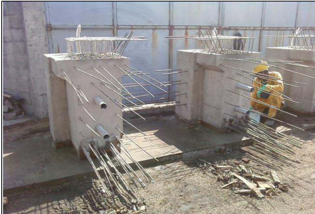
Fig90. Cabeça da viga já concretada. Detalhe para a armadura de espera da laje (em cima), da transversina (lateral) e da longarina (na frente), além da espera para a bainha de protensão
