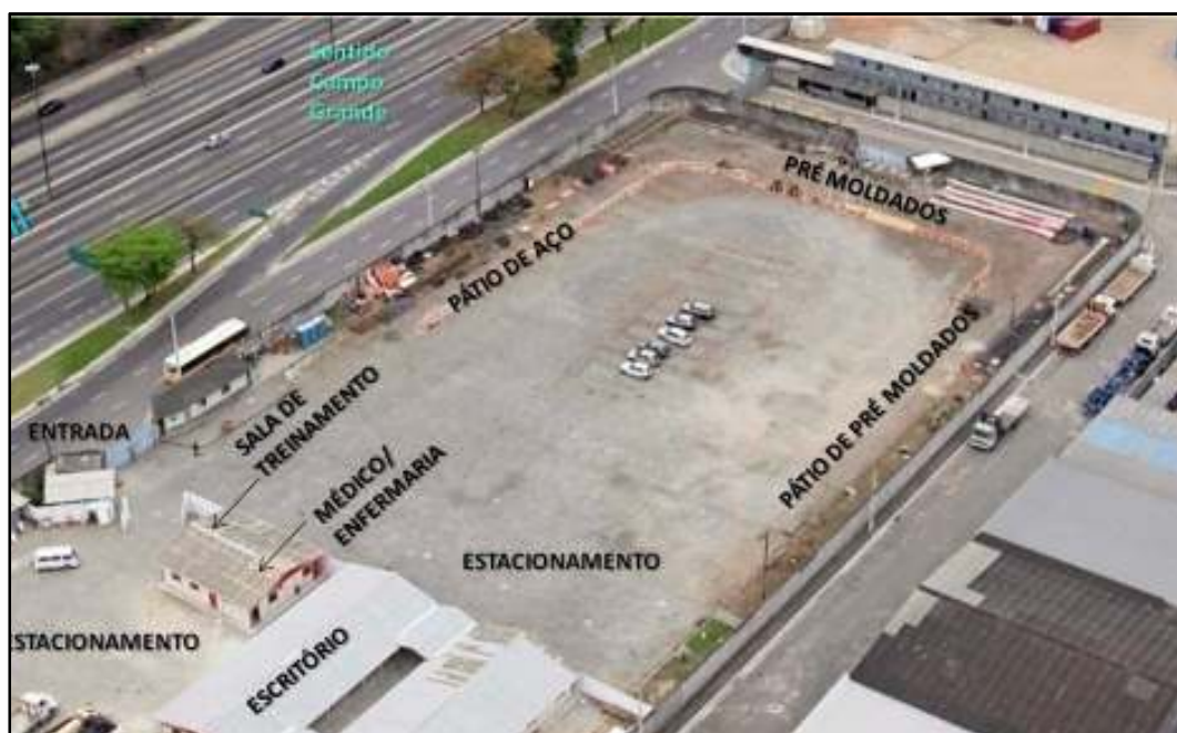
Fig71. Canteiro central, localizado na Av. Brasil. Detalhe para o espaço disponível para o pátio de pré-moldados e pátio de aço
