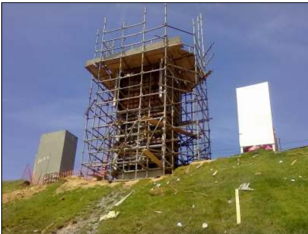
Fig76. Execução da nova chaminé de equilíbrio. Ao lado esquerdo está a antiga existente Fonte: Autor
