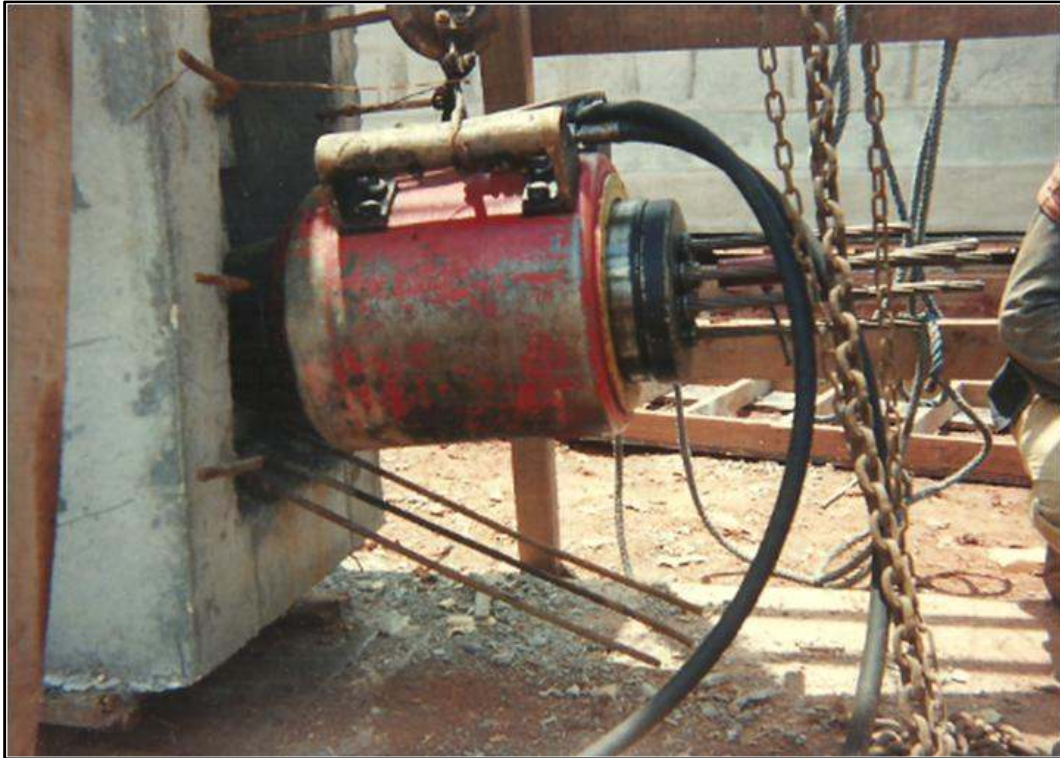
Fig28. Detalhe da protensão da viga com macaco hidráulico. Obra Viaduto da Rodovia Governador Carvalho Pinto sobre Rodovia Presidente Dutra, Trecho Campos do Jordão – Construtora Cowan (1993/1994). Fonte: Imagens cedidas pelo mestre de obras Antônio Borges
