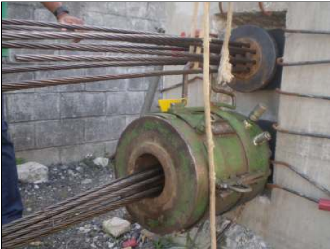
Fig98. Protensão das vigas longarinas
