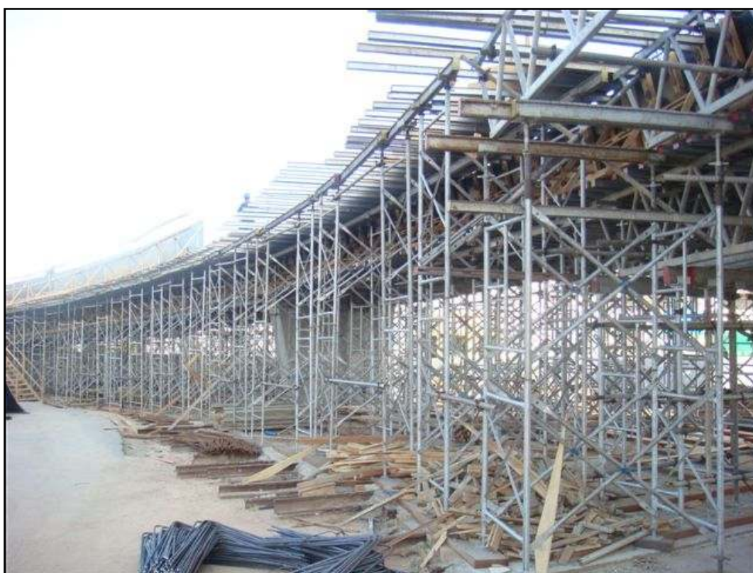
Fig32. Escoramento fixo. Obra Viaduto Industrial João Lira, Pernambuco Fonte: SH Fôrmas
