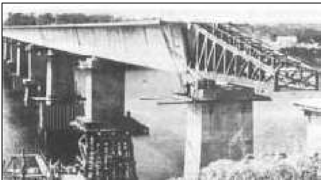
Fig15. Primeira ponte em empurramento sucessivo (ponte sobre o Rio Caroni na Venezuela). Fonte: The Incremental Launching Method In Prestressed Concrete Bridge Construction,1977 (VSL)
