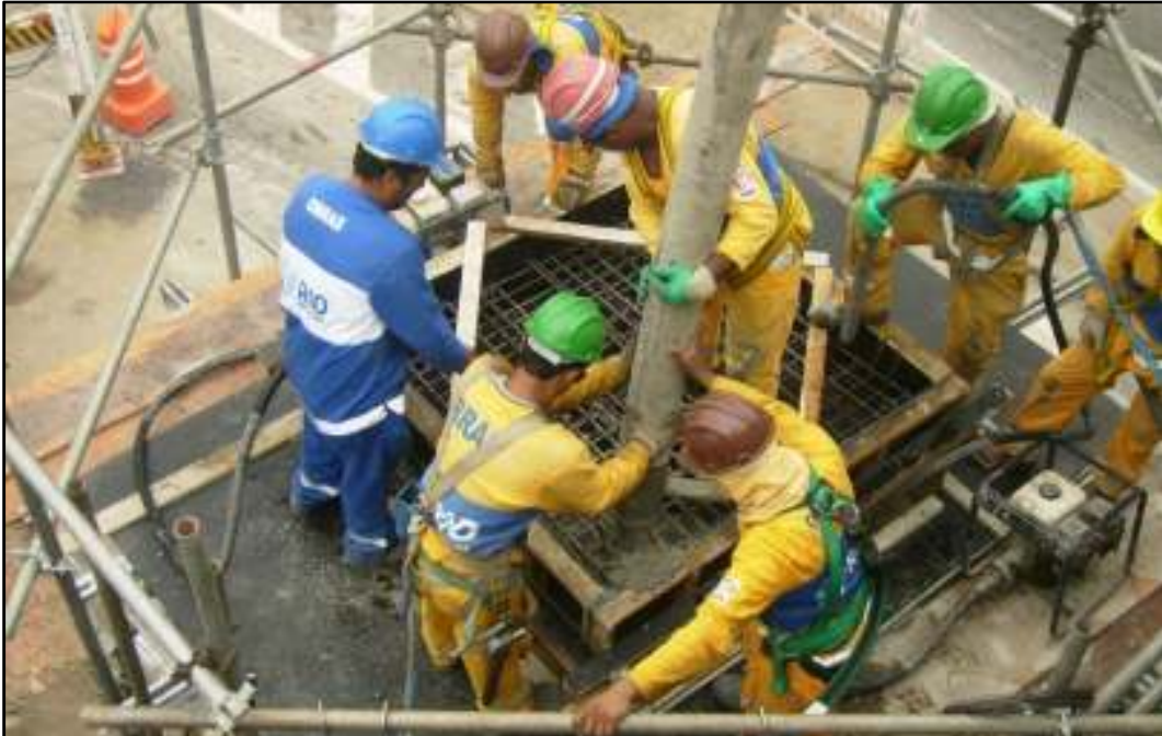
Fig84. Concretagem do capitel 14
