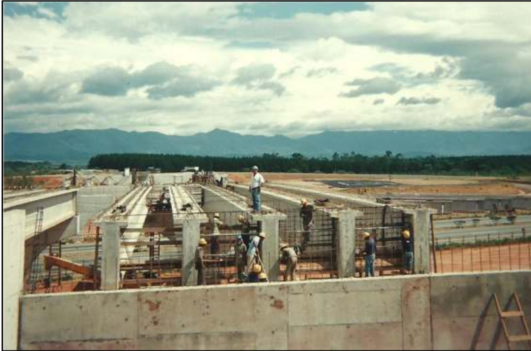
Fig30. Vista das vigas lançadas e detalhe da montagem da armadura da transversinas. Ao lado direito da imagem está o canteira de pré-moldados. Obra Viaduto da Rodovia Governador Carvalho Pinto Sobre Rodovia Presidente Dutra, Trecho Campos do Jordão – Construtora Cowan (1993/1994). Fonte: Imagens cedidas pelo mestre de obras Antônio Borges
