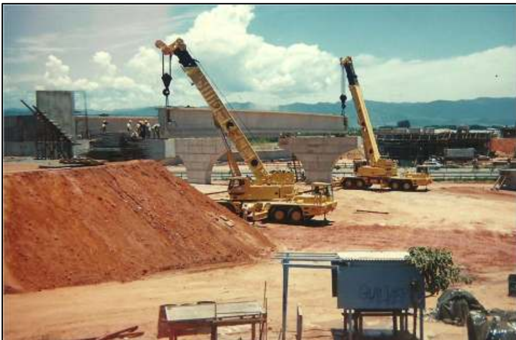
Fig29. Lançamento das vigas com guindaste. Obra Viaduto da Rodovia Governador Carvalho Pinto sobre Rodovia Presidente Dutra, Trecho Campos do Jordão – Construtora Cowan (1993/1994). Fonte: Imagens cedidas pelo mestre de obras Antônio Borges
