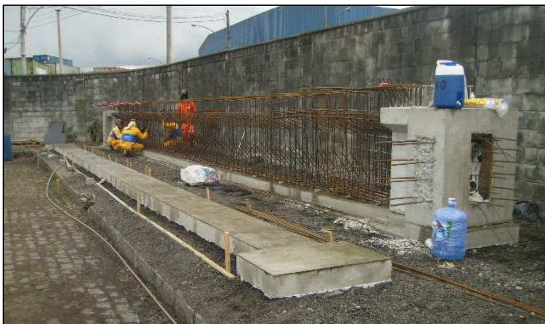
Fig92. Montagem da armadura da viga
