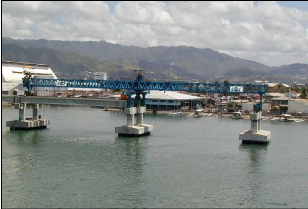
Fig25. Lançamento de vigas pré-moldadas através de Treliza Lançadeira. Obra Cebu South Coastal Road, Philippines, 2002 Fonte: Bridge Construction Methods By David Trayner
