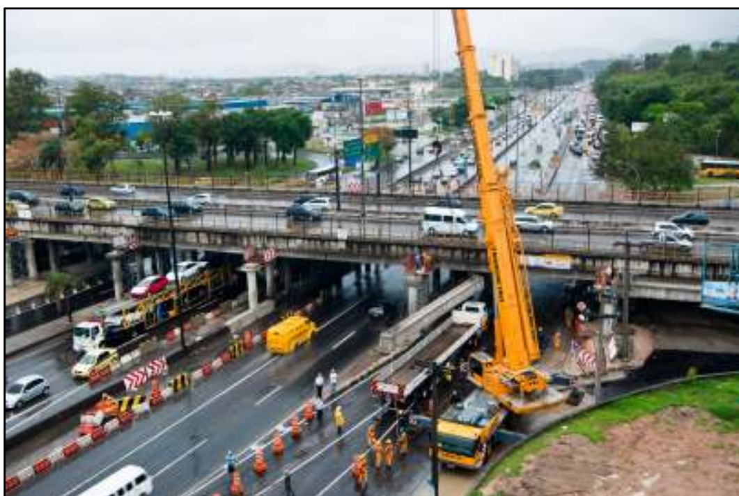
Fig70. Lançamento das vigas na posição de projeto da figura 60
