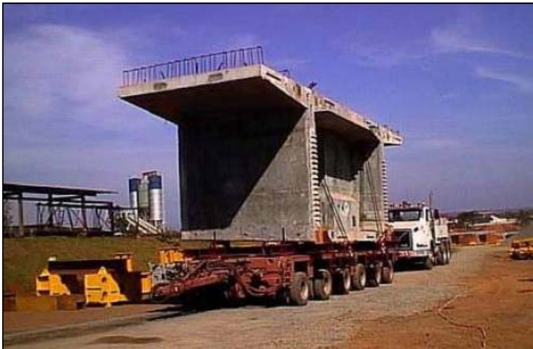
Fig7. Transporte dos segmentos pré-moldados (sistema Long-Line ) Fonte: Bridge Construction Methods By David Trayner
