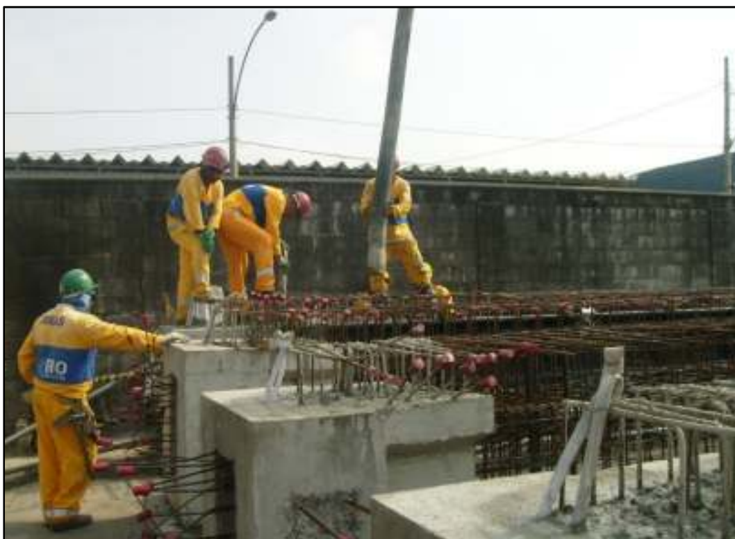
Fig96. Concretagem das vigas
