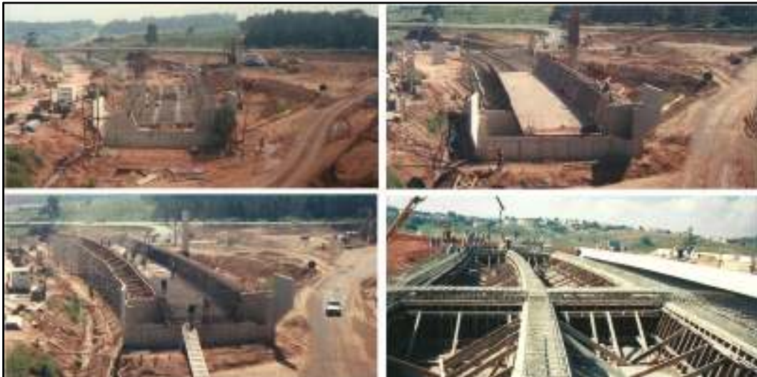
Fig33. Etapas executivas de um viaduto em vigas caixão realizado com escoramento convencional Fonte: Fotos cedidas pelo mestre de obras Antônio Borges
