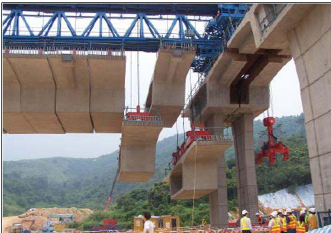
Fig2. Execução de Balanço Sucessivo em viaduto com aduelas pré-moldadas Fonte: Bridge Construction Methods By David Trayner
