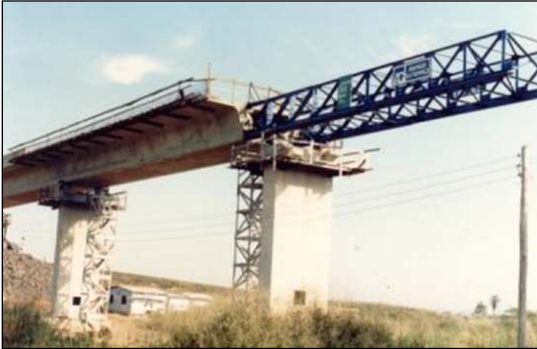
Fig19. Execução de método de Empurramento Sucessivo. Obra Ponte Empurrada / SP - Construtora Andrade Gutierrez Fonte: MAC Protensão Ltda.
