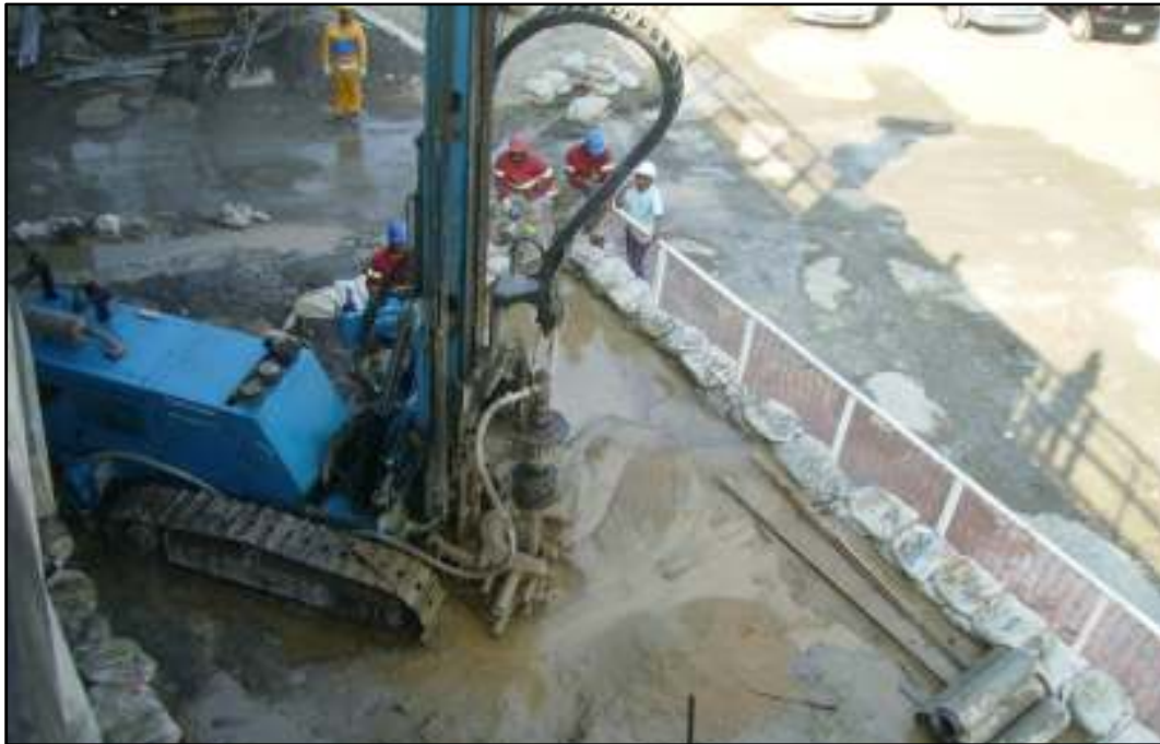
Fig80. Execução da estaca raiz
