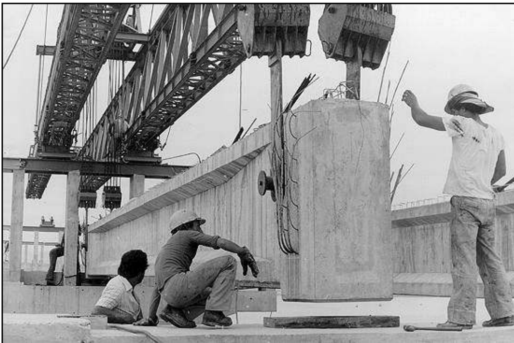
Fig24. Lançamento de vigas pré-moldadas através de treliça lançadeira. Obra Construção da Ponte do Mar Pequeno, 1980. Fonte: Secretaria de Transportes do Estado de São Paulo/Dersa
