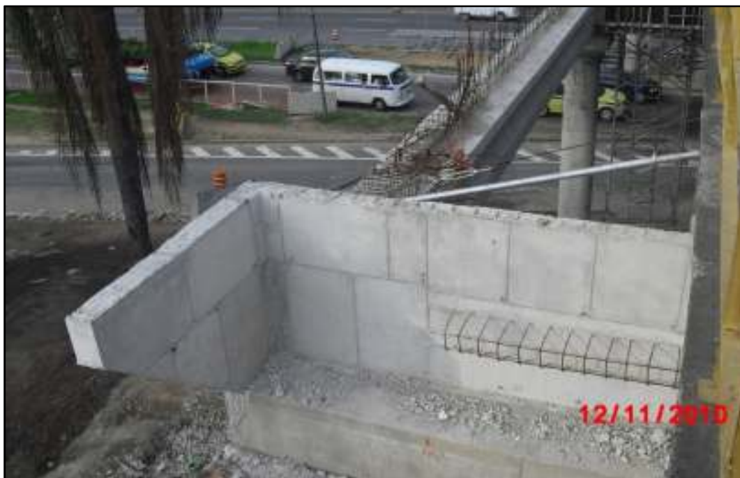
Fig82. Encontro E2B concretado
