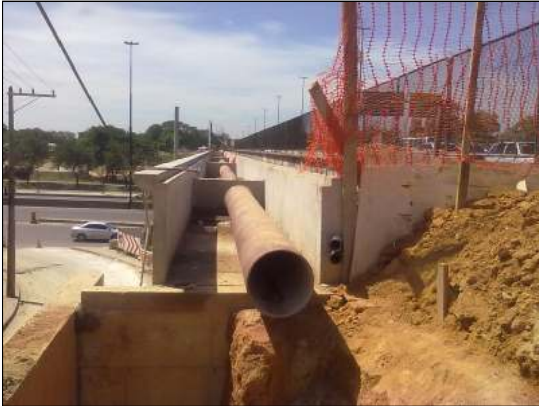
Fig75. Detalhe da nova passagem de pedestre com a tubulação da adutora já posicionada e travada nas laterais Fonte: Autor
