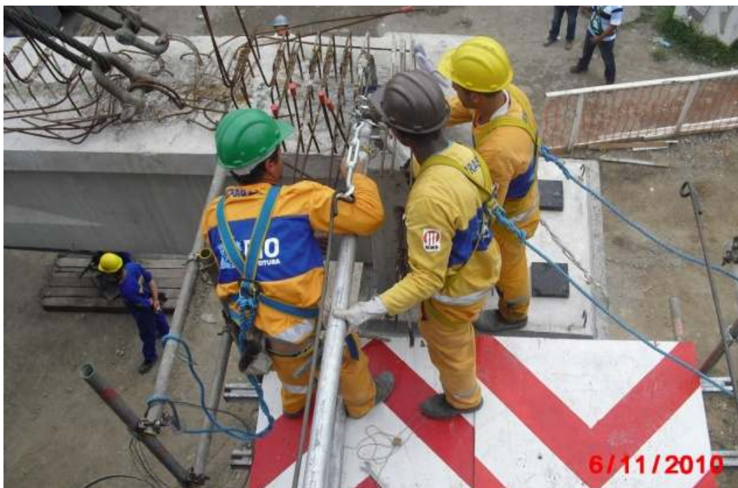
Fig103. Escoramento da viga
