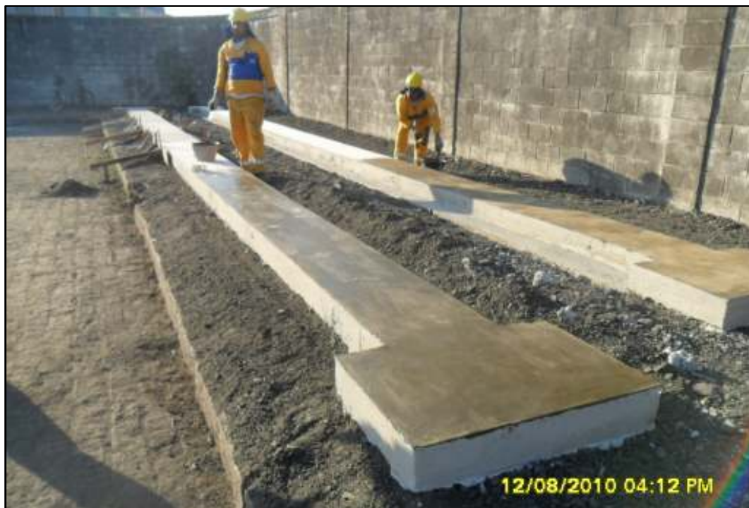
Fig86. Graxa líquida sendo passada no berço para não aderir o concreto da viga com o do berço
