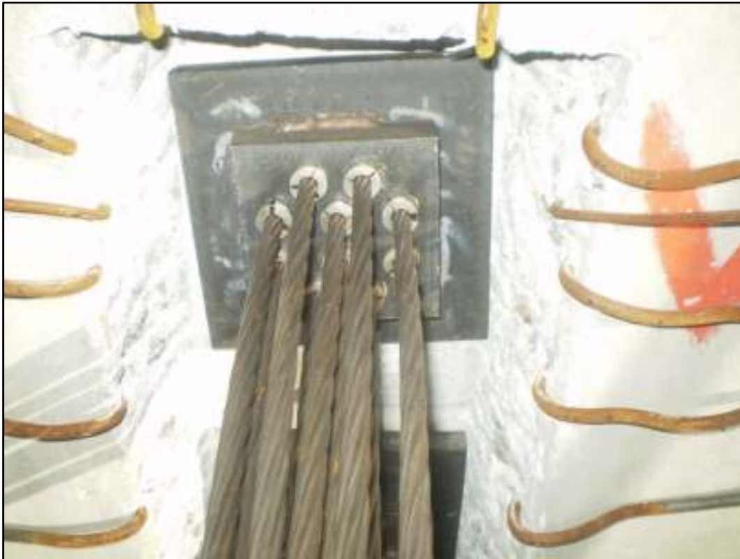
Fig99. Viga já protendida
