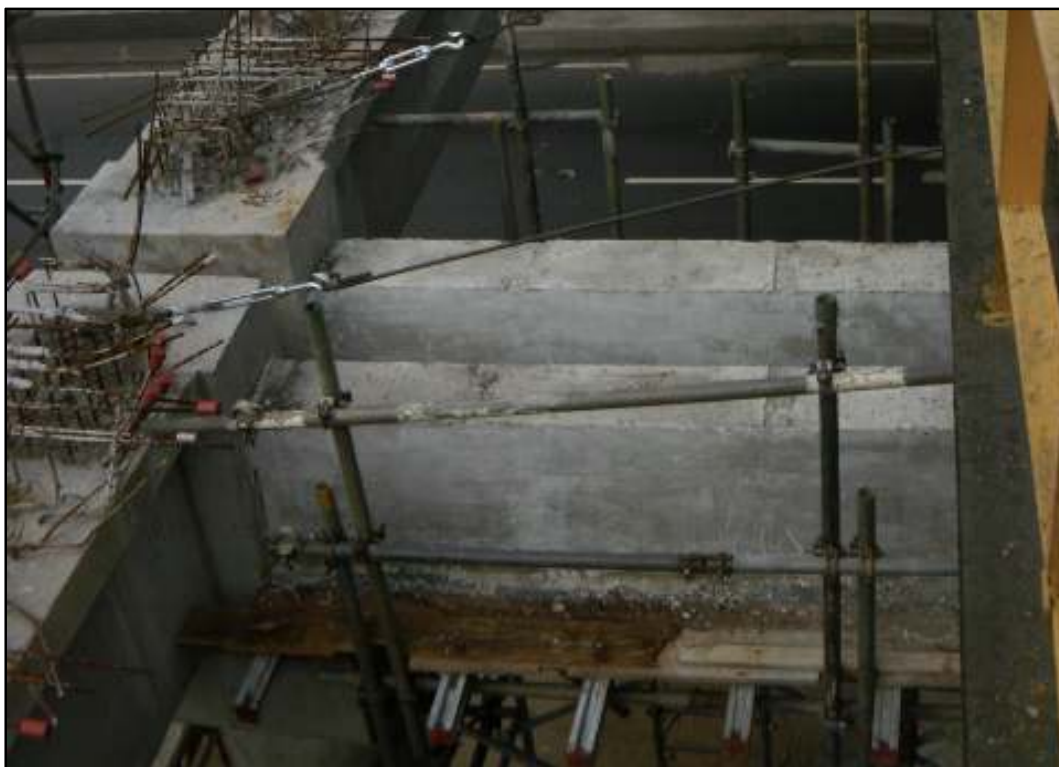
Fig104. Vigas transversinas executadas
