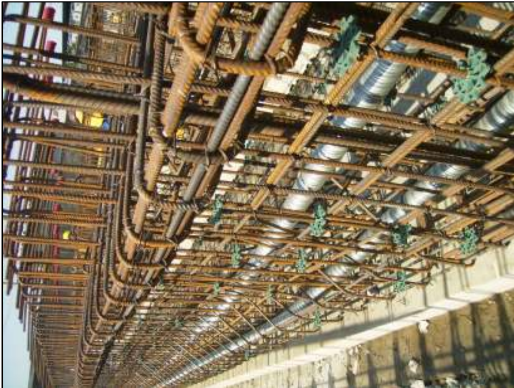
Fig94. Detalhe para a bainha de protensão e espaçadores entre a armadura da viga
