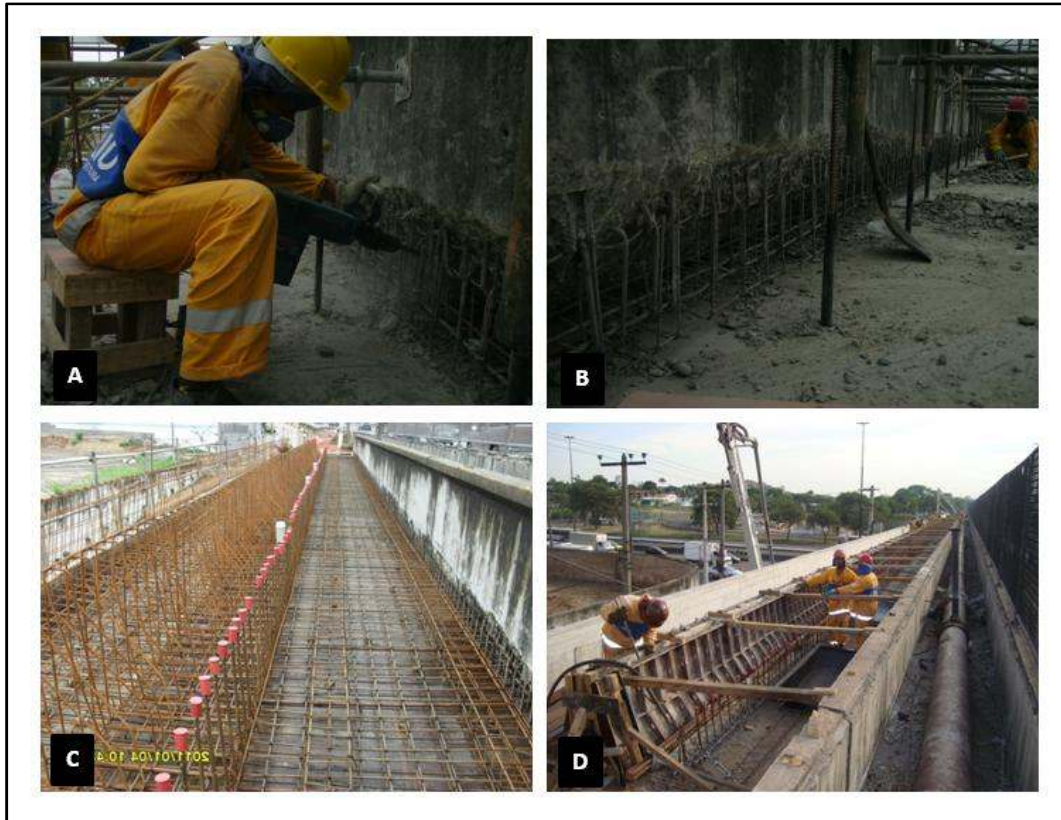
Fig79. Figura A – Escarificação da laje existente para engastamento da pré-laje. Figura B – Laje existente escarificada. Figura C – Montagem da armadura da pré-laje e da nova passagem de pedestre. Figura D – Fôrma e concretagem da barreira New Jersey sobre a passagem de pedestre. Detalhe para a passagem de pedestre existente a direita com a adutora que será remanejada. Fonte: Autor
