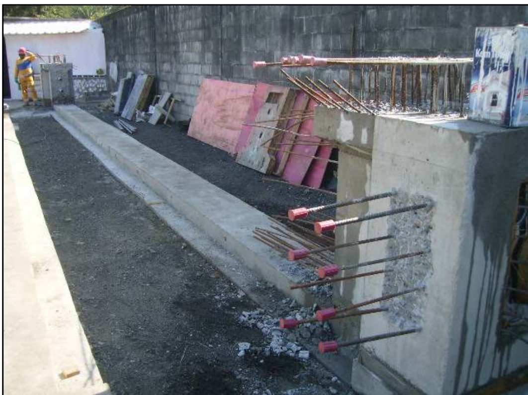
Fig91. Posicionamento das duas cabeças da viga no berço. Esta escarificação na lateral é para aderir melhor a transversina que será posteriormente executada
