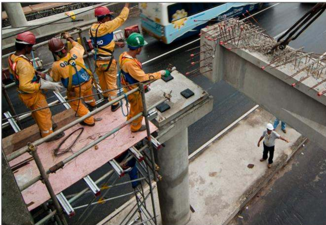
Fig100. Posicionamento dos aparelhos de apoio Neoprene
