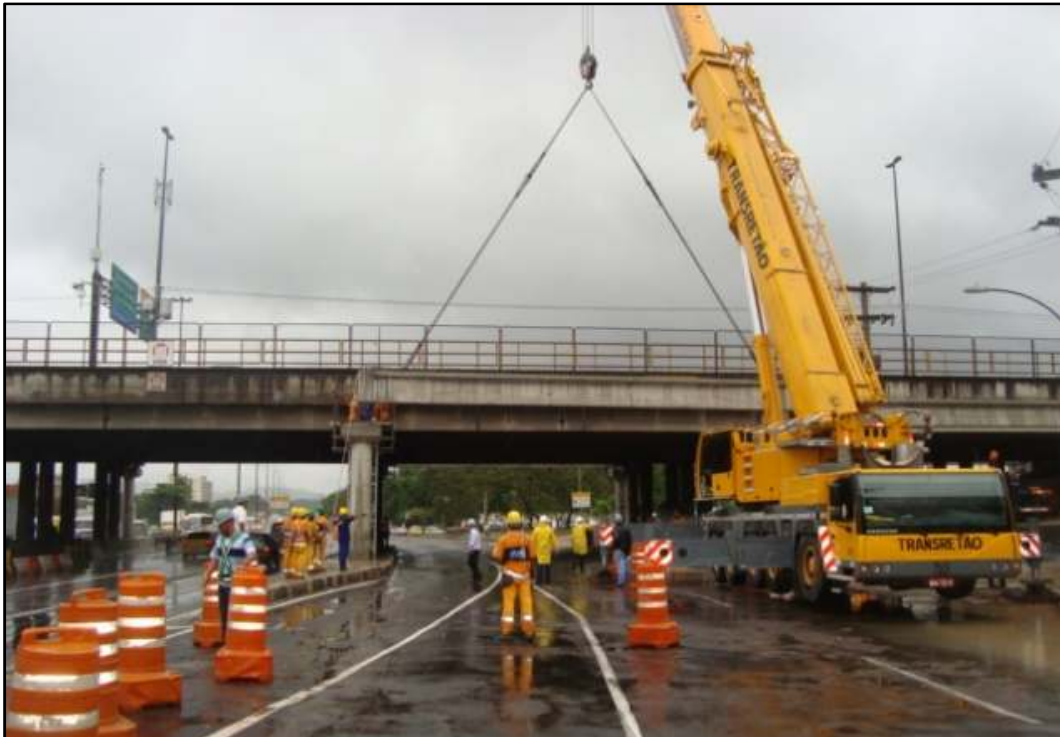
Fig102. Lançamento da viga com auxílio do guindaste
