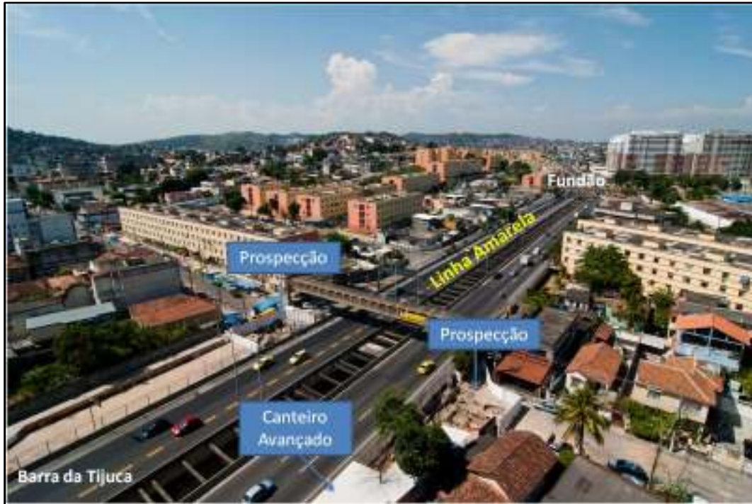
Fig43. Foto aérea ilustrando as prospecções e canteiro avançado, no local onde será executado o Viaduto da Abolição Fonte: Adaptação de foto tirada pelo fotógrafo contratado da obra Sérgio Huoliver
