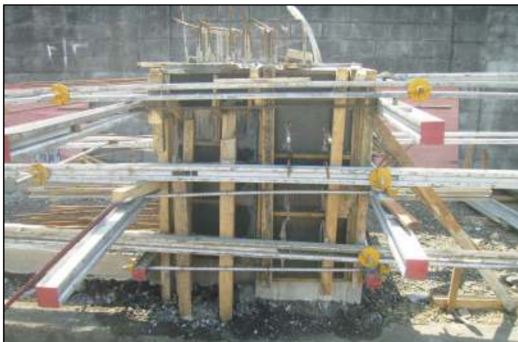
Fig87. Fôrma da cabeça da viga
