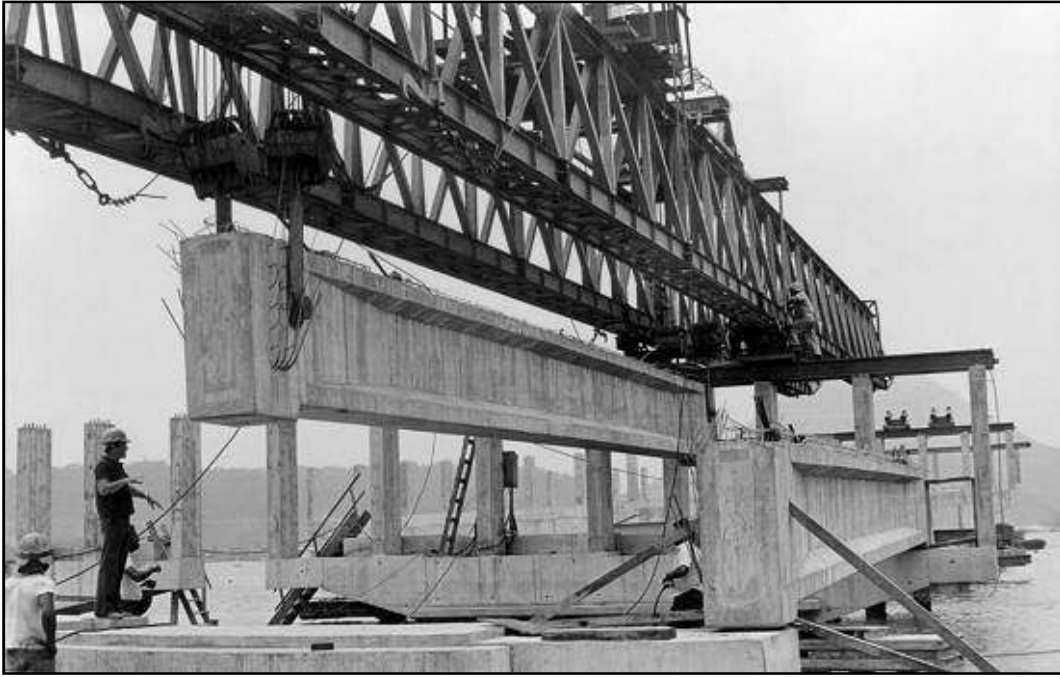
Fig23. Lançamento de vigas pré-moldadas através de treliça lançadeira. Obra Construção da Ponte do Mar Pequeno, 1980. Fonte: Secretaria de Transportes do Estado de São Paulo/Dersa
