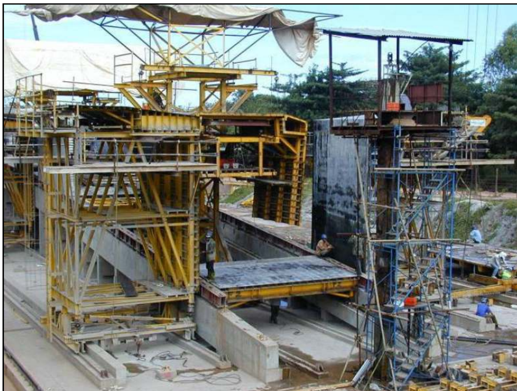
Fig5. Local de fabricação dos segmentos pré-moldados por vão do sistema Long-Line Fonte: Bridge Construction Methods By David Trayner
