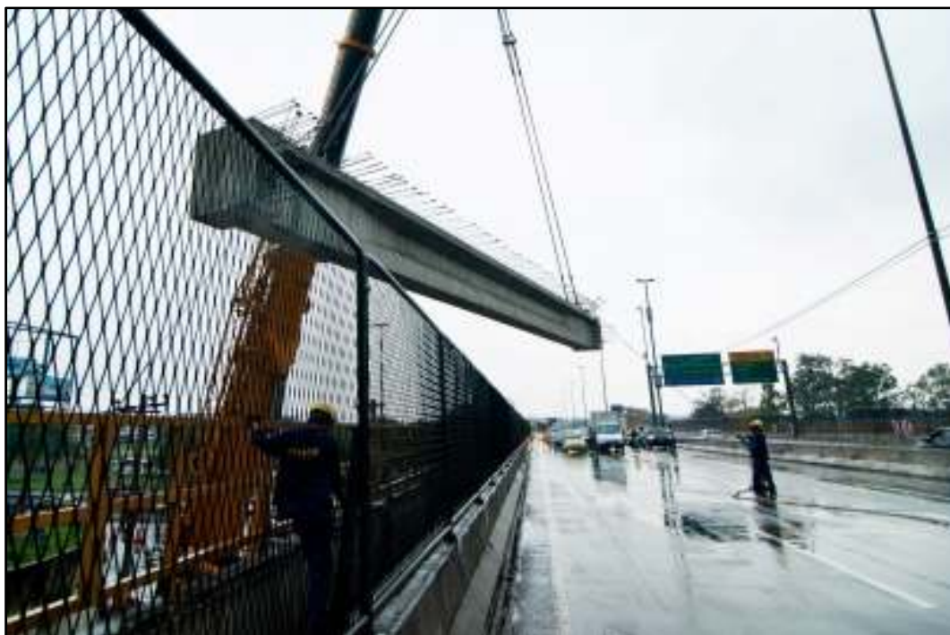
Fig69. Detalhe do lançamento de uma viga em que foi necessária a interrupção total da Linha amarela em seu lançamento (total de 8 minutos)
