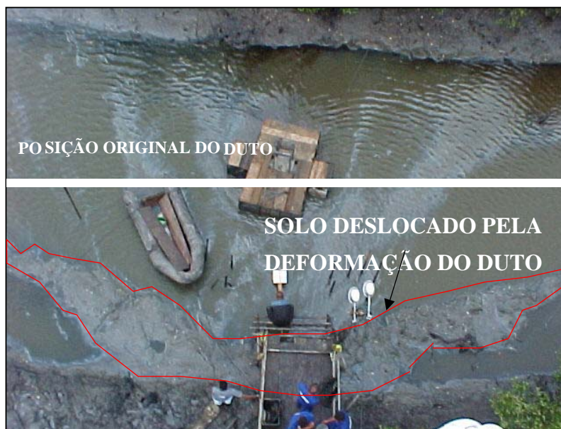
Figura 3 – Vista aérea do local da ruptura.
