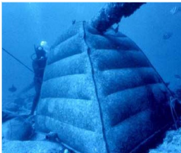
Figura 8 - Exemplo de grout bag .
