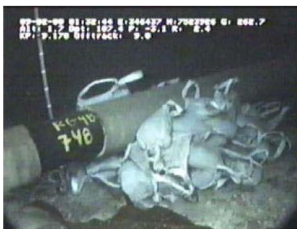
Figura 9 - Exemplo de grout bag .
