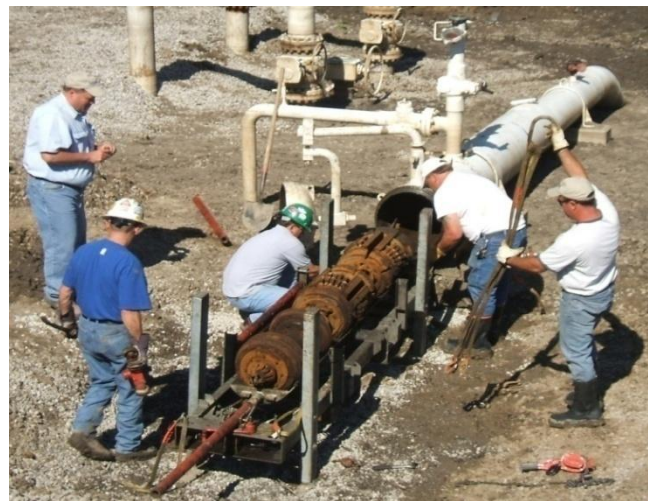
Figura 5 – Smart PIG sendo retirado do duto.
