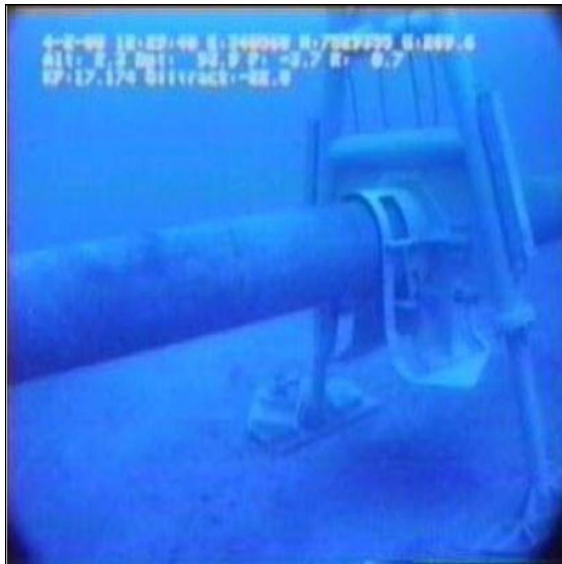
Figura 14 - Exemplo de suporte mecânico instalado.
