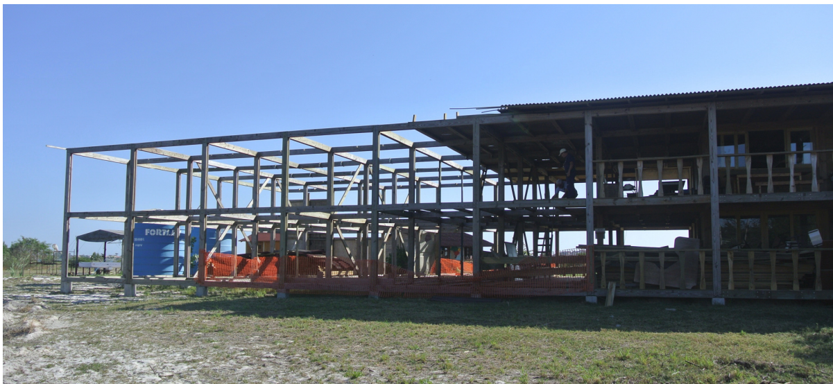
Figura 4: Instituto Politécnico de Cabo Frio – Parte em construção
