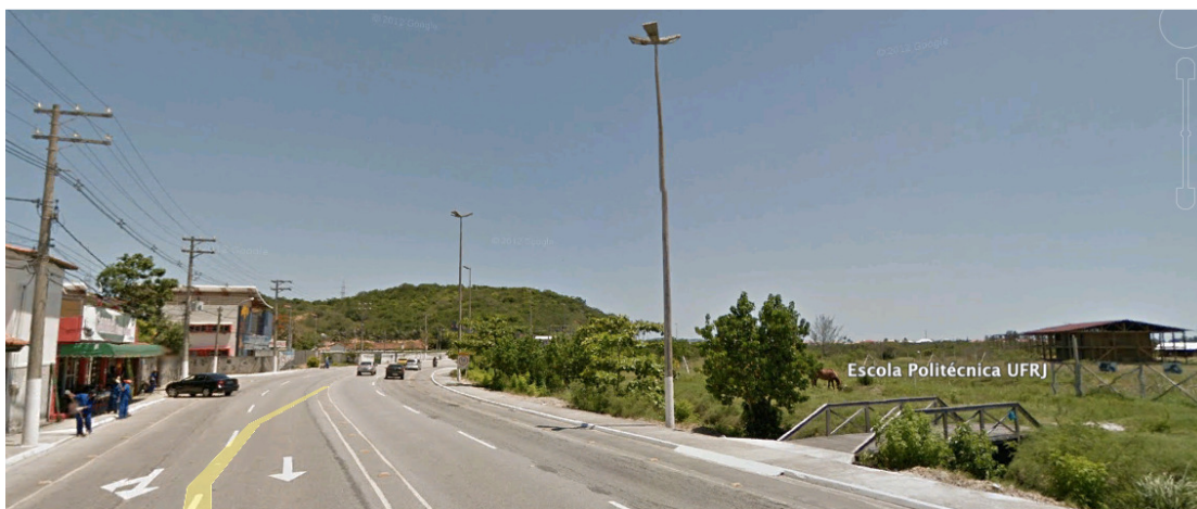
Figura 6: Rede de distribuição da Ampla - (Fonte:Google Earth, Fevereiro/2013)
