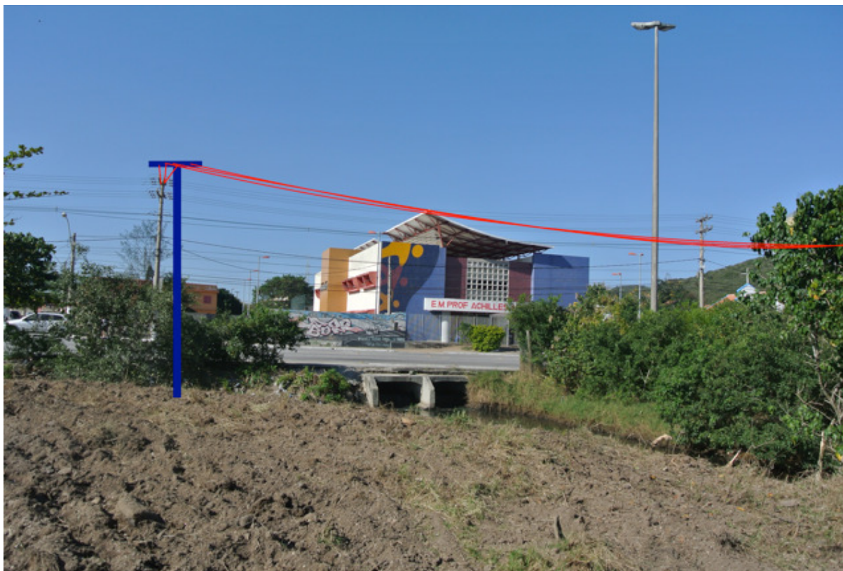
Figura 21: Montagem da rede de energia – Poste A
