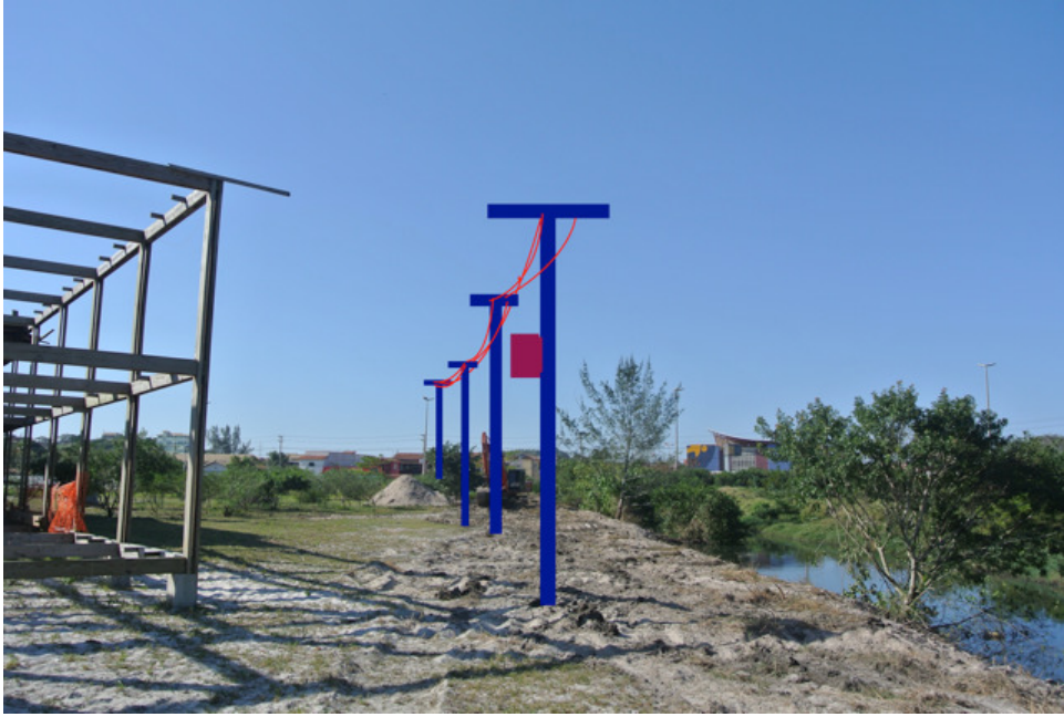
Figura 22: Montagem da rede de energia
