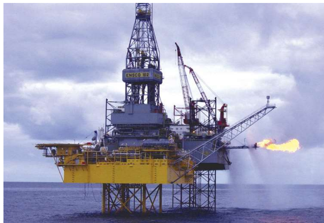
Figura 2: Plataforma Auto elevatória. [4]
