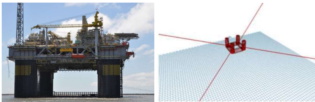
Figura 31: Imagem da plataforma P-55 e do modelo truncado de 4 linhas utilizado. [7]
