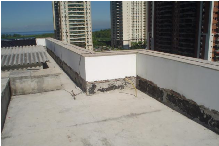
Figura 13 - Abertura de toda periferia do telhado para correção do detalhe da manta
