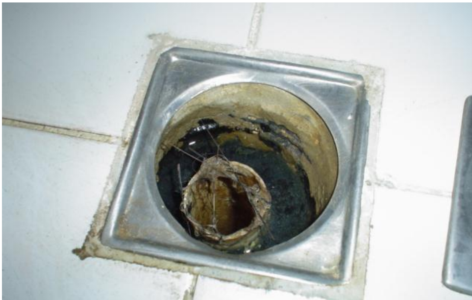
Figura 12 - Pescoço do ralo acima da impermeabilização
