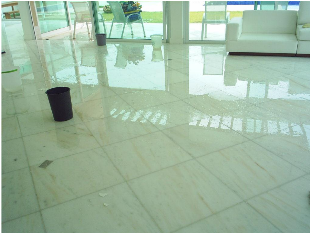
Figura 18 - Rejuntamento do piso de mármore amarelado
