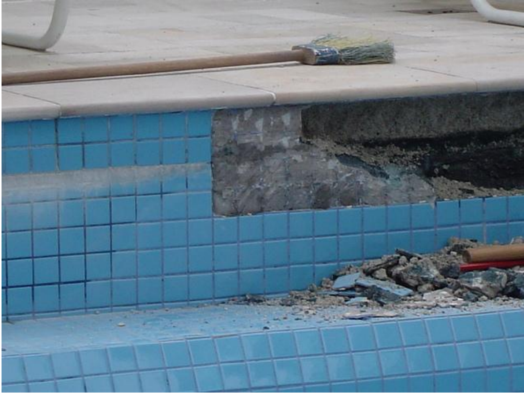
Figura 11 - A virada da manta não se estende até a borda da piscina
