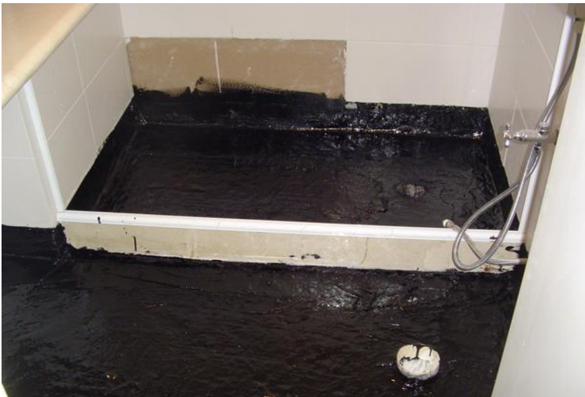
Figura 9 - Nova impermeabilização flexível aplicada com a solução asfáltica + tela de poliéster, fazendo a vedação inclusive junto ao tecto
