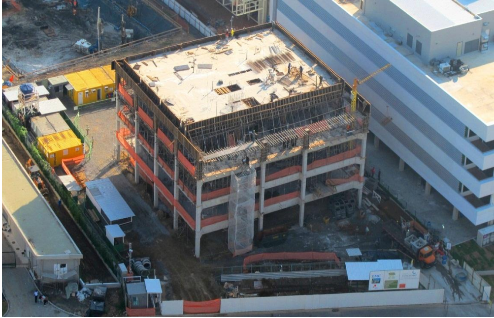
Figura 02 – Fase atual da obra
