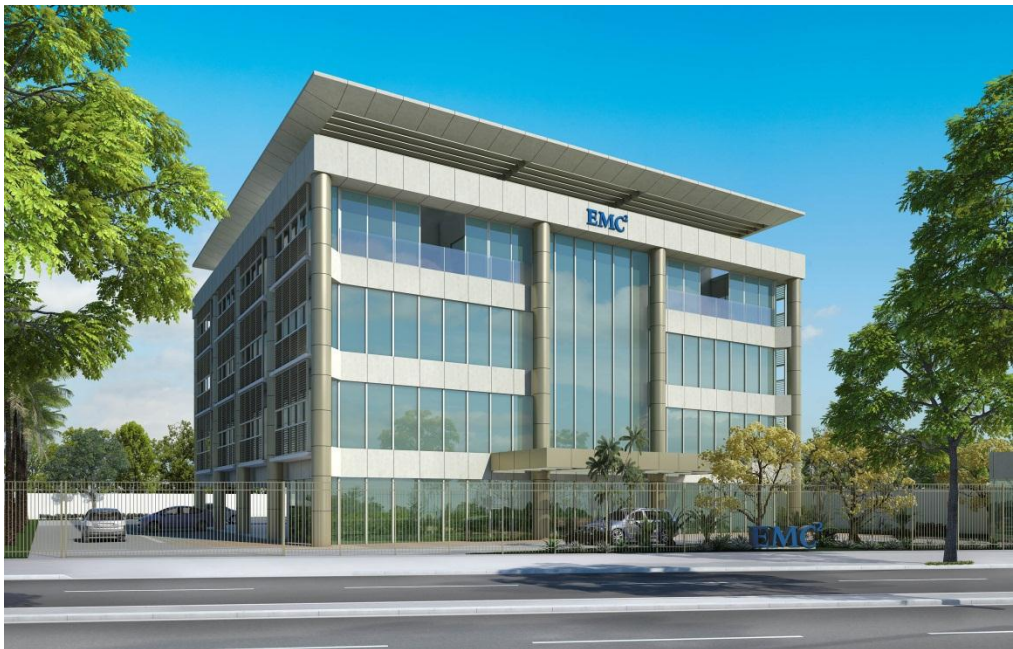
Figura 03 – Perspectiva da Obra
