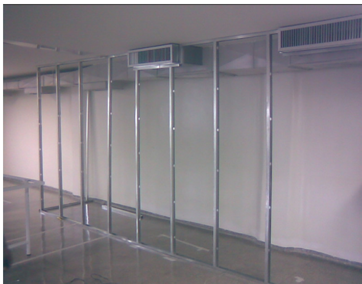
Figura 8 - Estrutura Drywall FONTE: www.larevestimentos.com
