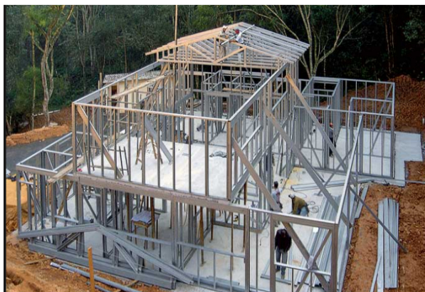
Figura 3 - Steel Frame – Obra Rápida e Limpa FONTE: www.arcoweb.com.br
