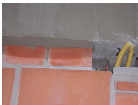
Figura 2 - Detalhe encunhamento recém-executado FONTE:Silva (2007)
