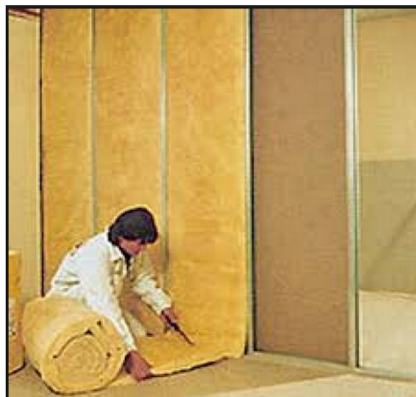
Figura 9 - Execução do Isolamento no Drywall FONTE: www.anovavisaodivisorias.com.br
