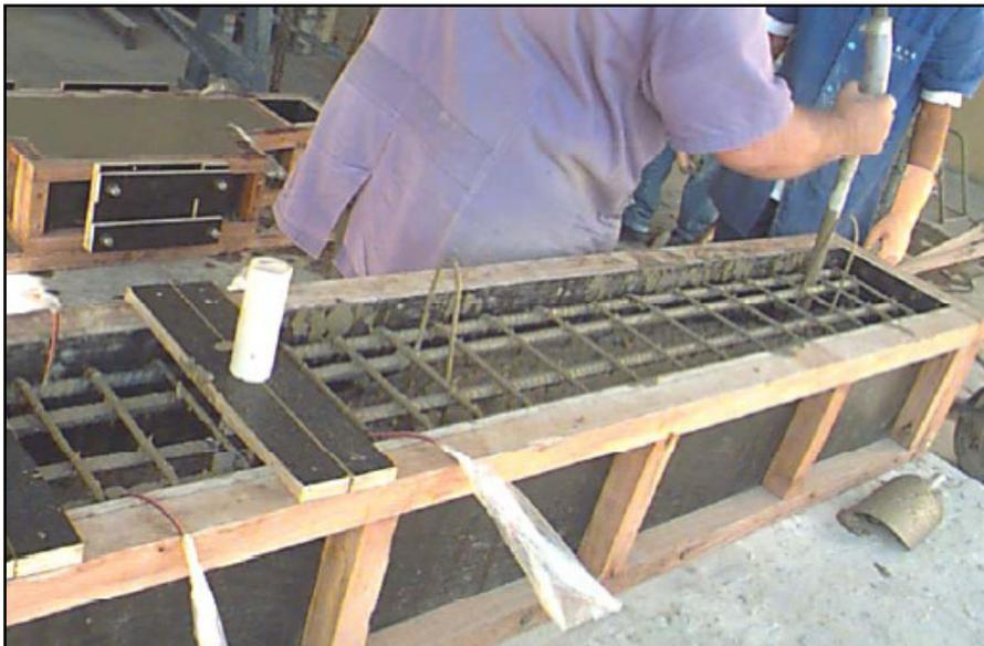
**Figura 2.56 - Concretagem da viga pré-moldada [MIOTTO (2002)]**
