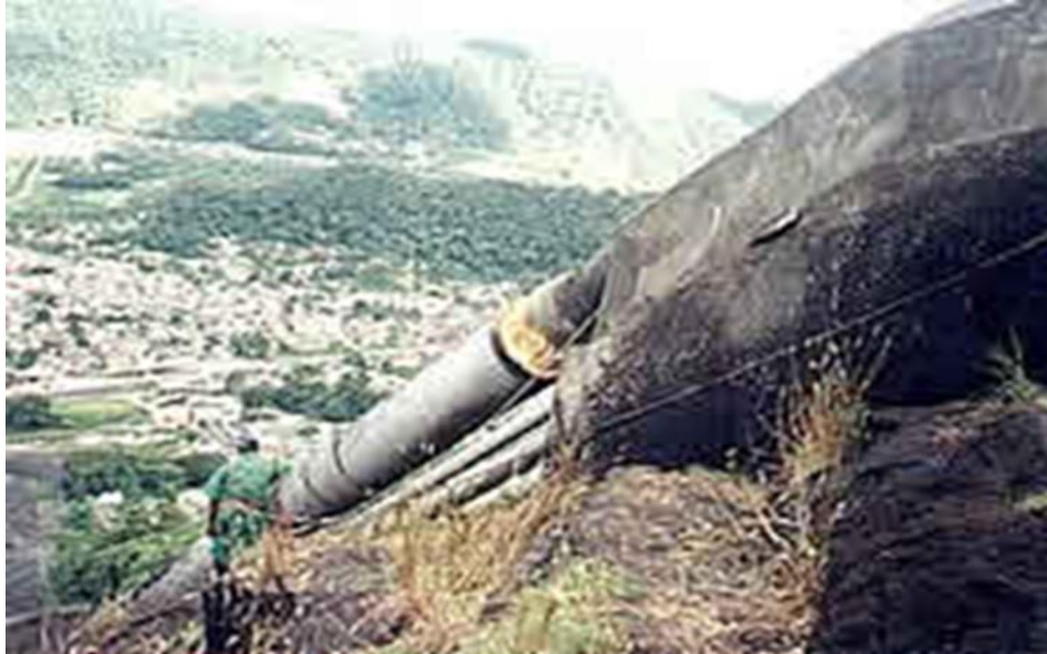
Figura 1 – Oleoduto aparente na encosta da Serra do Mar. Fonte: CETESB.
