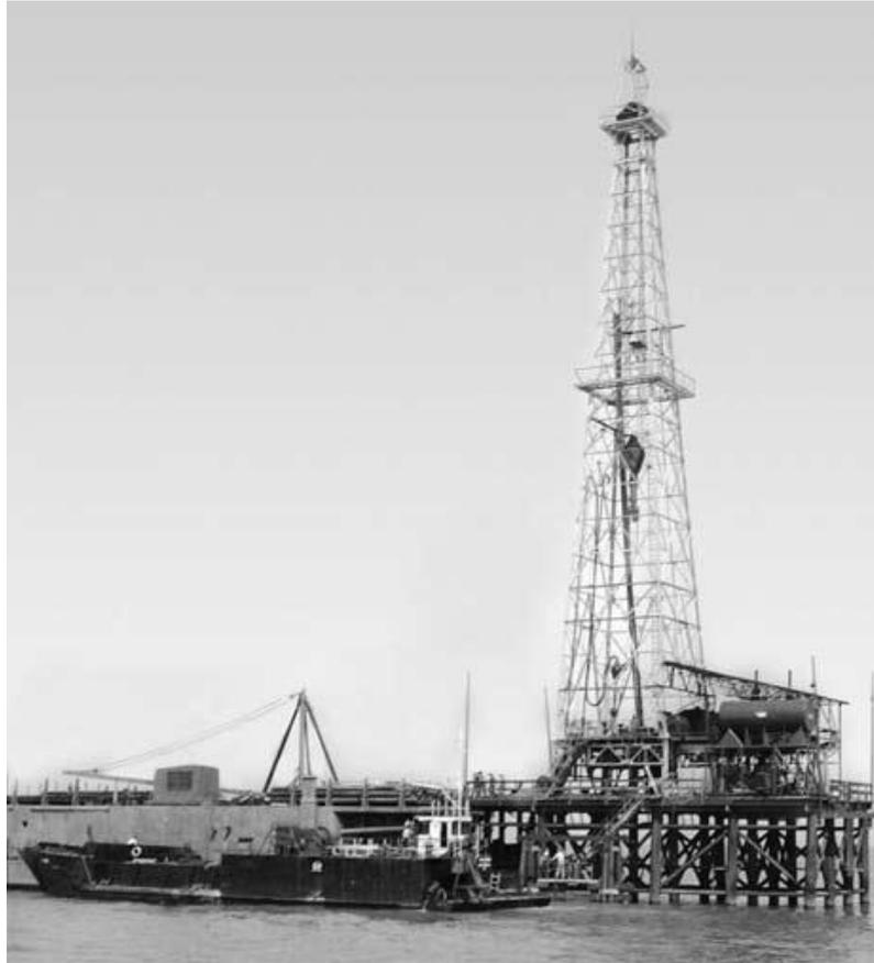
**Figura 4 - “Rig 16” primeira estrutura realmente offshore do mundo**
