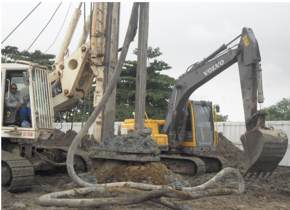
Figura 3.4 – Concretagem de uma estaca na obra estudada.
