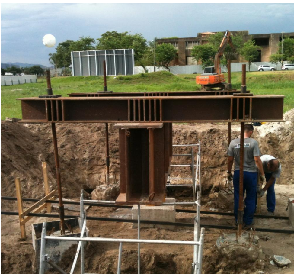
Figura 4.25 – Sistema de reação montado e travado.
