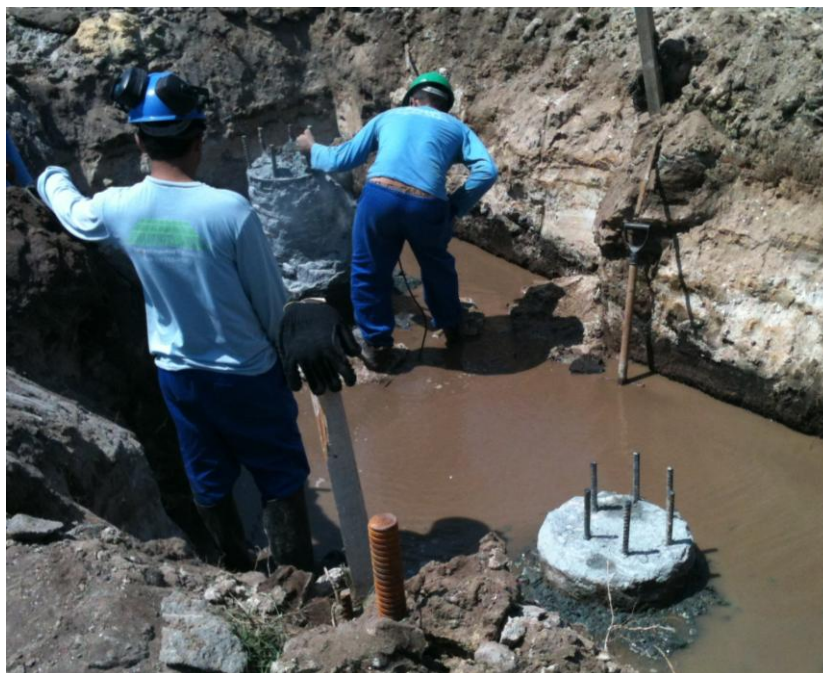
Figura 4.11 – arrasamento das estacas de ensaio.
