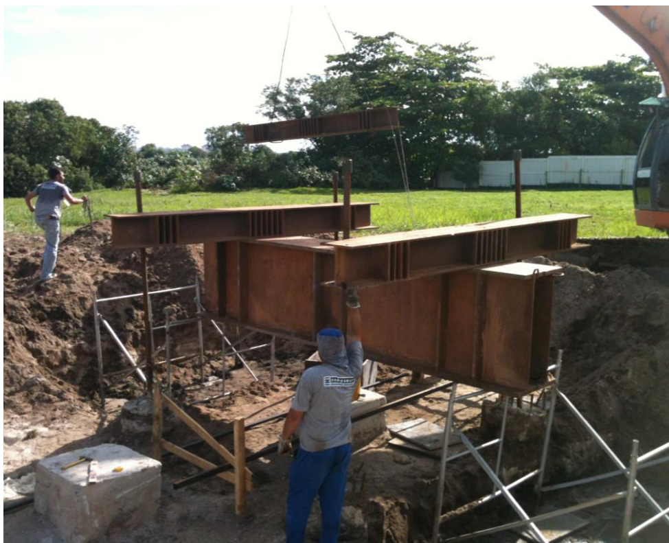
Figura 4.24 – Instante da montagem das vigas de reação.
