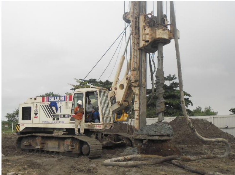
Figura 3.2 – Perfuração do terreno (obra estudada).
