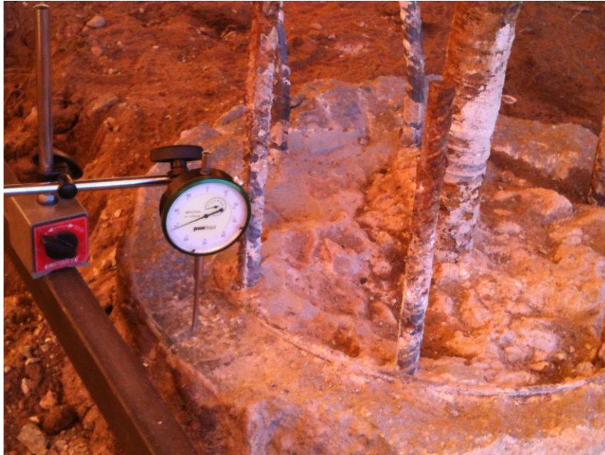
Figura 4.21 – Extensômetro instalado na estaca de reação.
