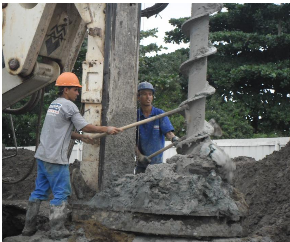
Figura 3.5 – Retirada manual do solo entre as pás da hélice (obra estudada).
