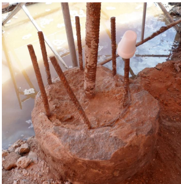
Figura 4.16 – Estaca de reação hélice contínua com tirante injetado.
