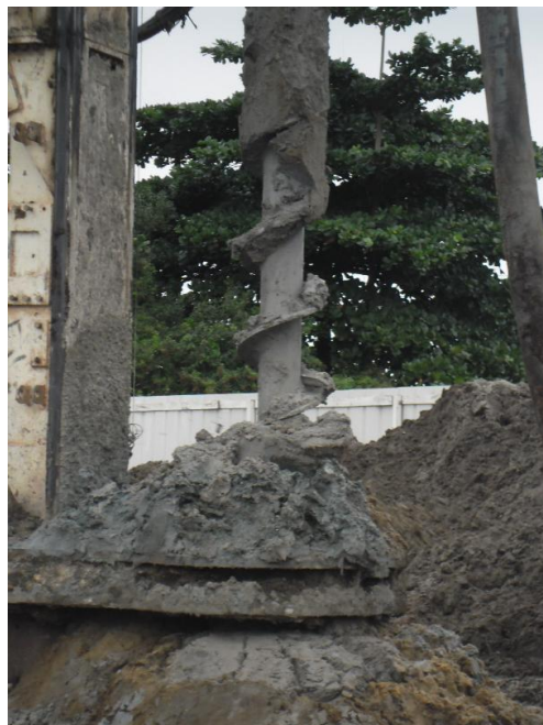
Figura 3.3 – Detalhe da hélice espiral (obra estudada).
