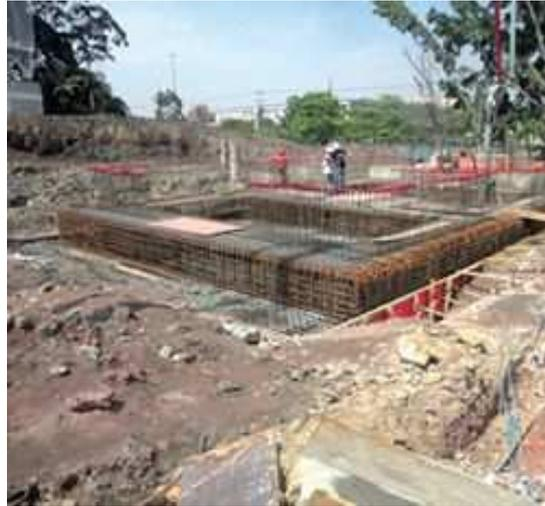
Figura 3 - Execução de bloco de fundação de grandes dimensões do edifício Nova São Paulo (SACHS, 2013)
