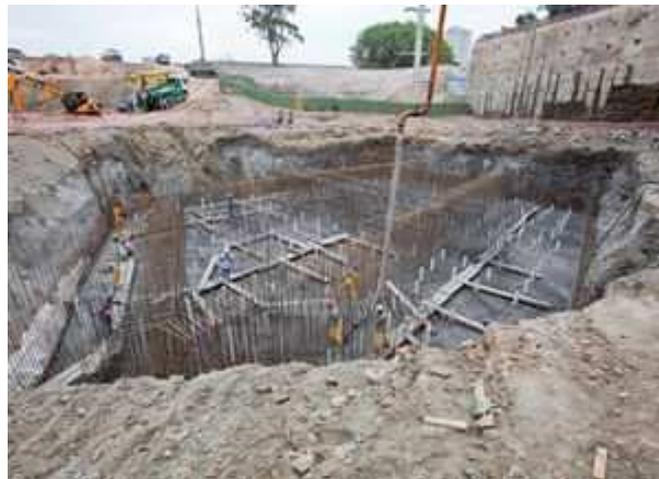
Figura 4 - Execução de sapata com 3600 m<sup>3</sup> e 4,2 m de altura no empreendimento WTorre Morumbi (SACHS, 2013)
