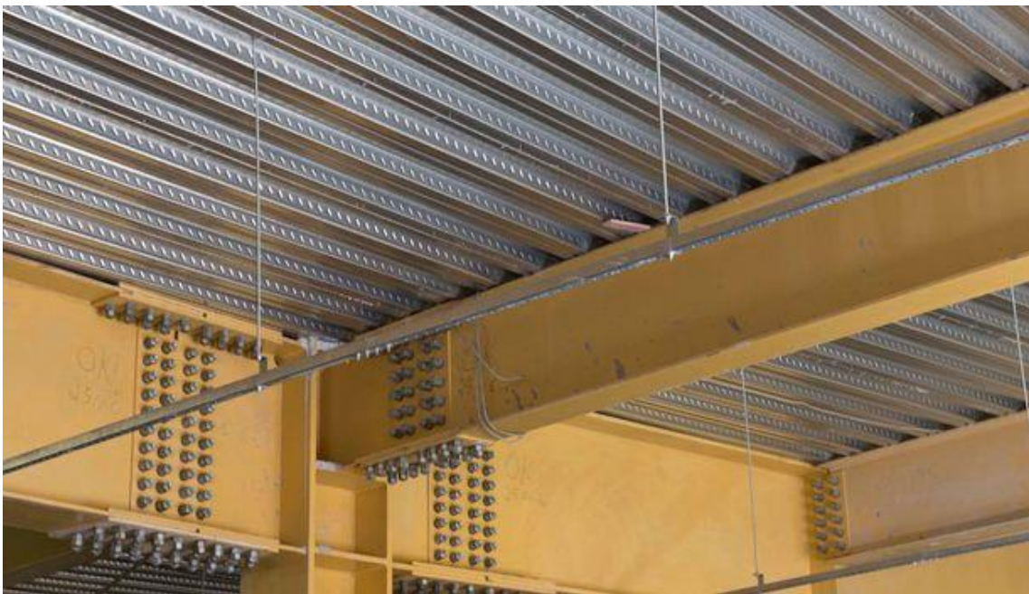
Figura 16 – Lajes em “steel deck”, [6]
