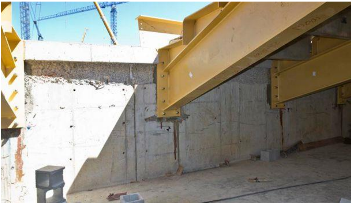
Figura 14 – Ligação da estrutura metálica no contraforte, [6]
