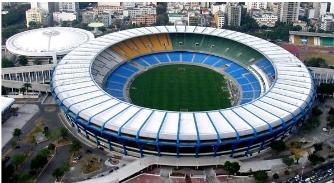
Figura 3 – Vista superior do Maracanã em 2007, [16]
