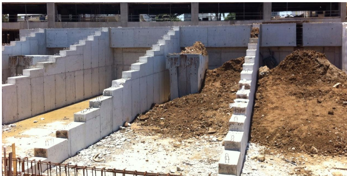
Figura 13 – Contrafortes durante a construção, [5]
