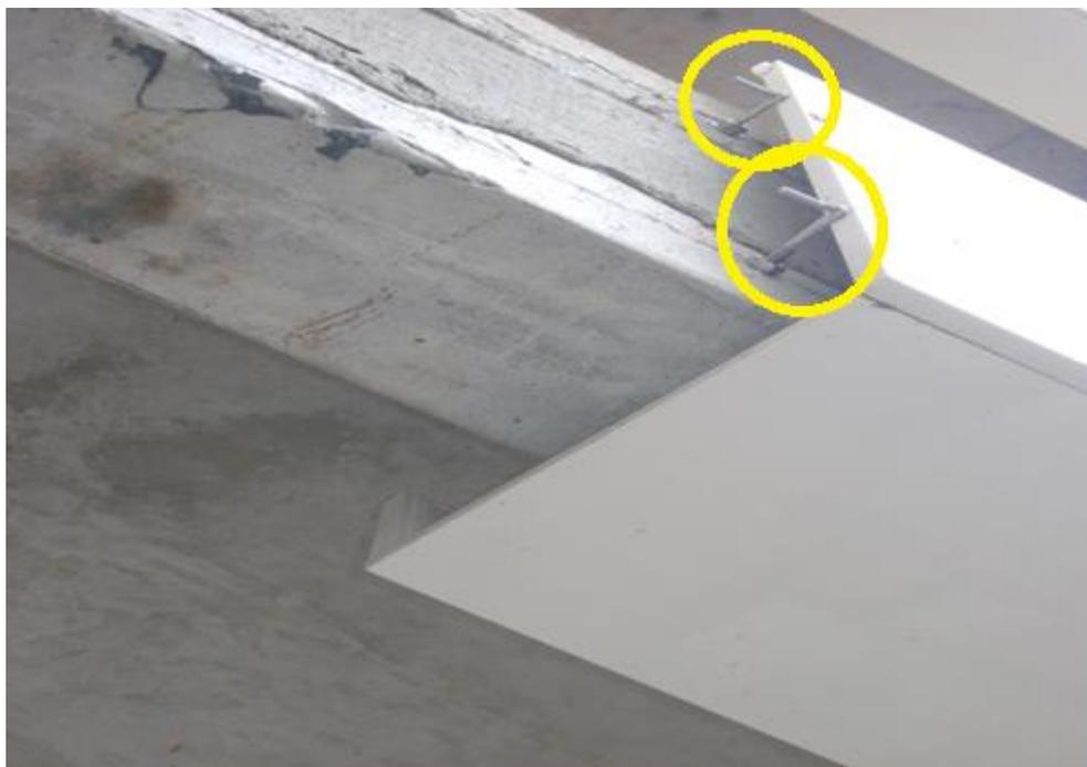
Figura 24: Detalhe de fixação com inserts embutidos na cerâmica.
