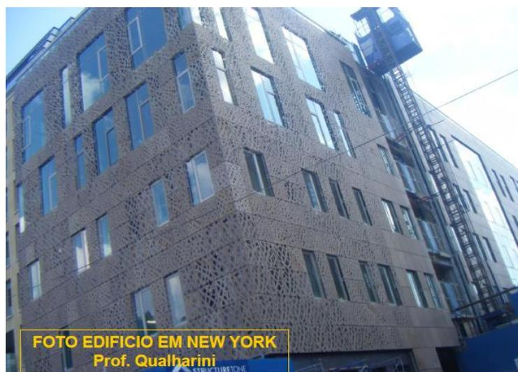
Figura 16: Solução de fachada dupla ventilada com face exterior em elemento vazado
