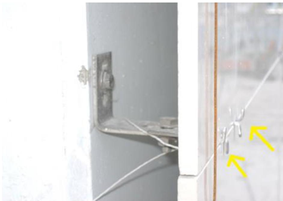
Figura 25: Detalhe da parte interna do grampo metálico
