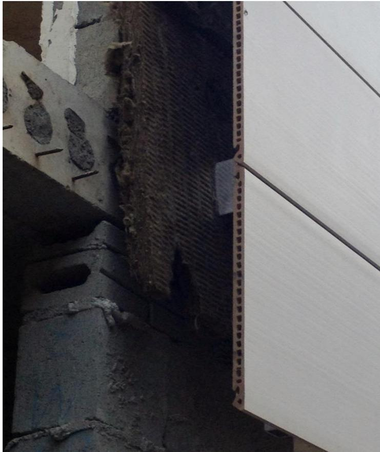
Figura 49: Detalhe do encaixe entre peças na extremidade de um perfil horizontal
