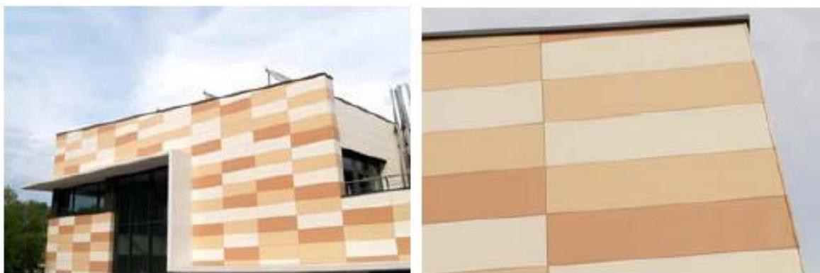
Figura 28:FDV em placas pré-fabricadas de concreto polimérico
