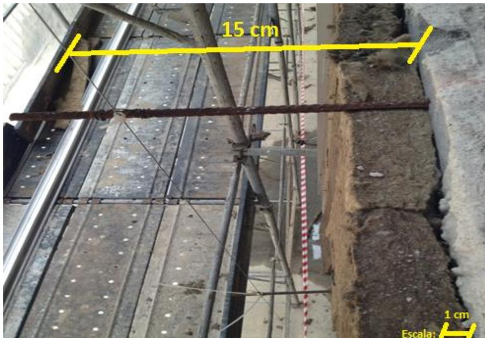
Figura 41- Distanciamento do arame do prumo à alvenaria
