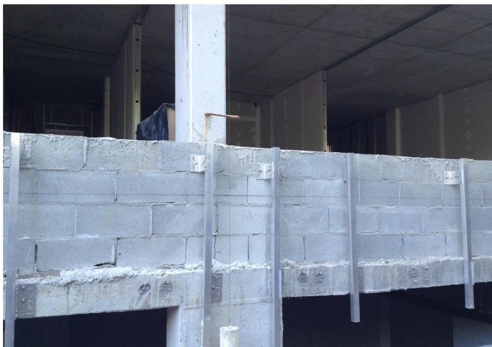
Figura 40: Lançamento de prumos para mapeamento em parte da fachada Sul do bloco exterior.
