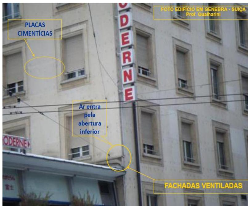
Figura 17: Fachada ventilada com face exterior constituída em material pré-moldado de cimento
