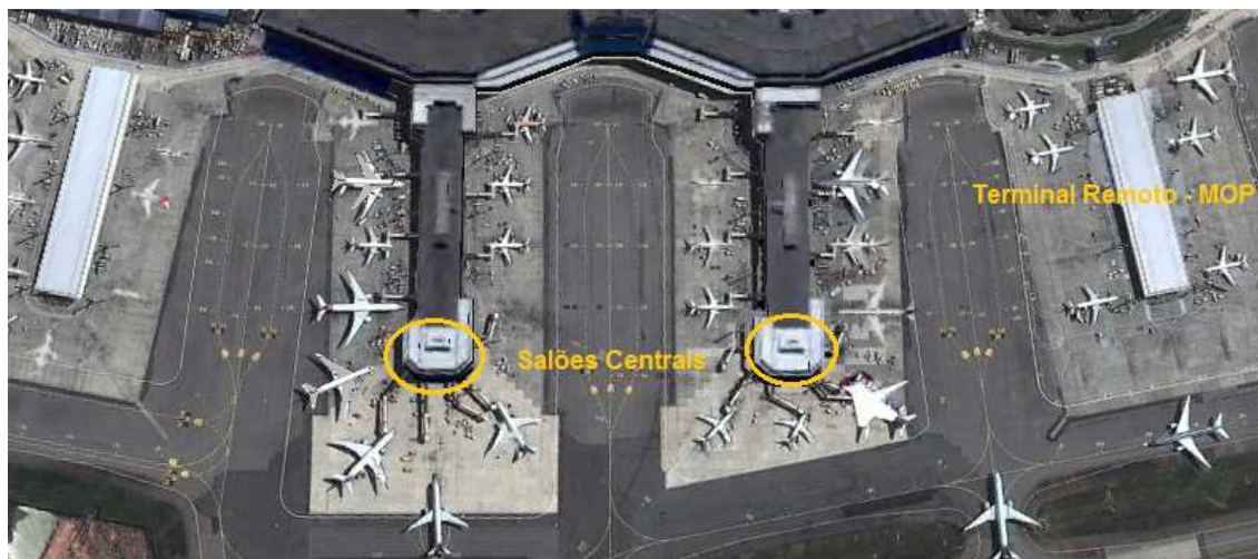
Figura 12: Localização do Terminal Remoto
