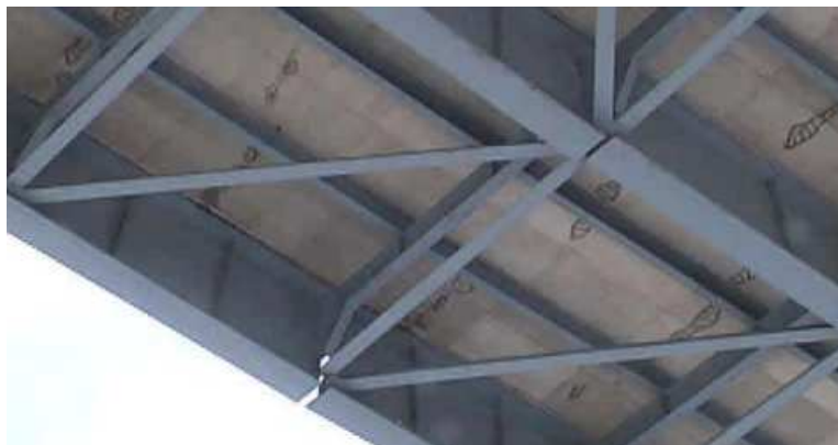
Figura 2.1 – Exemplo de fratura provocada por fadiga em longarina soldada - ponte Hoan (FISHER et al.,2001)
