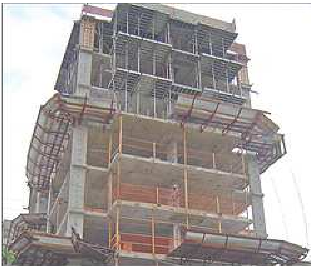
Figura 87 - Edifício executado em laje plana ( http://www.revistatechne.com.br/ , 2013)
