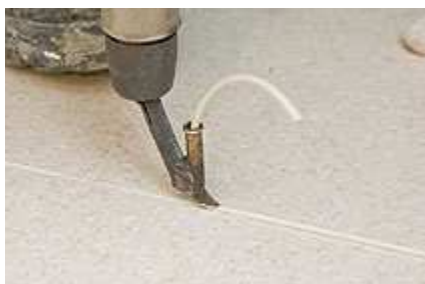
Figura 195 - Aplicação do cordão de solda ( http://www.equipedebra.com.br/ , 2013)
