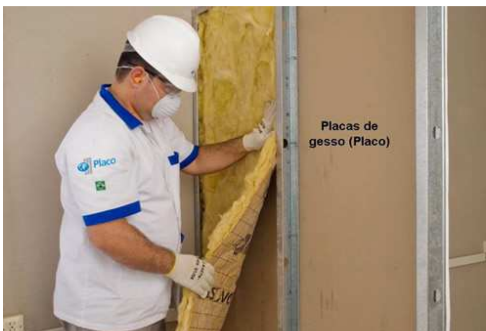
Figura 121 - Colocação de lã de vidro no interior da parede ( http://www.pedreira.com.br/ , 2013)
