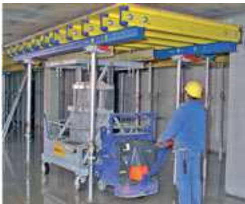
Figura 76 - Desforma e transporte horizontal da mesa voadora ( http://www.revistatechne.com.br/ , 2013)
