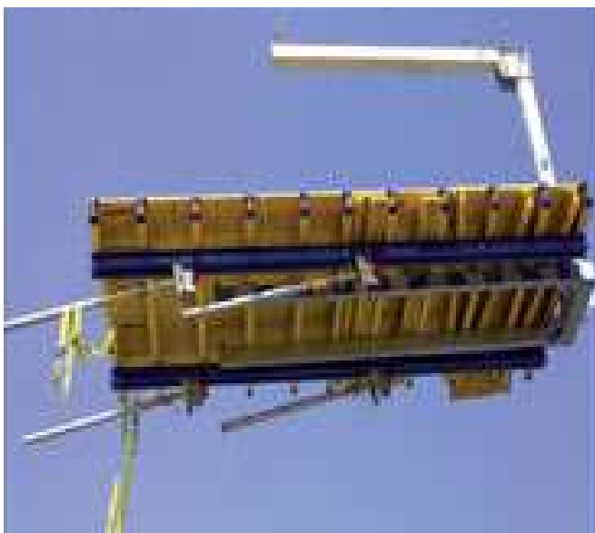
Figura 70 - Transporte vertical da mesa voadora utilizando grua ( http://www.revistatechne.com.br/ , 2013)
