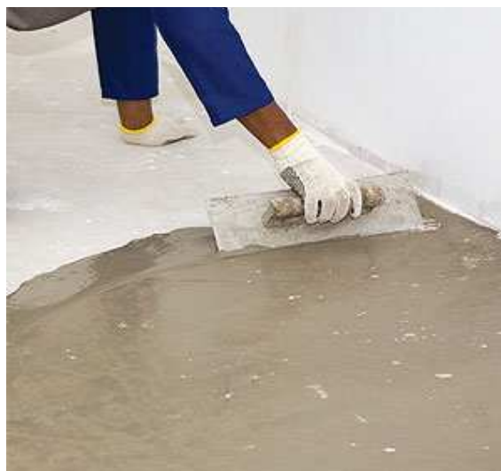
Figura 187 - Aplicação de massa ( http://www.equipedebra.com.br/ , 2013)
