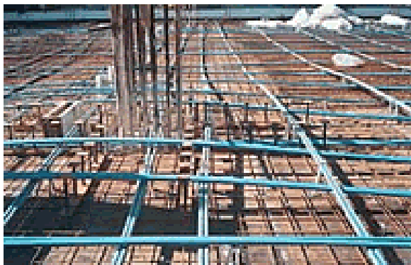
Figura 85 - Edifício executado em laje plana protendida ( http://www.premag.com.br/ , 2013)
