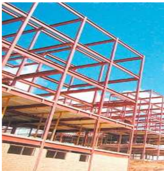
Figura 54 - Estrutura metálica ( http://www.revistafundacoes.com.br/ , 2013)
