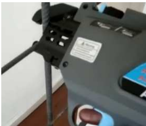
Figura 99 - Execução de amarração ( http://www.foco-is.com/ , 2013)
