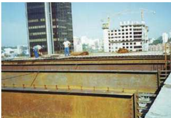
Figura 49 - Estrutura metálica ( http://www.ufsm.br/ , 2013)
