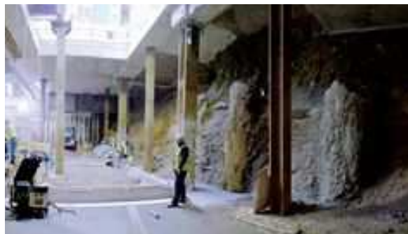
Figura 30 - Escavação confinada ( http://www.revistatechne.com.br , 2012)
