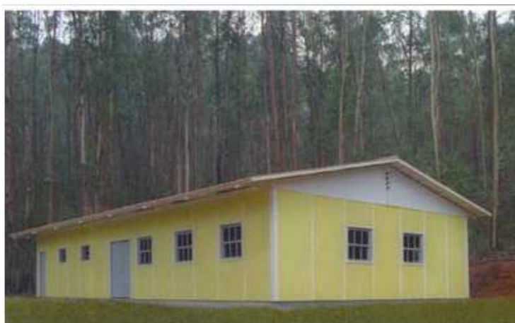
Figura 17 - Instalação provisória pré-fabricada em madeira ( http://www.canteiro.com.br/ , 2012)
