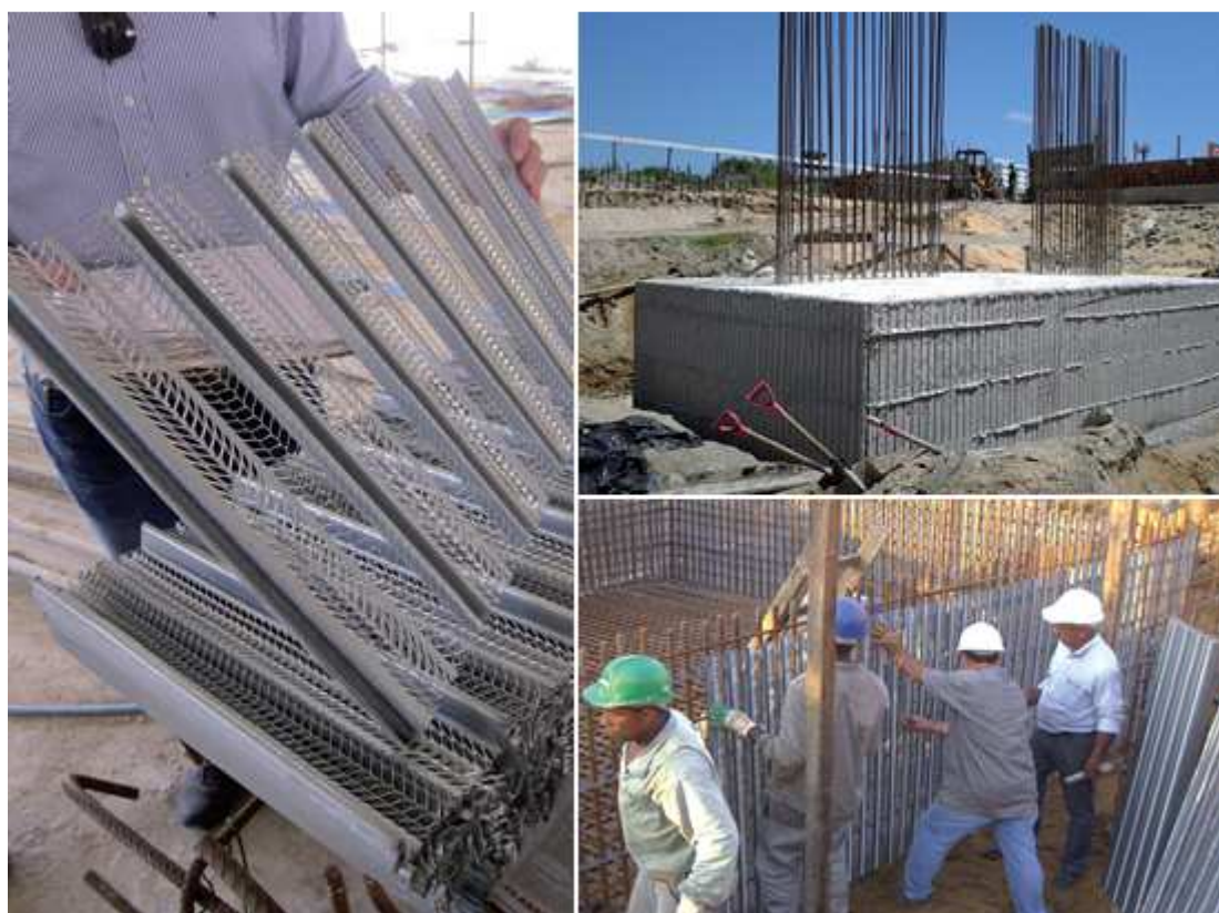
Figura 42 - Utilização de forma Quickjet (Revista Téchne , 2011)
