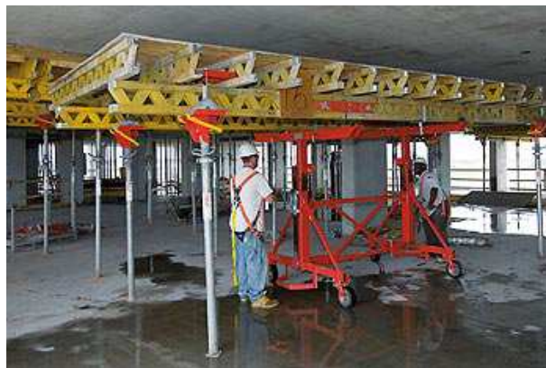
Figura 77 - Desforma e transporte horizontal da mesa voadora ( http://www.peri.de/ , 2013)
