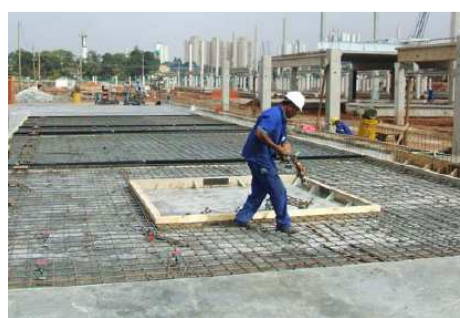
Figura 60 - Pré-moldado - Preparo de formas e armação de placas (IGLESIAS, 2006)
