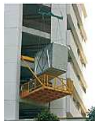
Figura 141 - Posicionamento do banheiro após a execução da laje superior ( http://www.revistatechne.com.br/ , 2013)
