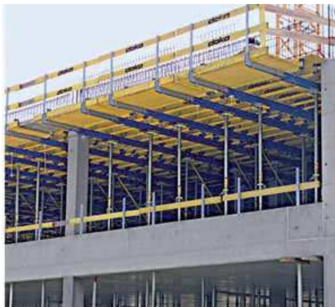
Figura 78 - Colocação das mesas na posição ( http://www.revistatechne.com.br/ , 2013)
