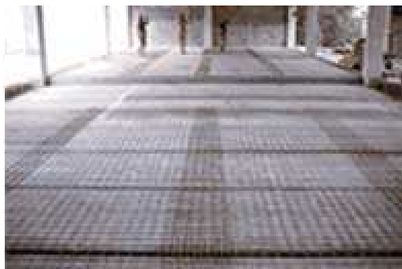
Figura 95 - Transpasse entre as telas ( http://www.cassolprefabricados.com.br/ , 2013)
