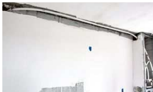
Figura 147 - Execução de curvas sem a utilização de conexões ( http://www.revistatechne.com.br/ , 2013)
