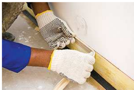
Figura 189 - Colagem do perfil de acabamento do rodapé ( http://www.equipedebra.com.br/ , 2013)
