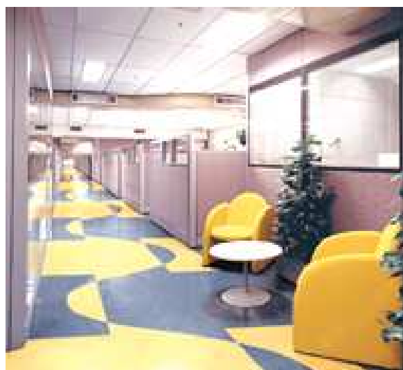
Figura 199 - Utilização de piso vinílico em corredor, alta resistência à abrasão ( http://www.piniweb.com.br/ , 2013)
