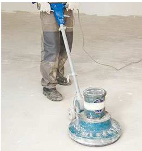
Figura 186 - Lixamento do contrapiso ( http://www.equipedebra.com.br/ , 2013)
