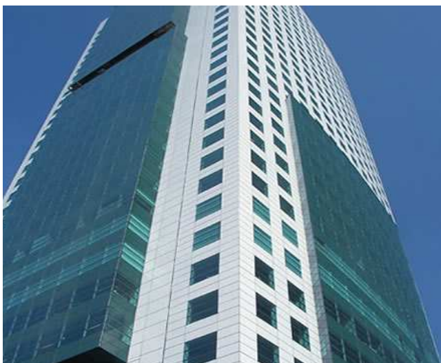
Figura 126 - Fachada cortina ( http://www.aecweb.com.br/ , 2013)
