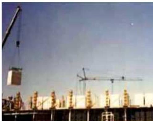
Figura 139 - Posicionamento do banheiro antes da execução da laje superior ( http://www.newformsbrasil.com.br/ , 2013)
