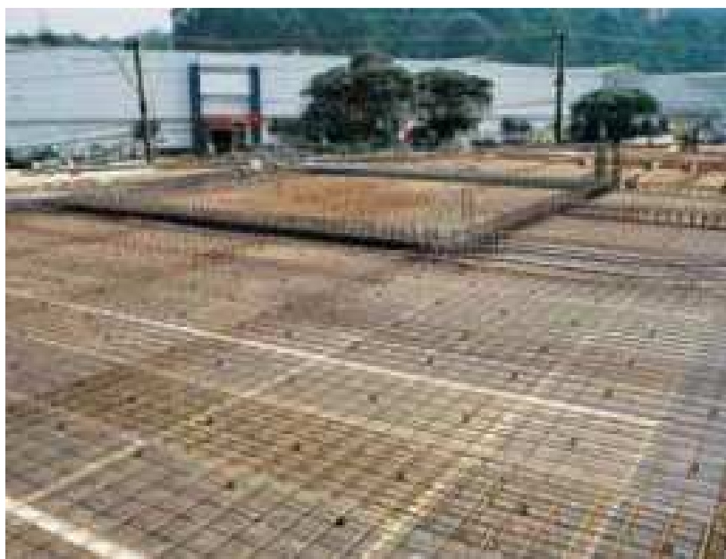
Figura 96 - Laje armada com tela soldada ( http://www.lubrascorte.com.br/ , 2013)
