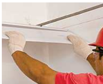
Figura 177 - Encaixe das placas de PVC ( http://www.equipedebra.com.br/ , 2013)
