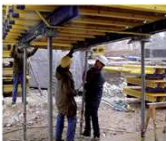
Figura 66 - Montagem das escoras
