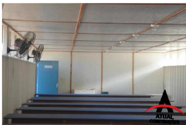
Figura 16 - Refeitório em instalação provisória pré-fabricada ( http://www.atualrio.com/ , 2012)
