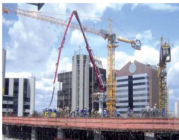
Figura 112 - Mastro de distribuição de concreto tipo placing boom ( http://www.revistatechne.com.br/ , 2013)
