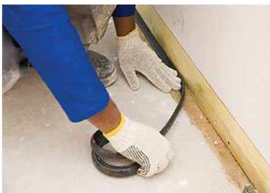
Figura 188 - Colagem do suporte curvo ( http://www.equipedebra.com.br/ , 2013)
