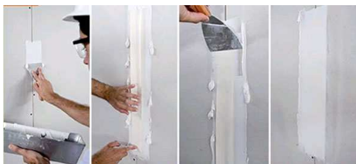
Figura 125 - Tratamento das juntas ( http://www.pedreiro.com.br/ , 2013)
