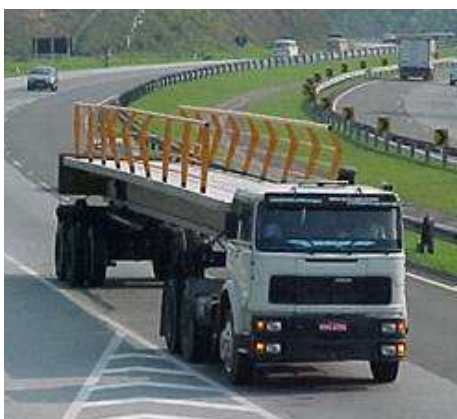
Figura 61 - Transporte de passarela pré-fabricada ( http://www.premag.com.br/ , 2013)
