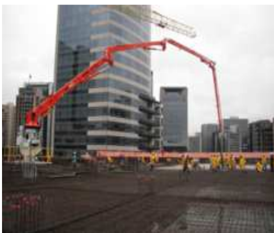
Figura 104 - Concretagem utilizando mastro de distribuição de concreto tipo placing boom ( http://www.lancamix.com.br/ , 2013)
