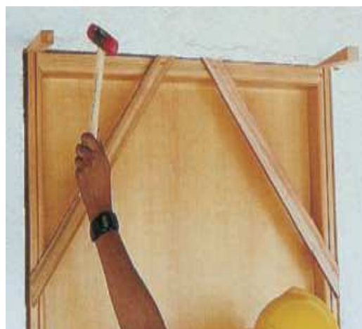
Figura 164 - Posicionamento do kit no vão ( http://www.piniweb.com/ , 2013)
