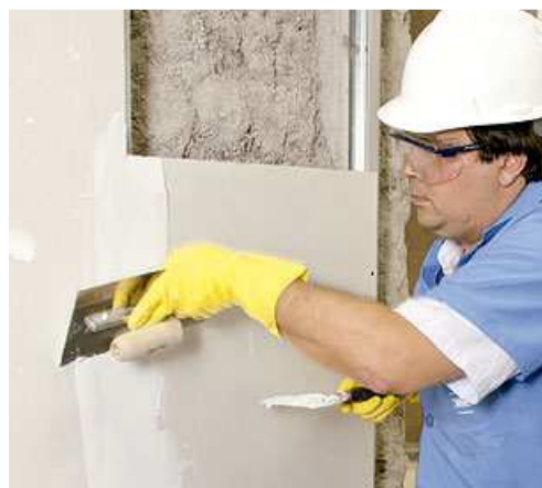
Figura 201 - Revestimento interno utilizando-se gesso acartonado ( http://www.equipedobra.com.br/ , 2013)
