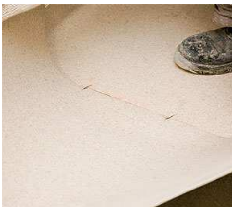
Figura 193 - Colocação da manta ( http://www.equipedebra.com.br/ , 2013)
