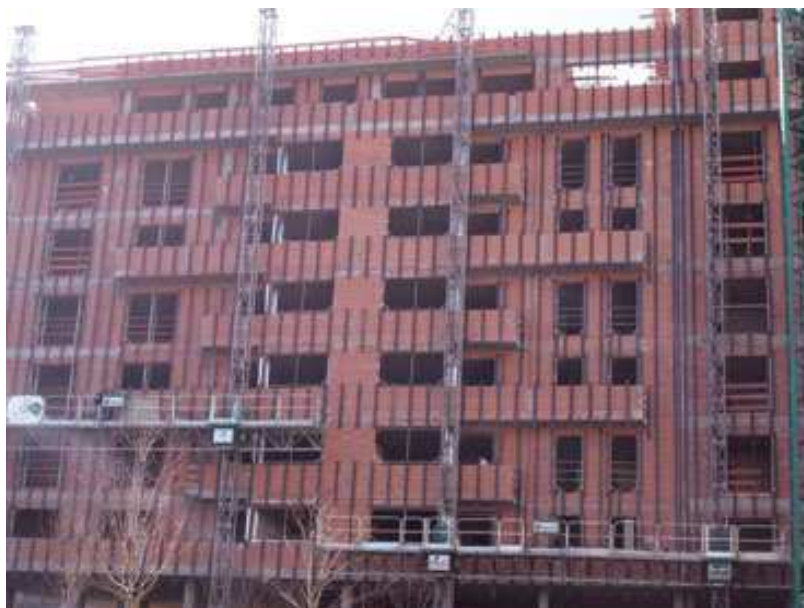
Figura 202 - Estrutura metálica aguardando a colocação do revestimento não aderido ( http://www.revistatechne.com.br/ , 2013)
