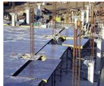
Figura 67 - Posicionamento das mesas na obra
