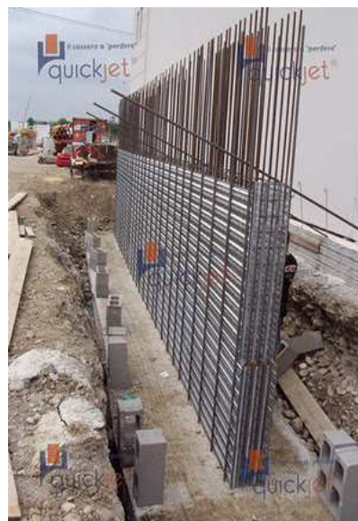
Figura 38 - Utilização de forma Quickjet ( http://www.consultoriaeanalise.com , 2012)
