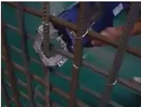
Figura 101 - Execução de amarração ( http://intersilos.com.br/ , 2013)
