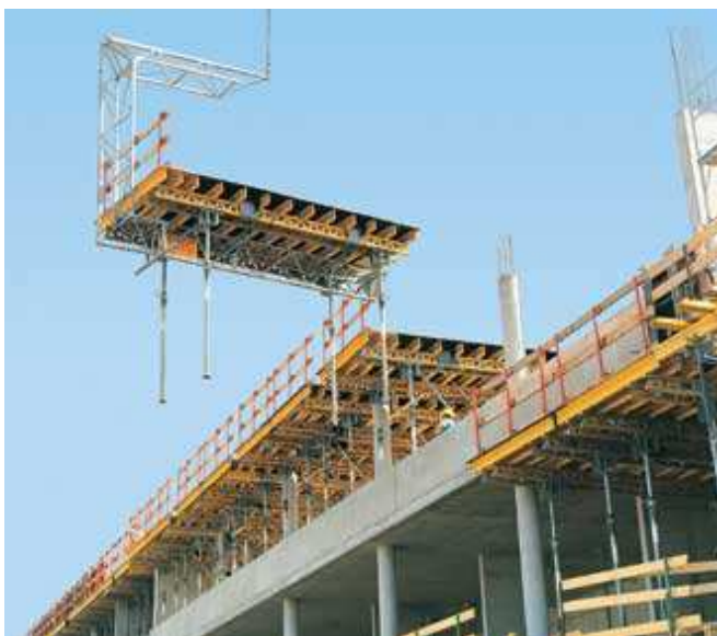
Figura 68 - Transporte vertical da mesa voadora utilizando grua ( http://www.peri.de/ , 2013)
