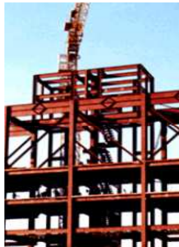
Figura 53 - Estrutura metálica ( http://www.ufsm.br/ , 2013)
