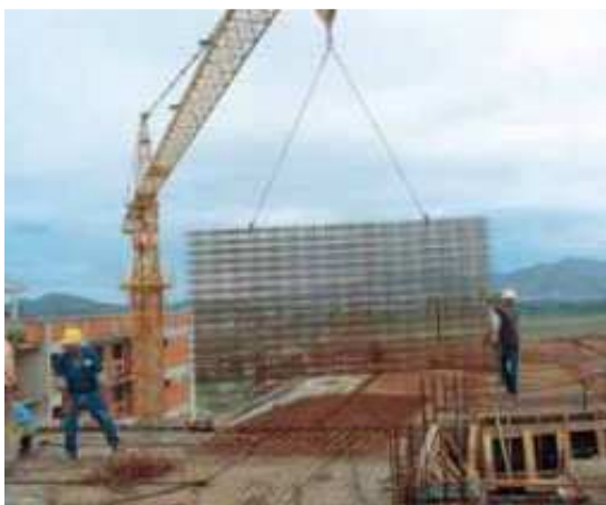
Figura 92 - Transporte de tela soldada ( http://www.lubrascorte.com.br , 2013)
