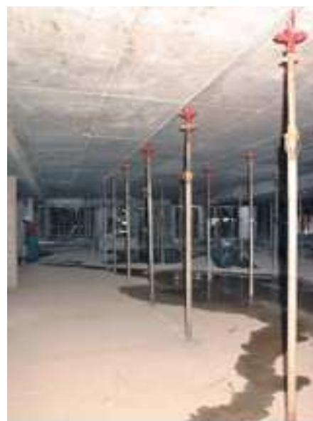
Figura 80 - Escoramento residual com drophead ( http://www.revistatechne.com.br/ , 2013)
