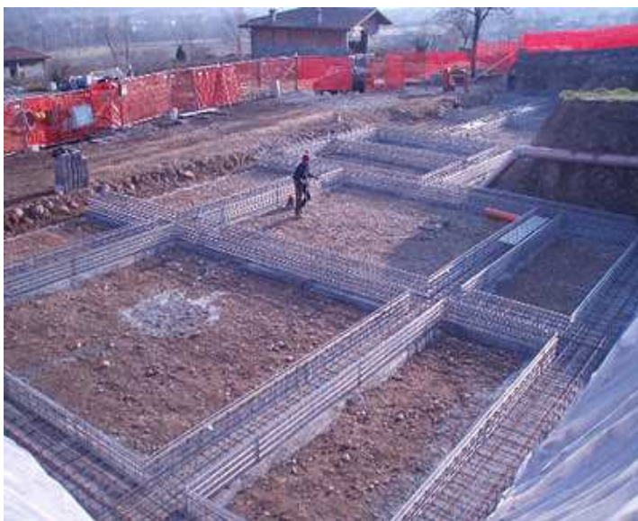
Figura 37 - Utilização de forma Quickjet ( http://www.consultoriaeanalise.com , 2012)
