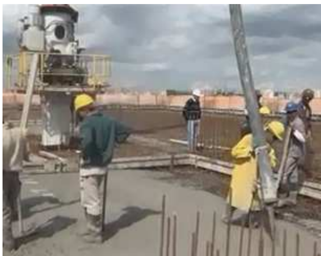
Figura 107 - Não existe tubulação apoiada na laje e apenas um funcionário segura o mangote ( http://www.youtube.com/ , 2013)
