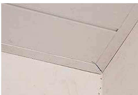
Figura 179 - Cantoneiras das paredes laterais encaixadas ( http://www.equipedebra.com.br/ , 2013)
