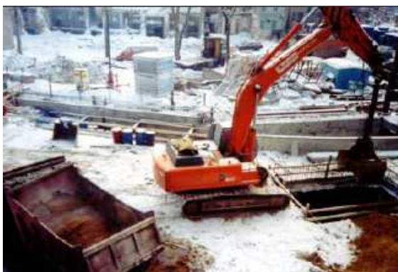
Figura 27 - Retirada de terra ( http://www.yurkevich.ru , 2012)
