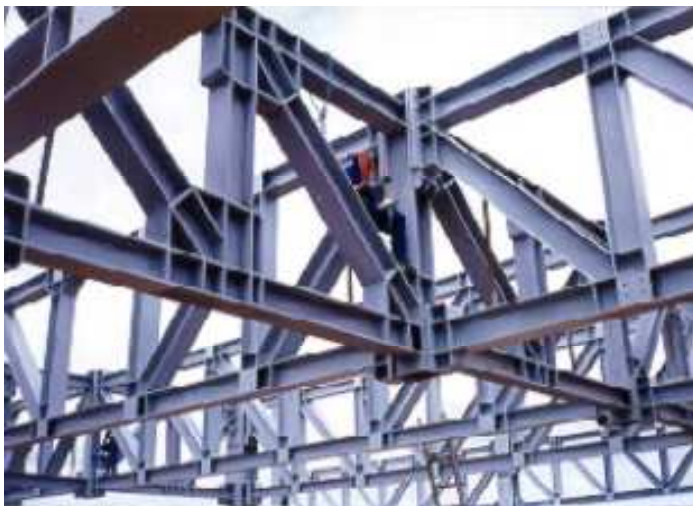
Figura 52 - Estrutura metálica ( http://www.ufsm.br/ , 2013)
