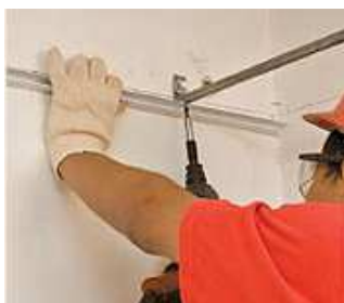
Figura 176 - Fixação das cantoneiras ( http://www.equipedebra.com.br/ , 2013)
