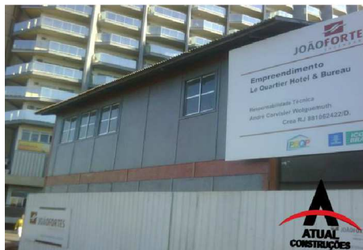
Figura 19 - Escritório em instalação provisória pré-fabricada ( http://www.atualrio.com/ , 2012)
