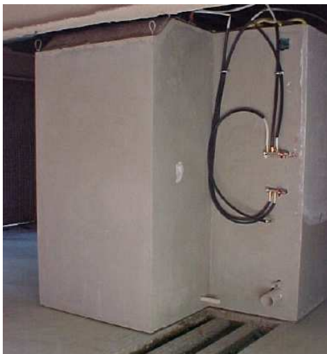
Figura 144 - Banheiro posicionado em seu lugar definitivo aguardando ligação das esperas (LOPES, 2005)
