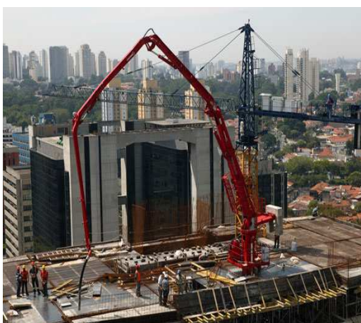
Figura 111 - Mastro de distribuição de concreto tipo placing boom ( http://www.lancamix.com.br/ , 2013)
