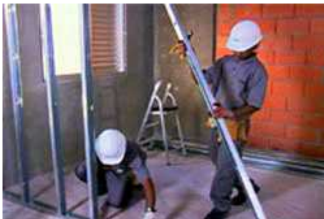
Figura 116 - Posicionamento dos montantes ( http://www.portaldrywall.com.br/ , 2013)
