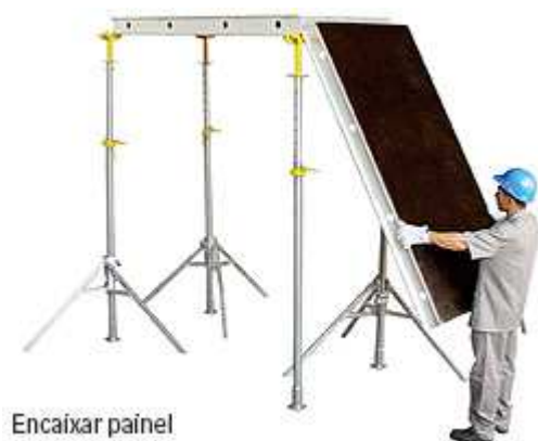
Figura 88 - Encaixe do painel na cabeça das escoras ( http://www.revistatechne.com.br/ , 2013)
