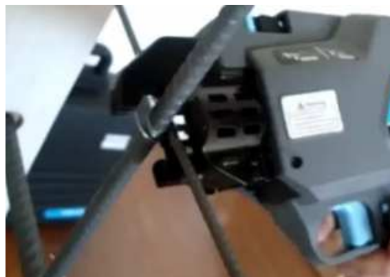
Figura 100 - Execução de amarração ( http://www.foco-is.com/ , 2013)
