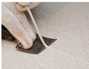
Figura 196 - Desbastamento do cordão de solda ( http://www.equipedebra.com.br/ , 2013)
