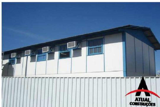
Figura 18 - Escritório em instalação provisória pré-fabricada ( http://www.atualrio.com/ , 2012)
