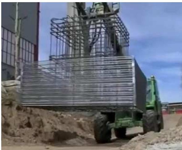
Figura 47 - Transporte de sapata armada ( https://www.youtube.com/ , 2012)
