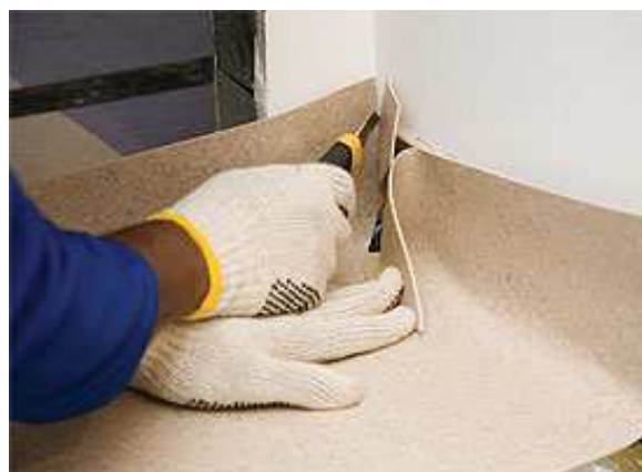
Figura 194 - Corte do excesso da manta ( http://www.equipedebra.com.br/ , 2013)
