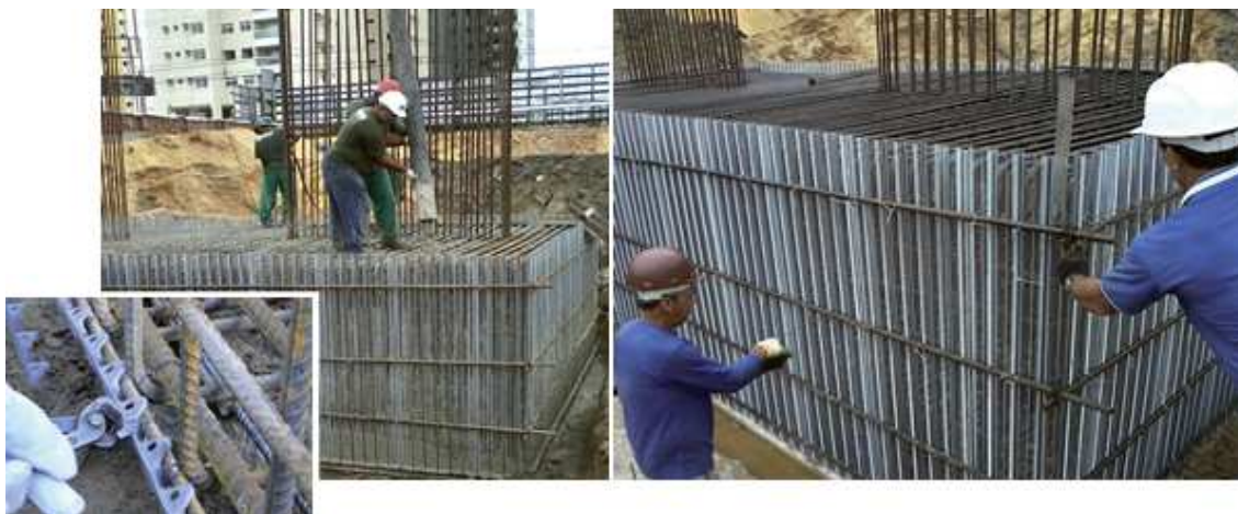
Figura 43 - Montagem de forma Quickjet (Revista Técnica, 2011)
