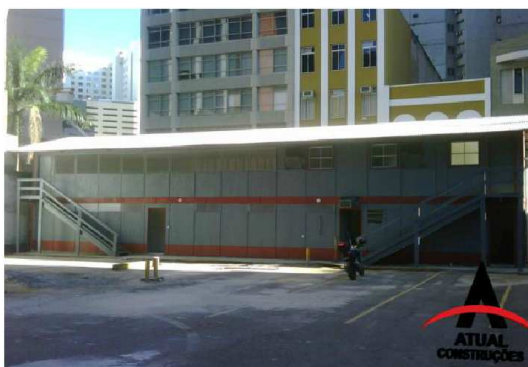
Figura 10 – Instalação provisória pré-fabricada em madeira ( http://www.atualrio.com/ , 2012)
