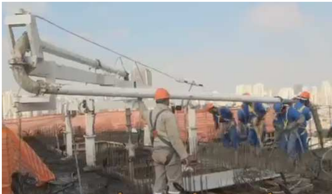
Figura 110 - Mastro de distribuição de concreto tipo spider ( http://www.youtube.com/ , 2013)
