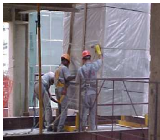
Figura 143 - Posicionamento do banheiro no carrinho para transporte horizontal no pavimento (LOPES, 2005)
