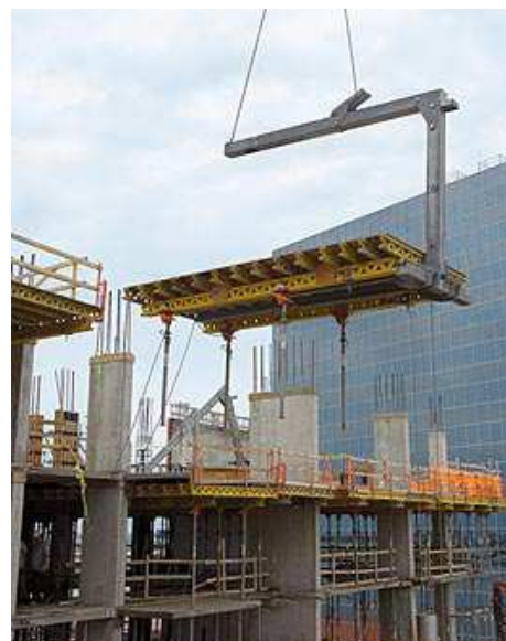
Figura 69 - Transporte vertical da mesa voadora utilizando grua ( http://www.peri.de/ , 2013)
