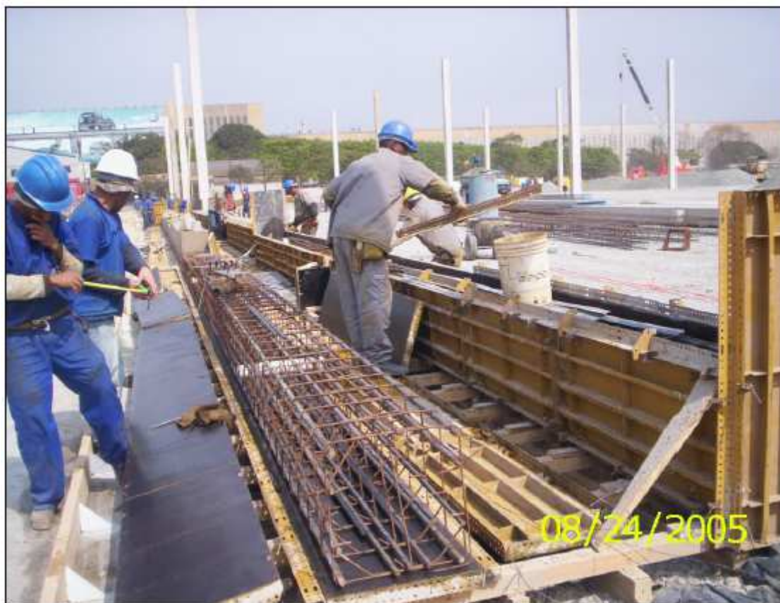
Figura 64 - Preparo da armadura e formas em pré-moldado (IGLESIAS, 2006)
