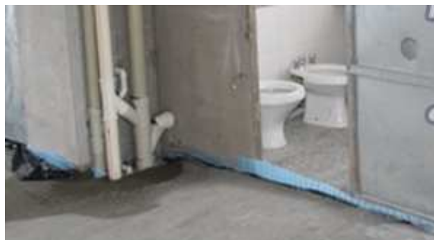
Figura 145 - Execução da ligação das esperas ( http://www.banheiropronto.com.br/ , 2013)
