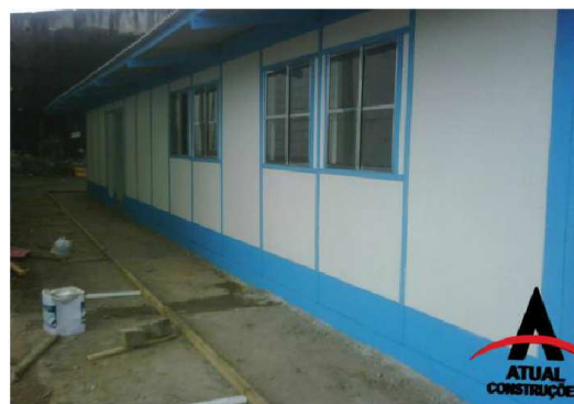
Figura 11 - Instalação provisória pré-fabricada em madeira ( http://www.atualrio.com/ , 2012)
