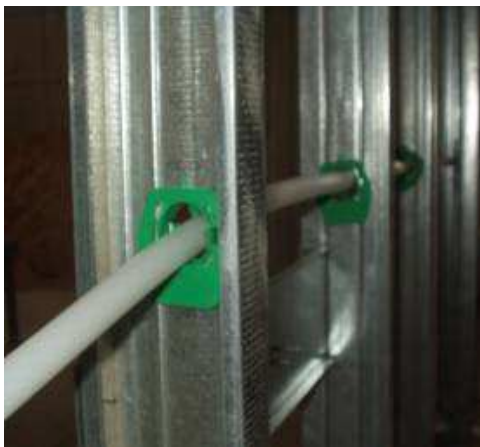
Figura 155 - Passagem do PEX pelos suportes de parede drywall ( http://www.ebah.com.br/ , 2013)
