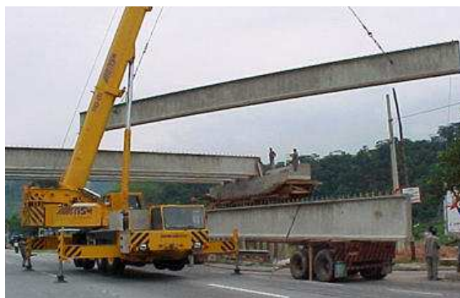
Figura 62 - Lançamento de viga pré-fabricada ( http://www.premag.com.br/ , 2013)
