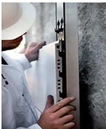
Figura 203 - Encaixe do painel a estrutura metálica ( http://www.revistatechne.com.br/ , 2013)
