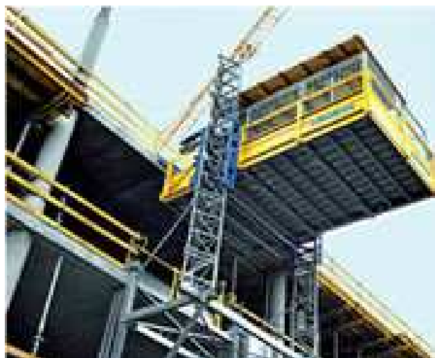
Figura 73 - Transporte vertical da mesa voadora utilizando plataforma elevatória ( http://www.revistatechne.com.br/ , 2013)
