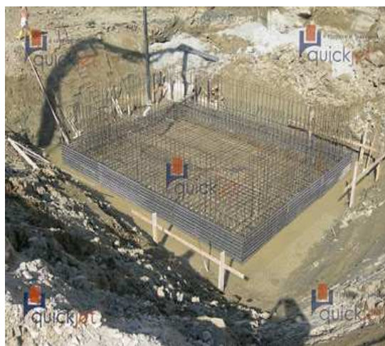
Figura 40 - Utilização de forma Quickjet ( http://www.consultoriaeanalise.com , 2012)
