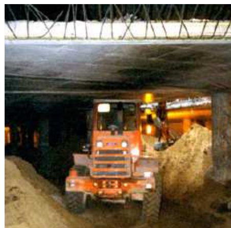
Figura 24 - Escavação confinada ( http://www.yurkevich.ru , 2012)
