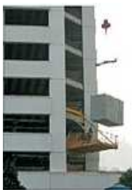
Figura 140 - Posicionamento do banheiro após a execução da laje superior ( http://www.revistatechne.com.br/ , 2013)
