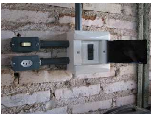
Figura 158 - Instalação aparente utilizando-se tubo ( http://eleteleinfo.blogspot.com.br/ , 2013)
