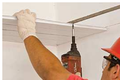
Figura 178 - Lado fêmea da placa é aparafusado ( http://www.equipedebra.com.br/ , 2013)
