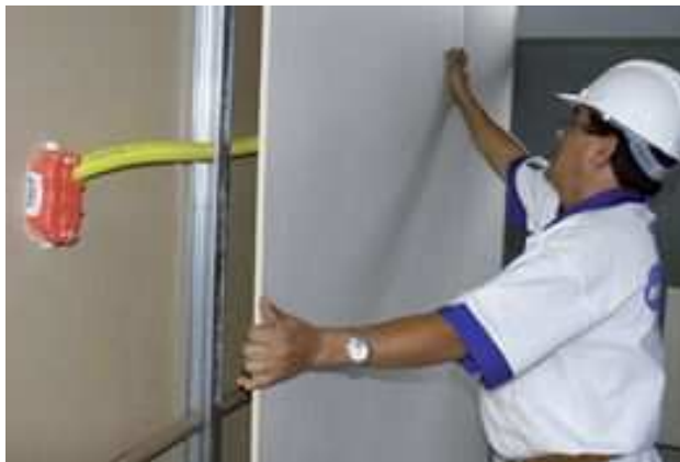
Figura 114 - Fechamento utilizando placa de gesso acartonado ( http://revista.construcomercado.com.br/ , 2013)
