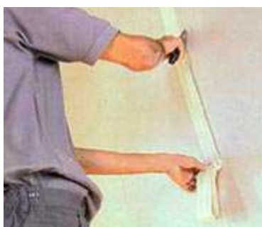
Figura 124 - Tratamento das juntas ( http://www.portaldrywall.com.br/ , 2013)
