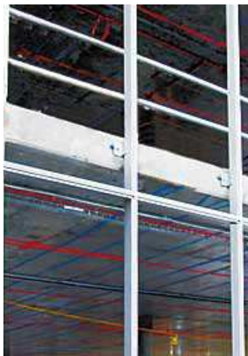
Figura 131 - Estrutura metálica fixada ao edifício ( http://www.halfen.pt/ , 2003)
