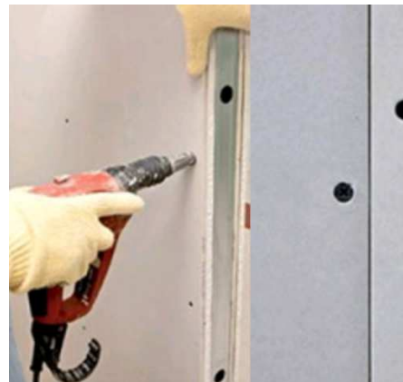
Figura 115 - Fixação de placa de gesso acartonado ( http://www.pedreiro.com.br/ , 2013)
