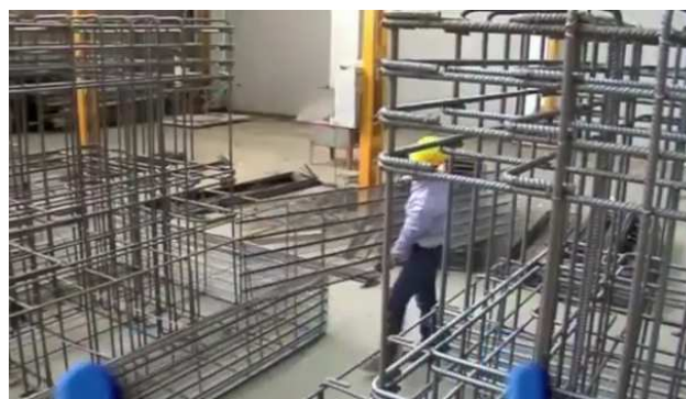
Figura 45 - Montagem feita no depósito ( https://www.youtube.com/ , 2012)
