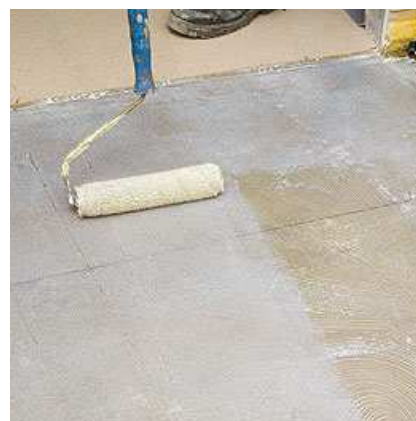
Figura 192 - Espalhamento da cola acrílica ( http://www.equipedebra.com.br/ , 2013)
