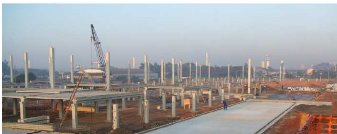
Figura 63 - Montagem de estrutura pré-fabricada (IGLESIAS, 2006)
