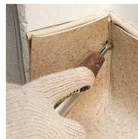
Figura 197 - Acabamento dos cantos dos rodapés ( http://www.equipedebra.com.br/ , 2013)
