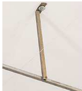
Figura 175 - Instalação estrutura ( http://www.equipedobra.com.br/ , 2013)
