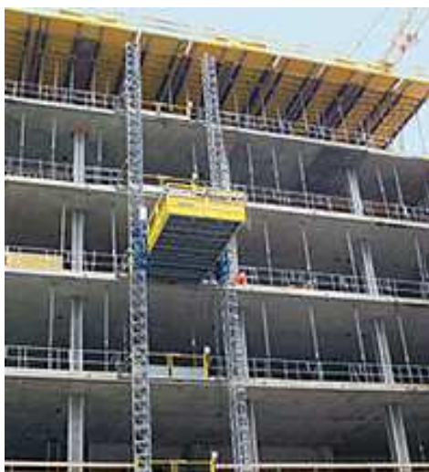
Figura 72 - Transporte vertical da mesa voadora utilizando plataforma elevatória ( http://www.doka.com/ , 2013)
