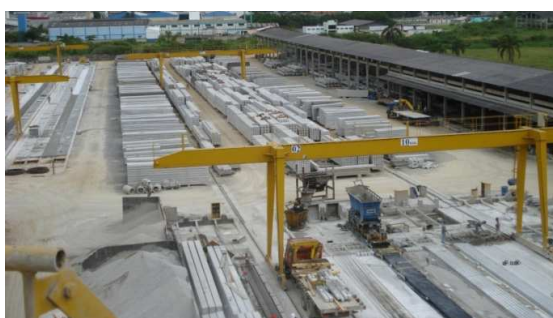
Figura 59 - Pré-Fabricado - Fábrica da Protensul - São José/SC ( http://www.protensul.com.br/ , 2013)
