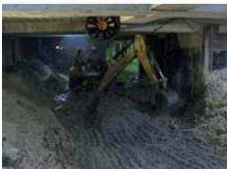
Figura 29 - Escavação confinada ( http://blogdopetcivil.com , 2012)
