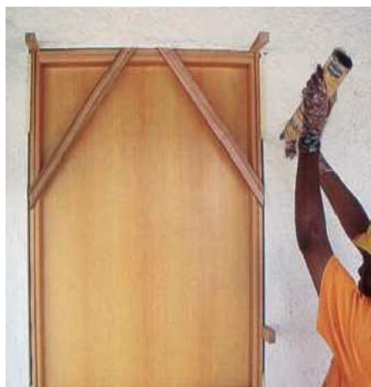
Figura 166 - Fixação utilizando espuma expansiva de poliuretano ( http://www.piniweb.com/ , 2013)
