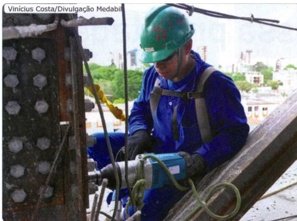
Figura 55 - Execução de ligação entre as peças utilizando parafusos ( http:// www.cbca-acobrasil.org.br , 2013)
