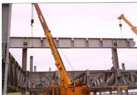
Figura 50 - Montagem de estrutura metálica ( http://www.ufsm.br/ , 2013)
