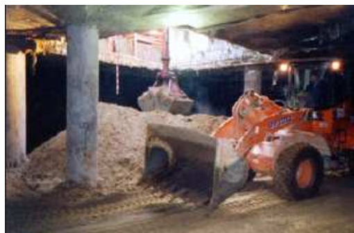
Figura 26 - Escavação confinada ( http://www.yurkevich.ru , 2012)
