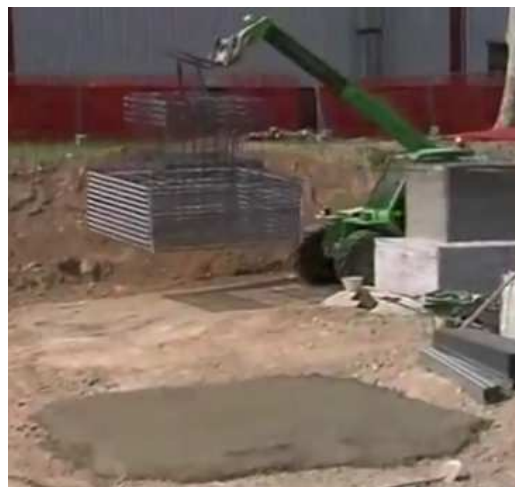
Figura 48 - Transporte de sapata armada ( https://www.youtube.com/ , 2012)
