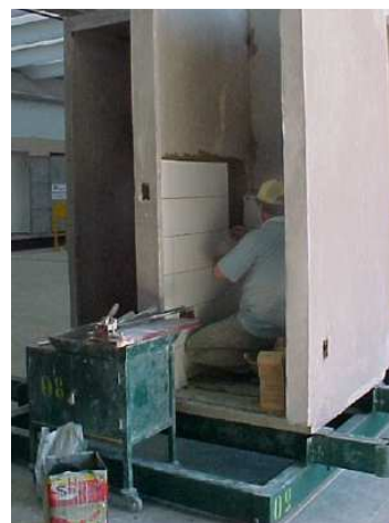
Figura 136 - Execução de revestimento cerâmico de banheiro pronto (LOPES, 2005)
