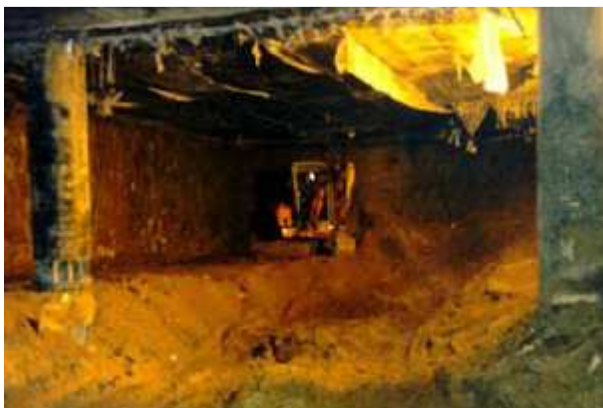
Figura 23 - Escavação confinada ( http://www.yurkevich.ru , 2012)
