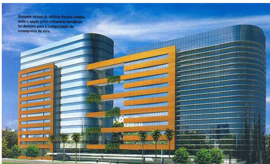
Figura 56 - Edifício em estrutura metálica ( http://www.cbca-acobrasil.org.br/ , 2013)
