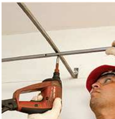
Figura 174 - Instalação estrutura ( http://www.equipedobra.com.br/ , 2013)
