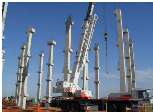
Figura 58 - Montagem da estrutura ( http://www.tranenge.com/ , 2013)
