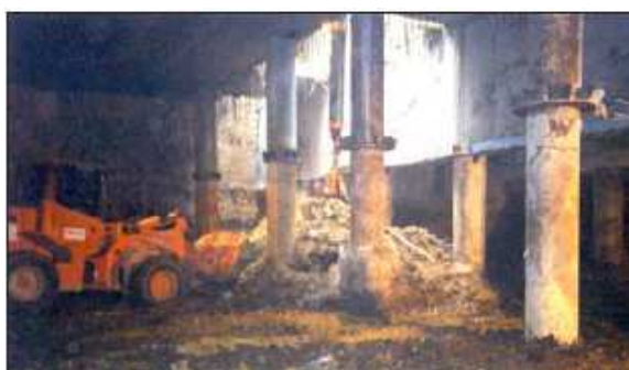
Figura 25 - Escavação confinada ( http://www.yurkevich.ru , 2012)
