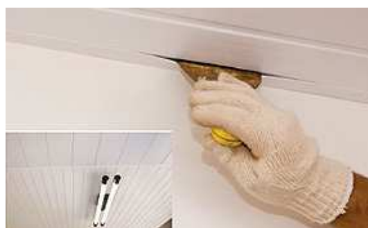
Figura 180 - Colocação da última placa com auxílio de uma espátula ( http://www.equipedebra.com.br/ , 2013)
