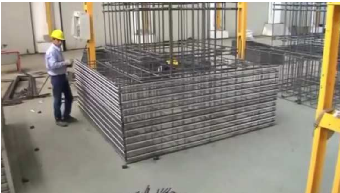
Figura 46 - Montagem feita no depósito ( https://www.youtube.com/ , 2012)
