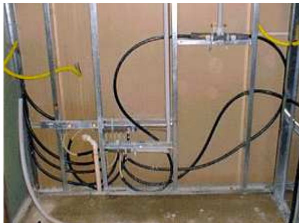
Figura 156 - Instalação do PEX em parede de drywall ( http://www.metlica.com.br/ , 2013)
