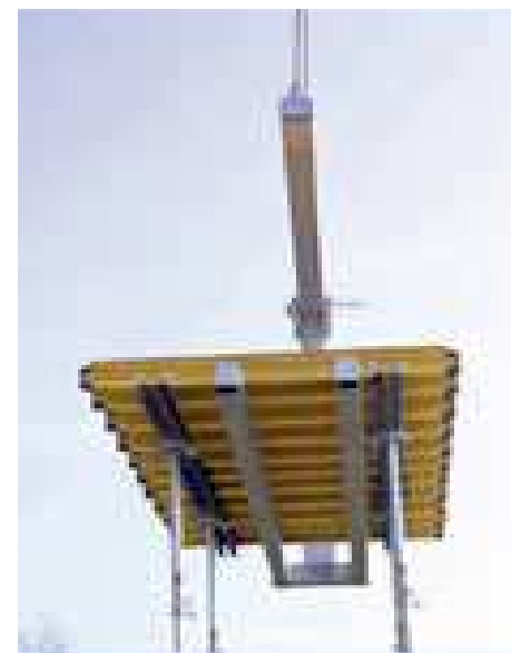
Figura 71 - Transporte vertical da mesa voadora utilizando grua ( http://www.revistatechne.com.br/ , 2013)
