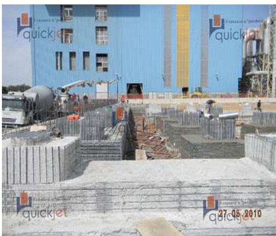
Figura 39 - Utilização de forma Quickjet ( http://www.consultoriaeanalise.com , 2012)
