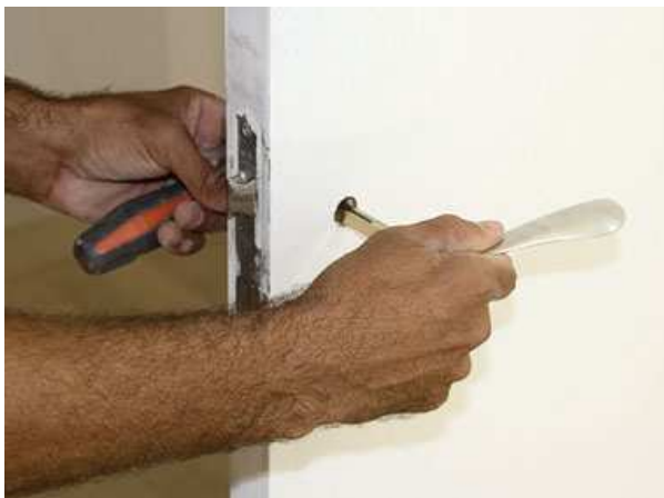
Figura 167 - Colocação da maçaneta ( http://www.revistatechne.com.br/ , 2013)
