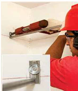
Figura 173 – Instalação estrutura ( http://www.equipedobra.com.br/ , 2013)
