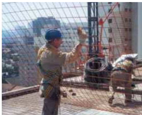
Figura 93 - Colocação de tela soldada em sua posição ( http://www.lubrascorte.com.br , 2013)
