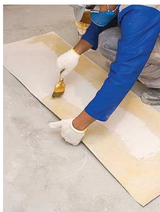
Figura 191 - Aplicação de cola de contato na manta ( http://www.equipedebra.com.br/ , 2013)
