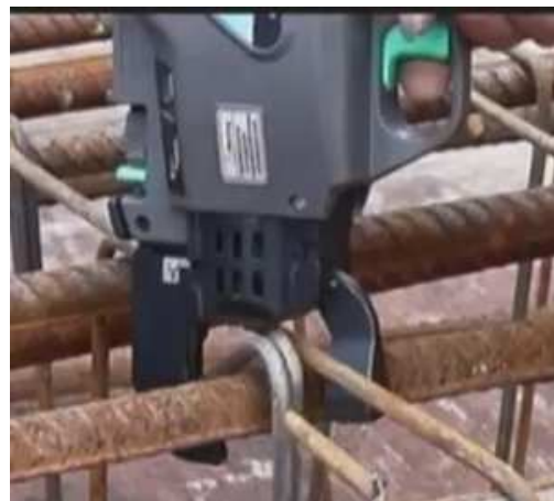
Figura 102 - Execução de amarração ( http://www.youtube.com/ , 2013)
