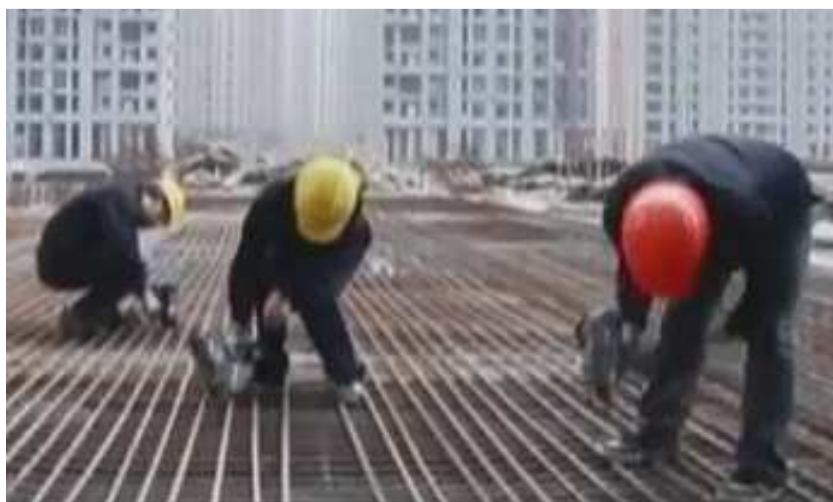
Figura 103 - Execução de amarração de laje ( http://www.youtube.com/ , 2013)
