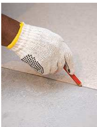
Figura 190 - Marcação do posicionamento da manta ( http://www.equipedebra.com.br/ , 2013)
