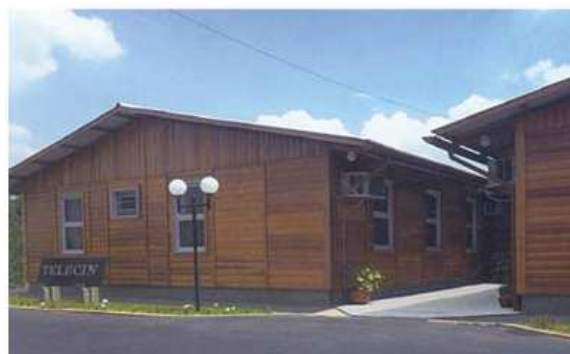
Figura 13 - Instalação provisória pré-fabricada em madeira ( http://www.canteiro.com.br/ , 2012)
