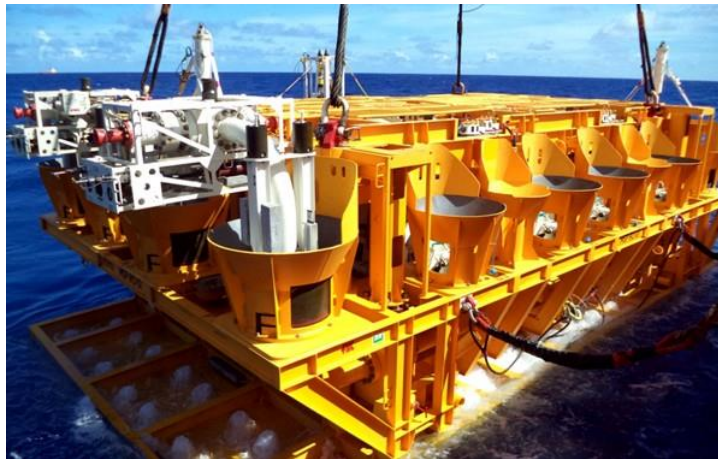
Figura 3.2: Manifold. Fonte Petrobras
