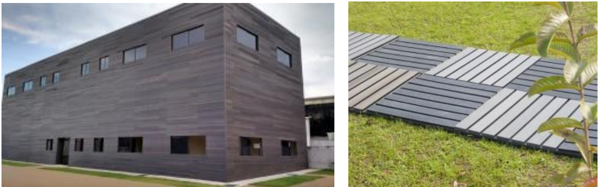
Figura 53: substituição da madeira comum por madeira plástica
