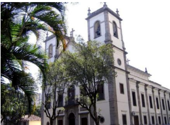
Figura 10: Exterior da Paróquia
