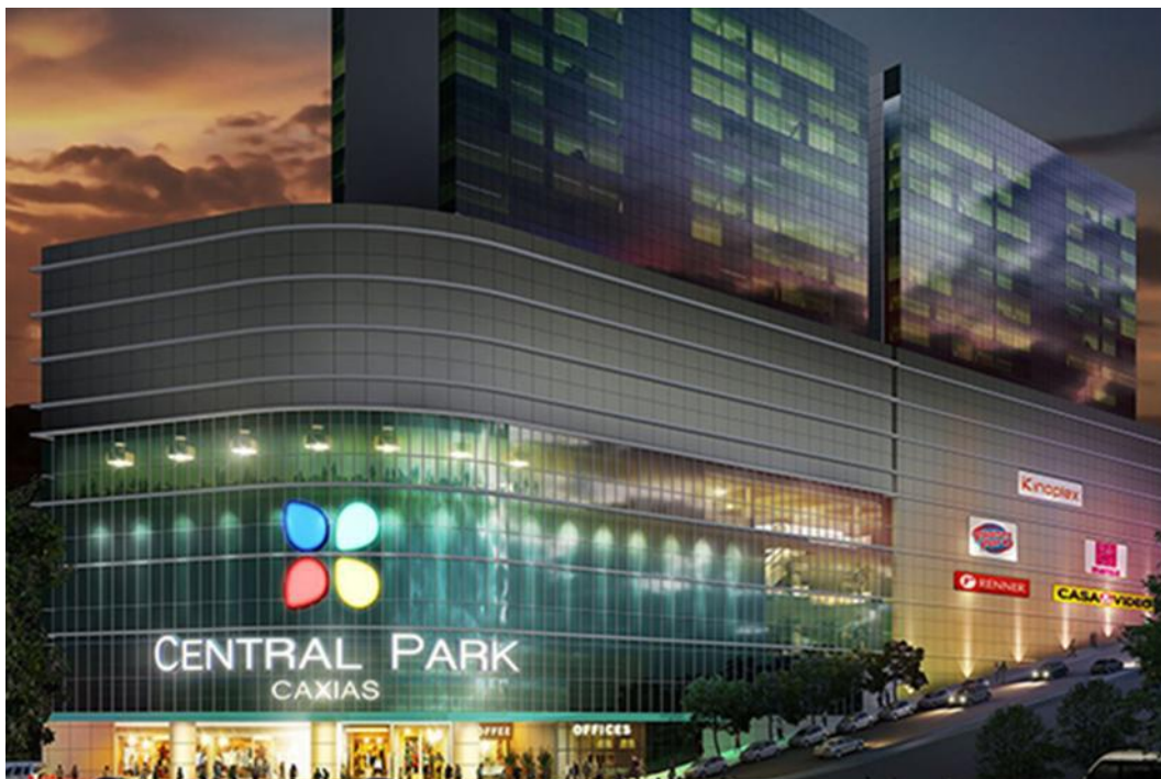
Imagem da vista principal do empreendimento retirada do site da ABL Shopping 34
