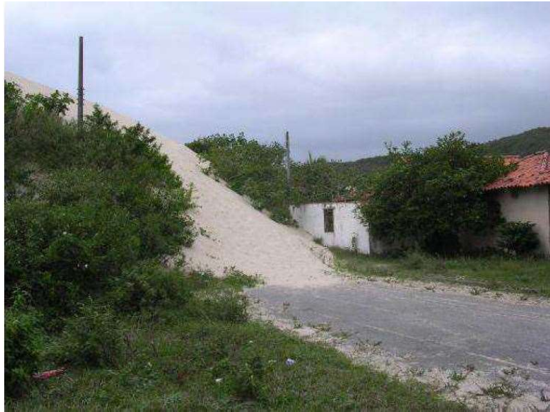
Figura 1 – Soterramento de via e casas por duna em loteamento em Cabo Frio (RJ).
