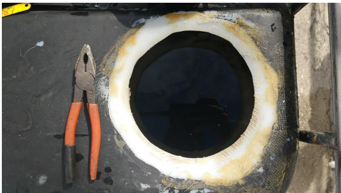
Figura 42: Leves irregularidades na execução do recorte do tampo (Fonte: Acervo do Autor)
