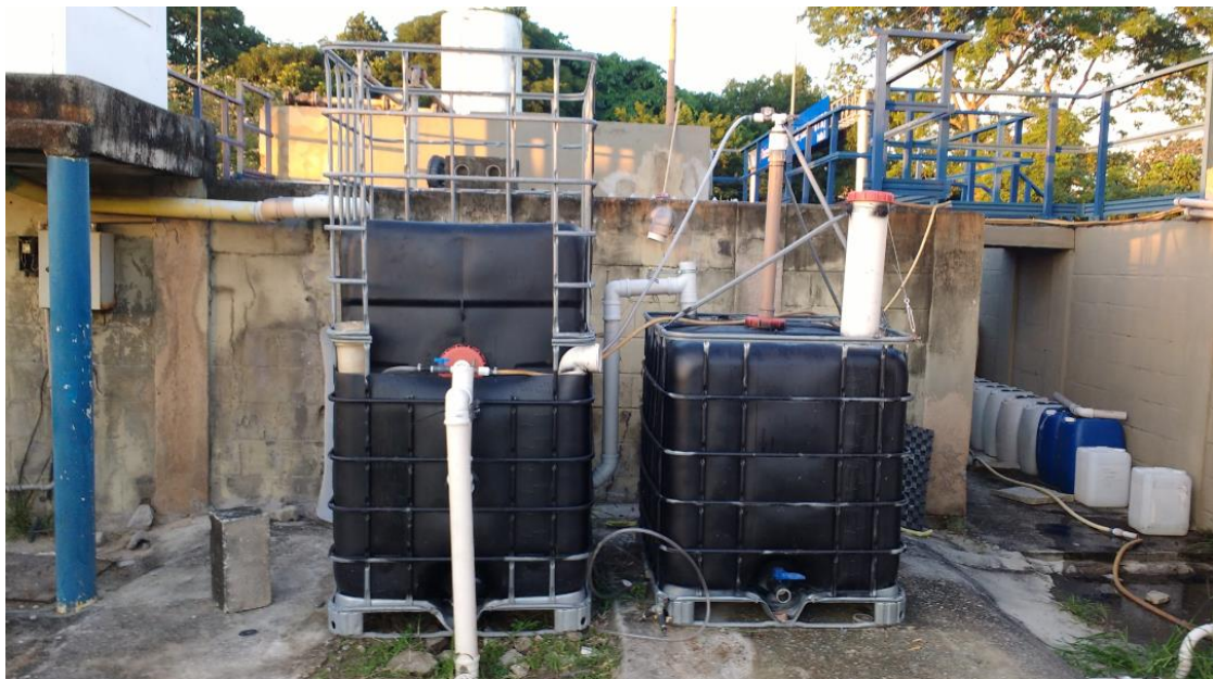
Figura 21: Vista frontal do digestor composto de um Reator (à direita) e gasômetro (à esquerda) (Fonte: Acervo do autor)
