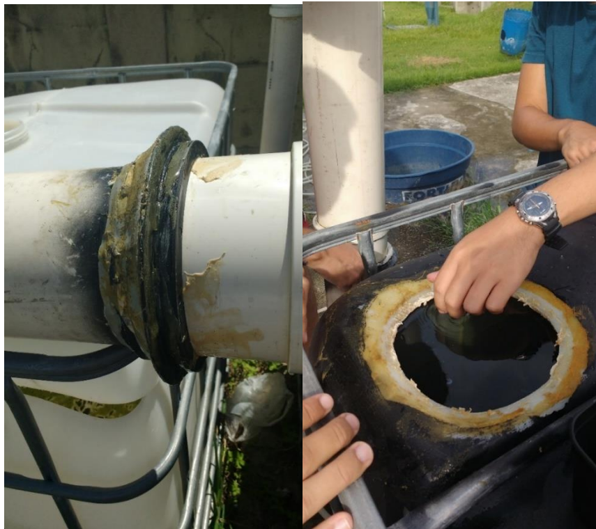
Figura 45: Aplicação de adesivos e catalisadores a base de resina de poliuretano/epóxi (Fonte: Acervo do Autor)
