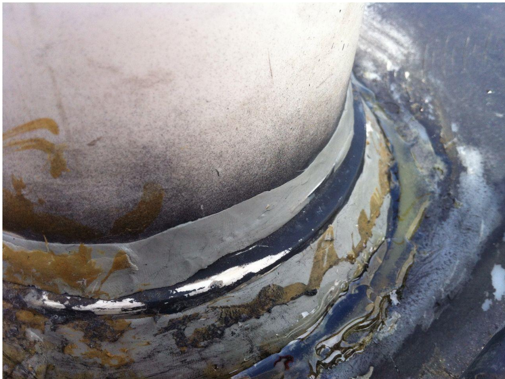
Figura 47: Aspecto final da conexão entre o tubo de alimentação de 150mm e o tampo superior do reator após a conferência de estanqueidade (Fonte: Acervo do Autor)
