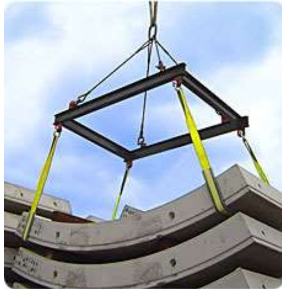
Figura 72 - Içamento de concreto com tiras de poliéster, acessório de guindaste adequado e cabos de aço.
