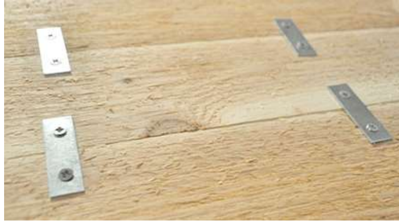
Figura 107 - Uso das chapas conectoras metálicas na junção de superfícies
