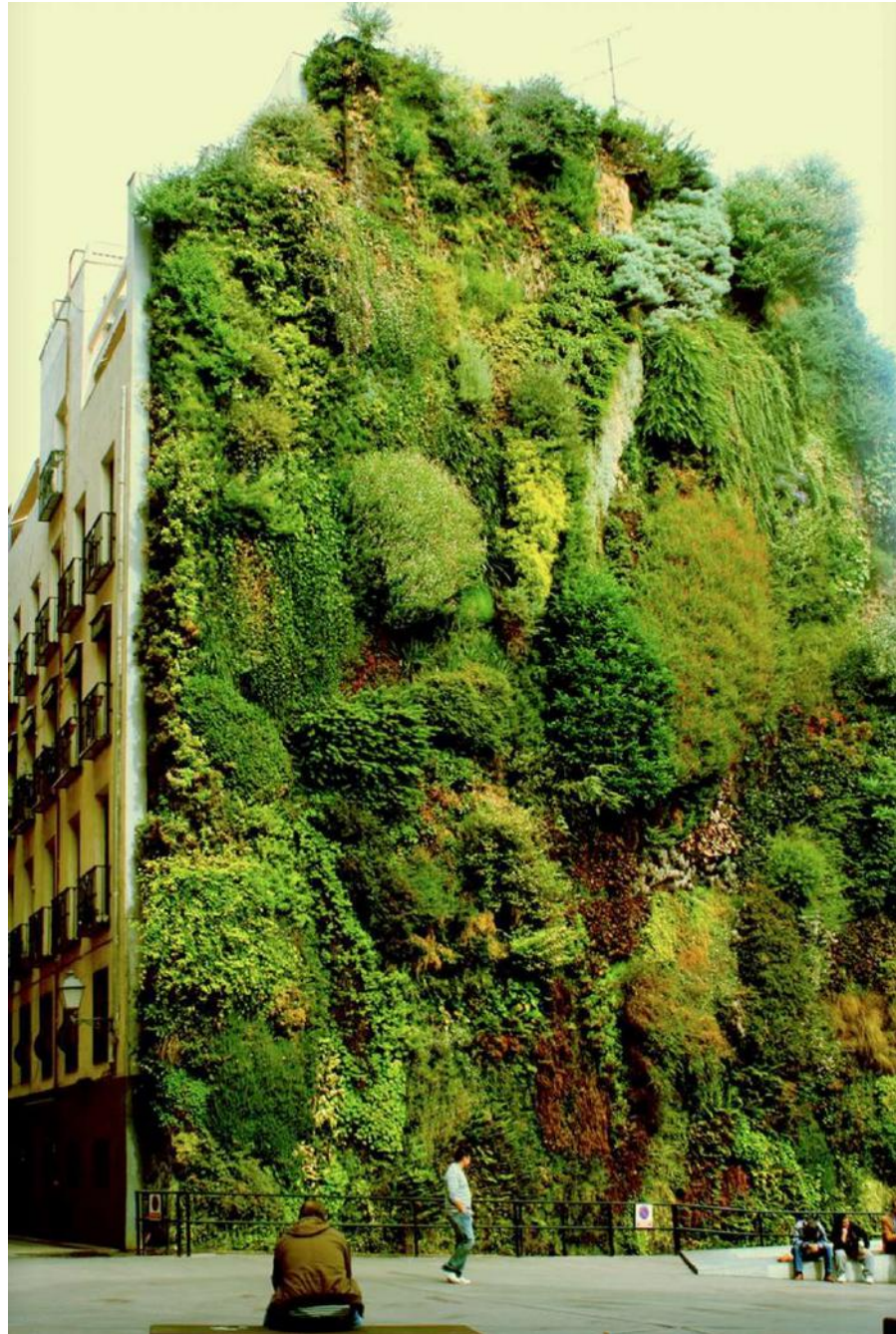
Figura 19 - Edifícios em Londres com parede verde montada em 2009, projeto do paisagista Patrick Blanc.
