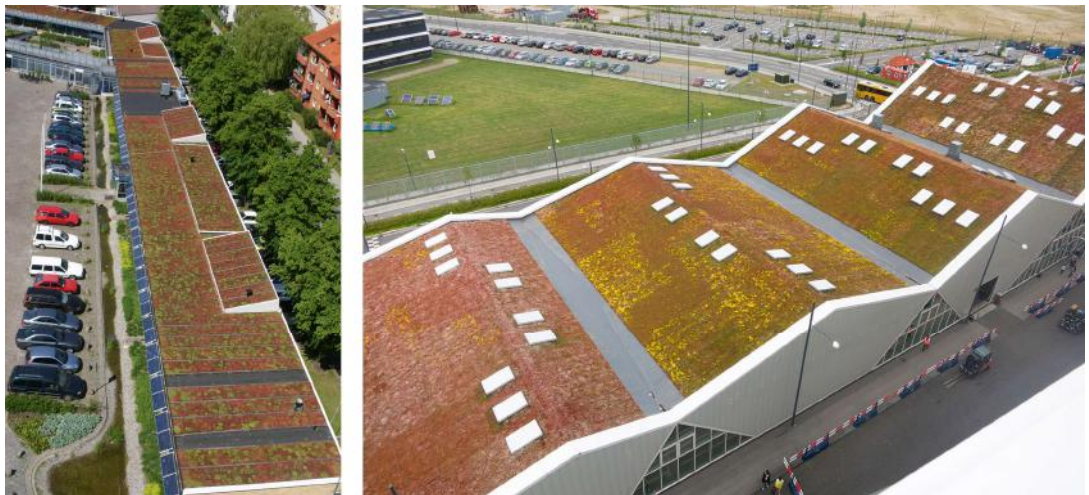
Figura 15 - Telhados verdes em Malmö, na Suécia, também contam com painéis solares acoplados.
