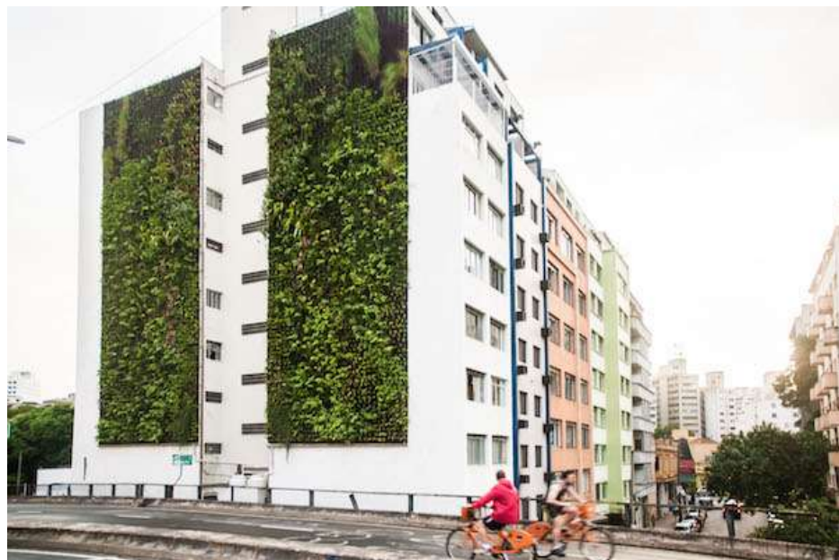
Figura 21 - Projeto do Movimento 90° em um dos prédios vizinhos ao Elevado Presidente Costa e Silva em São Paulo, montado em 2014.
