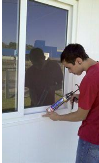
Fig 117: Interface entre parede e janela é preenchida com o PU 36 Fonte: Revista Pini
