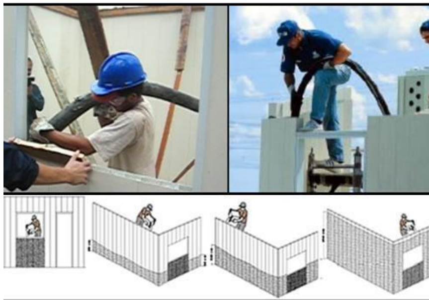
Fig 112: Processo de concretagem do PVC Fonte: Soluções para Cidades
