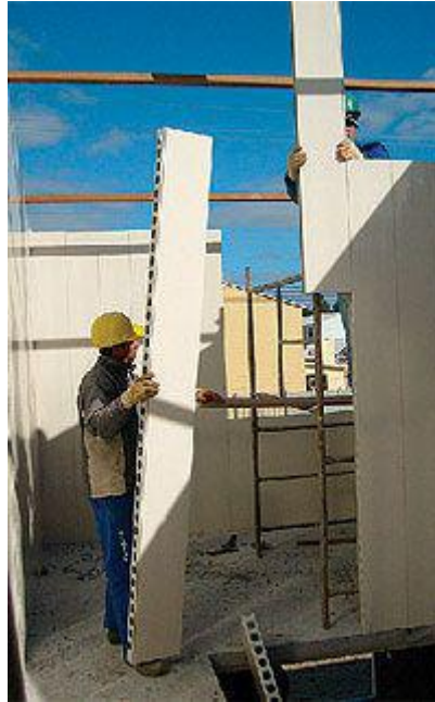
Fig 111: Perfis sendo encaixados por deslizamento Fonte: Revista Pini
