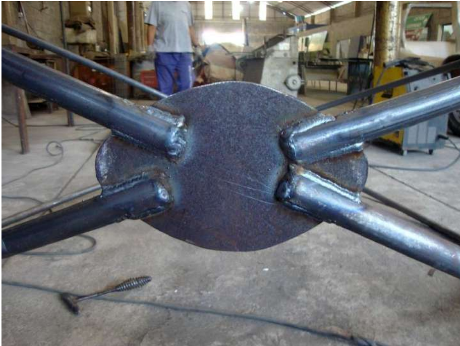
Figura 66: Encaixe da chapa nos tubos por solda MIG
