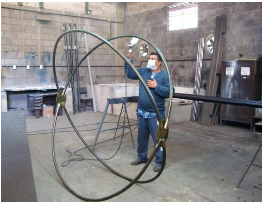
Figura 67: Estrutura levando o acabamento de wash primer
