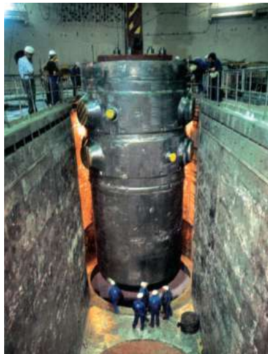
Figura 1.2: Reator do tipo PWR sendo instalado [2].
