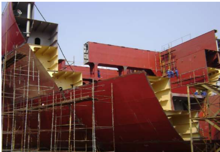
Fig. 18: Esteiro industrial, construindo um navio. Foto (Bogéa, 2010)
