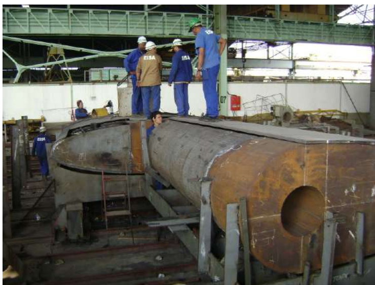
Fig. 19: Esteiro industrial, construção de um leme para um navio. Foto (Bogéa, 2010)
