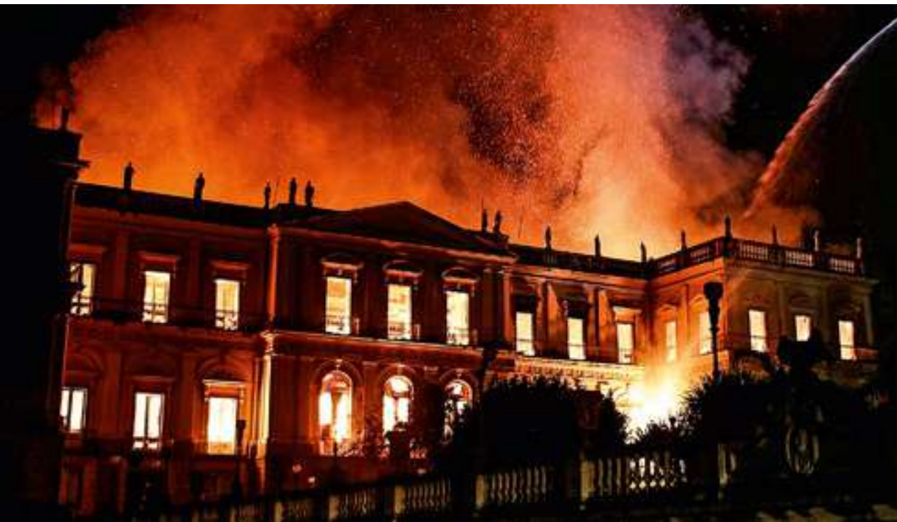
Museu Nacional do Rio de Janeiro, durante incêndio, em setembro de 2018.
