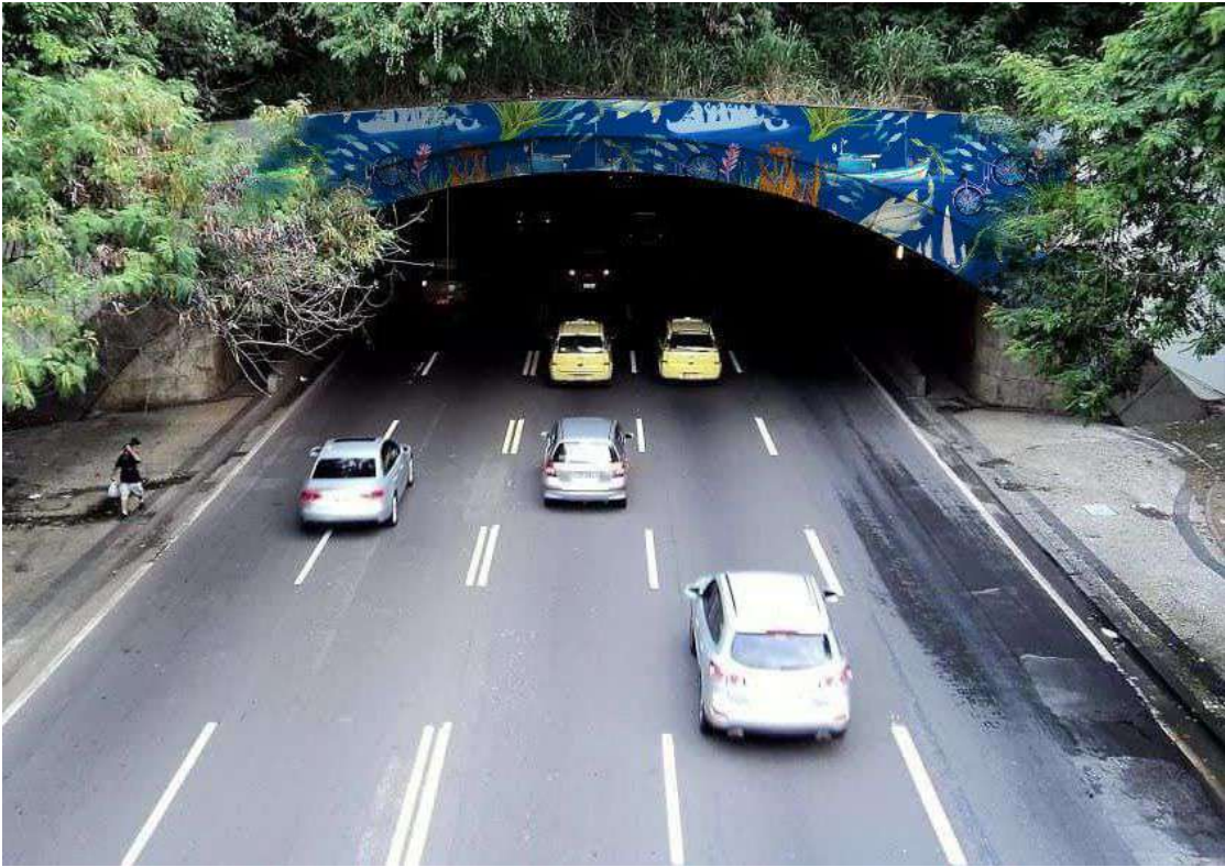
Figura 20 - Aplicação da estampa Social no túnel em Botafogo
