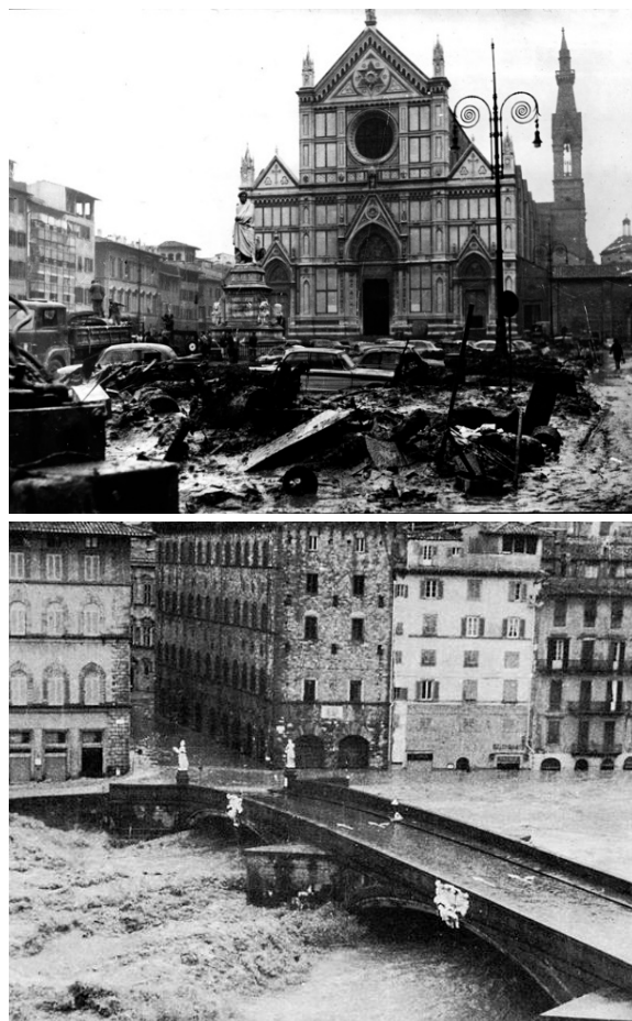
Figura 2.9 – Danos causados pela inundação de 1966 em Florença, Itália. Fonte: Ribeiro (2016).
