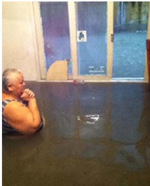
Figura 6.24 – Registro de Inundação localizado na Rua Ouseley com lâmina estimada pelos moradores de 1,8m Fonte: Portal G1 7
