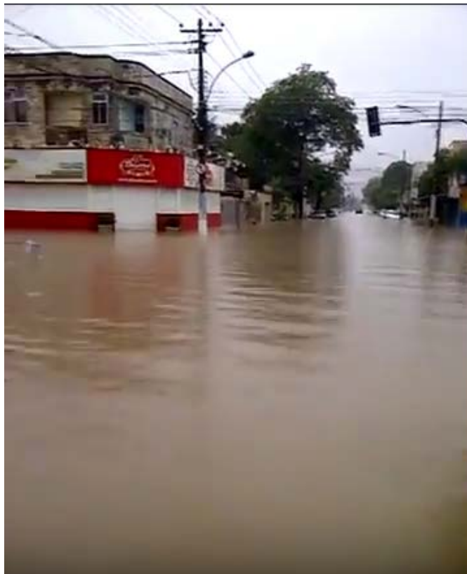
Figura 6.30 – Registro de Inundação localizado no cruzamento entre Rua Mercúrio e a Rua Sargento Basileu da Costa lâmina estimada de 0,6m Fonte: Página eletrônica YouTube 13
