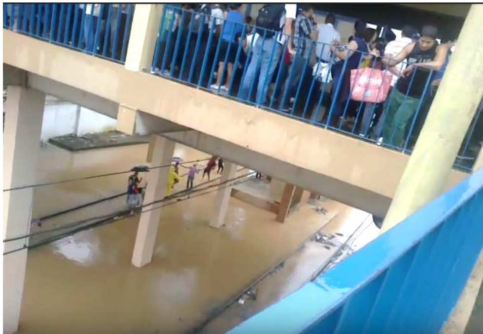
Figura 6.34 – Registro de inundação localizada nos trilhos da Estação Pavuna/São João de Meriti. Fonte: Página eletrônica YouTube 17
