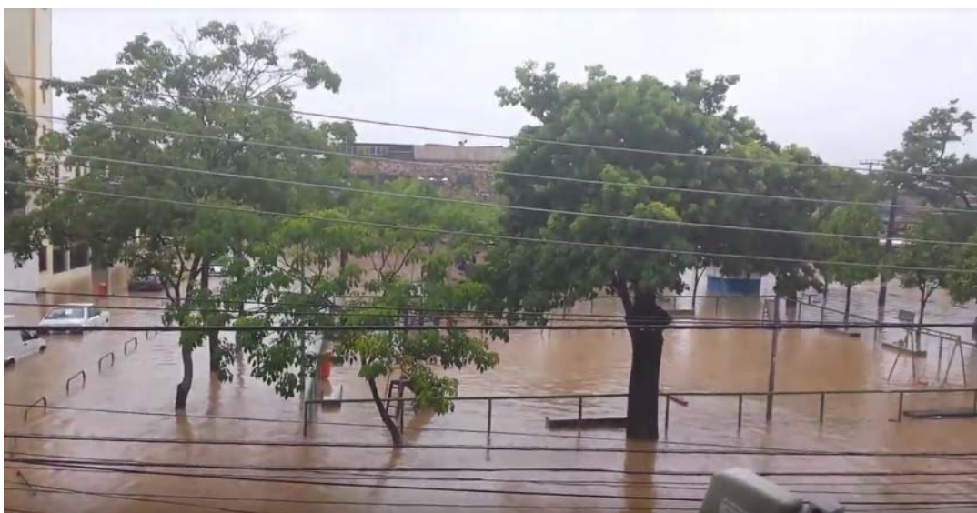
Figura 6.32 – Registro de Inundação localizada Praça Nossa Senhora das Dores, na Pavuna, com lâmina estimada de 0,7m Fonte: Página eletrônica YouTube 15
