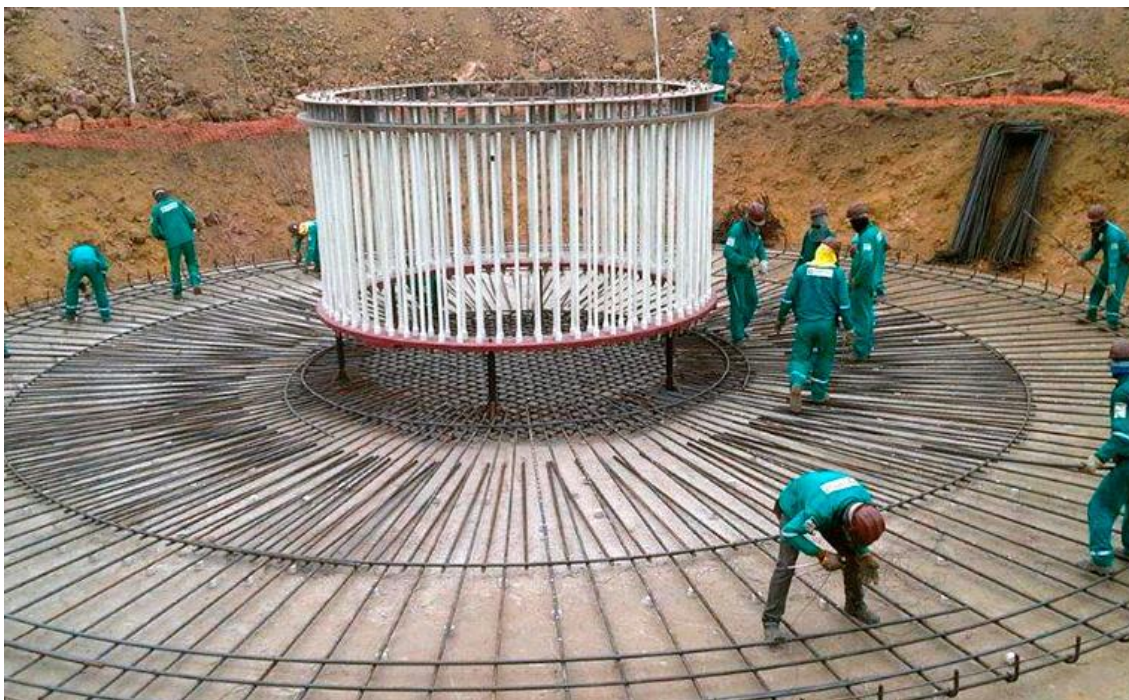
Figura 2.8 : Conexão típica torre-bloco de fundação rasa em início de construção localizada no município de Araripina, Pernambuco (MACÊDO, 2016).
