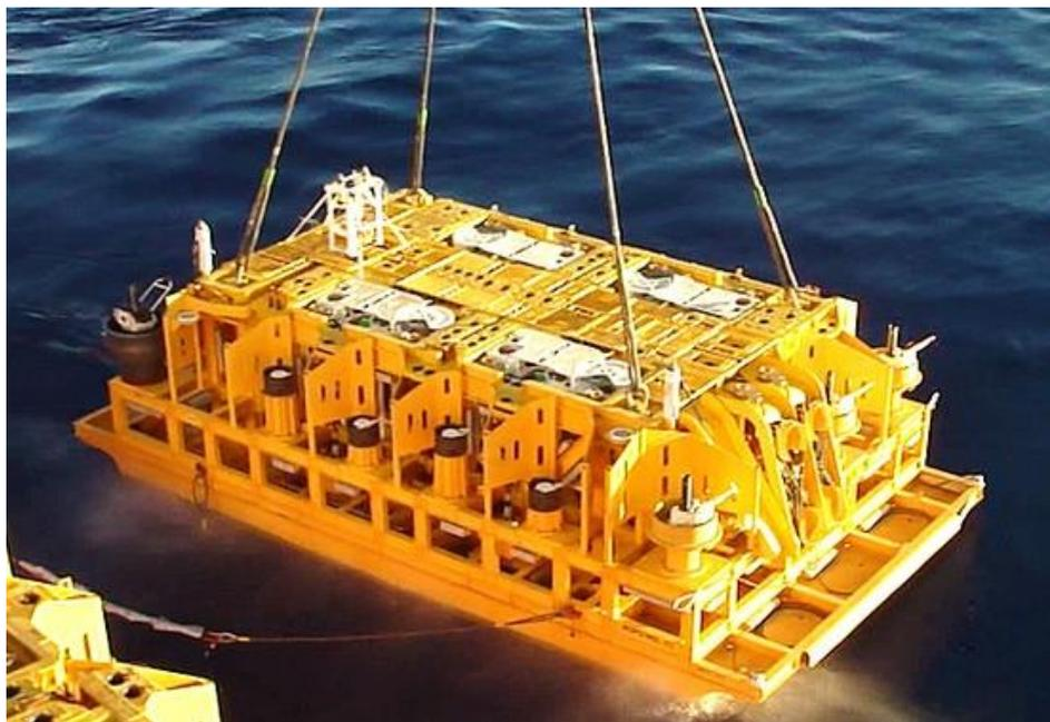
*Figura 40 – Manifold sendo instalado*
