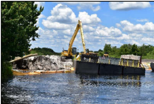
Figura 2-20: Abertura do canal principal.
