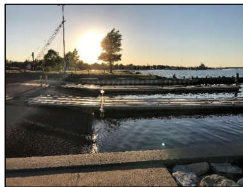
Figura 2-44: Rampa em Cambridge
