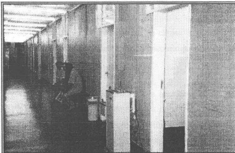
*Figura 4.31 – Espera interna do 2º pav.. Acabamentos das paredes em placas de paviflex na cor cinza e do piso na cor preto. Nova iluminação artificial e instalação de venezianas de vidro acima das portas.*
