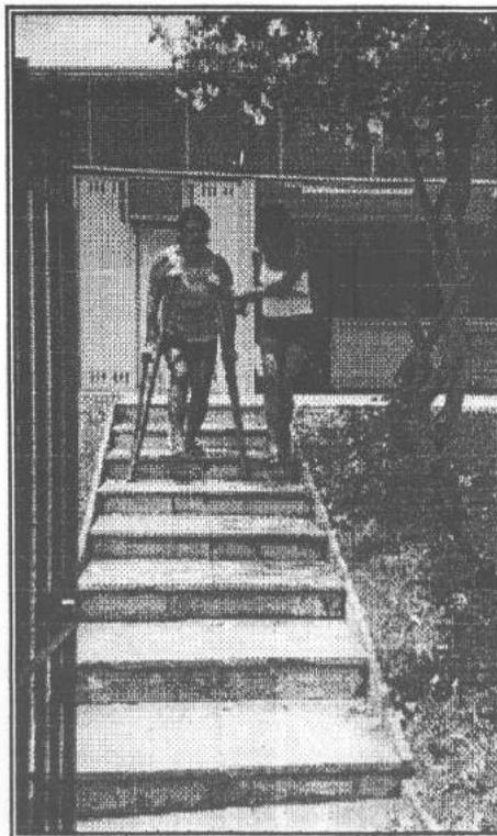
Figura 4.51 – Escada de acesso ao prédio. Falta de corrimão e árvore que é utilizada como apoio.
