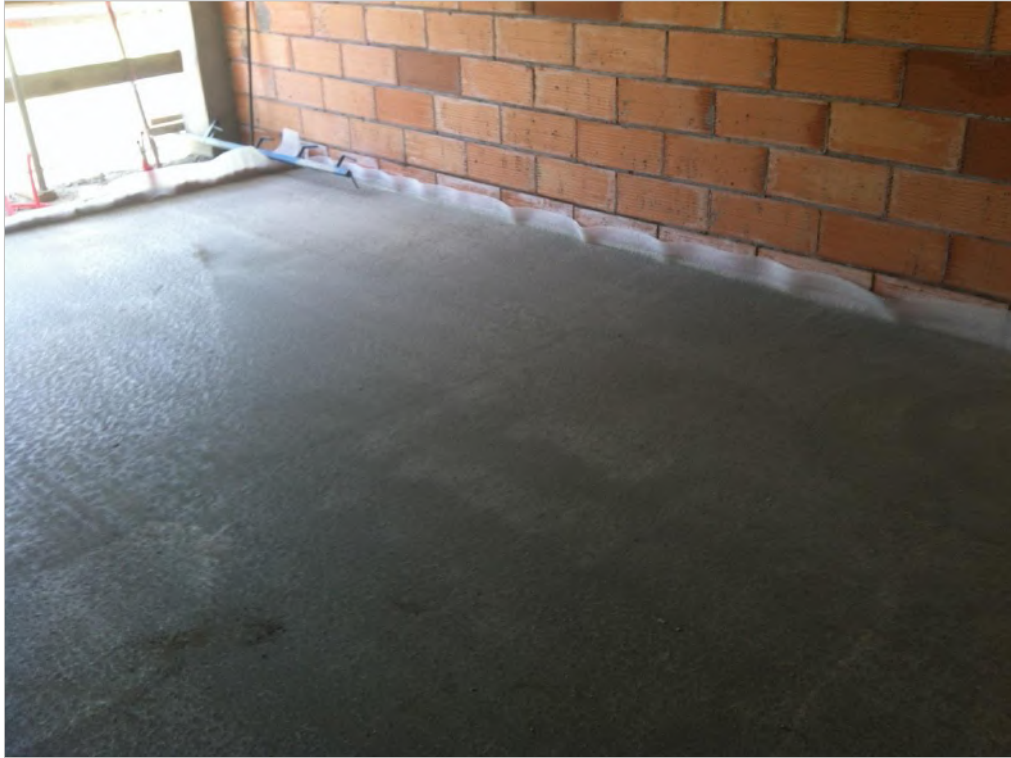
Figura 75: Fraguado de la capa de mortero de cemento
