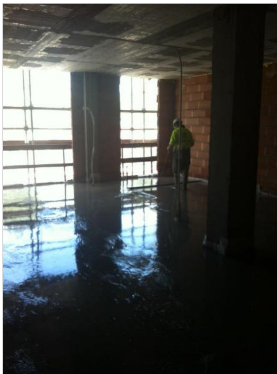
Figura 70: Alisado y nivelado de la capa de mortero de cemento
