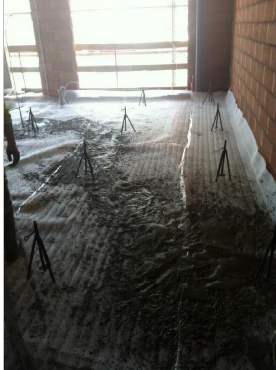
Figura 66: Vertido de la capa de mortero de cemento Fuente: AMSA Arquitectura. Barcelona, España.
