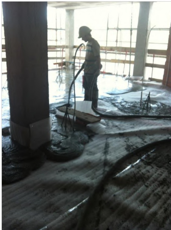
Figura 69: Vertido de la capa de mortero de cemento Fuente: AMSA Arquitectura. Barcelona, España.
