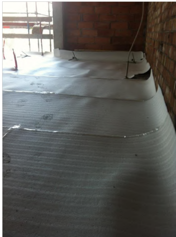
Figura 64: Colocación de la lámina anti-impacto
