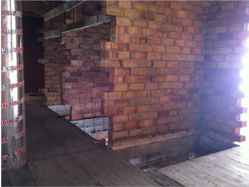
Figura 62: Forjado de hormigón
