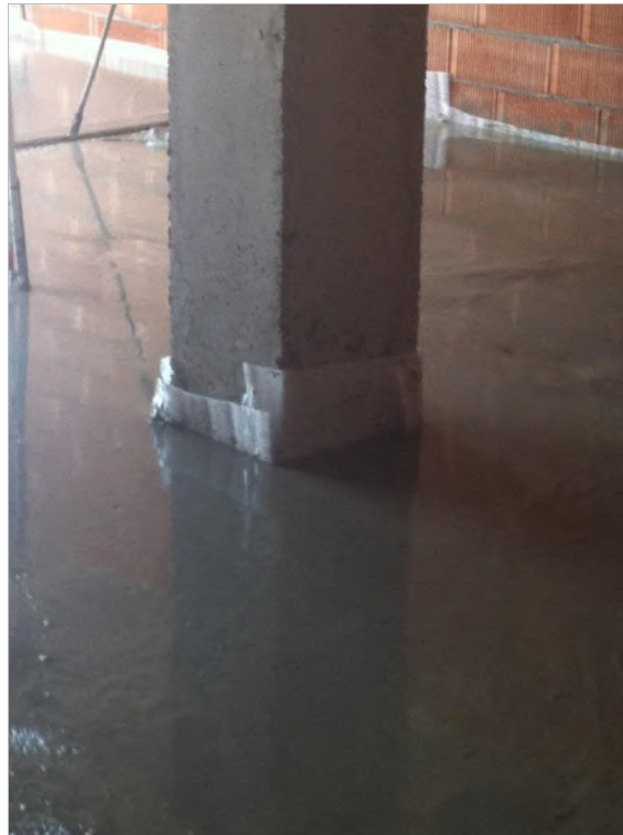
Figura 77: Solución de doblado ante elementos verticales ya contruidos
