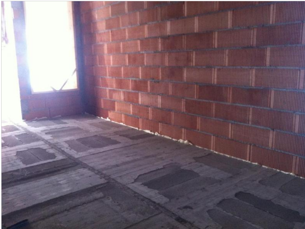
Figura 61: Forjado de hormigón
