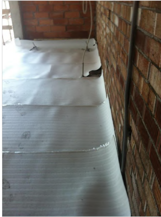
Figura 65: Colocación de la lámina anti-impacto
