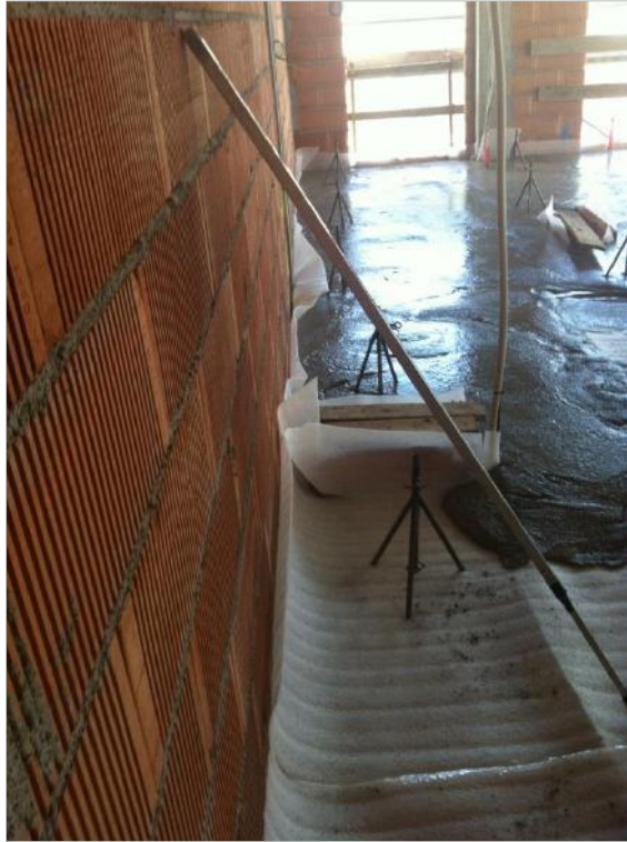
Figura 68: Vertido de la capa de mortero de cemento Fuente: AMSA Arquitectura. Barcelona, España.
