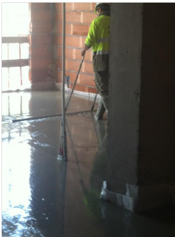
Figura 71: Alisado y nivelado de la capa de mortero de cemento
