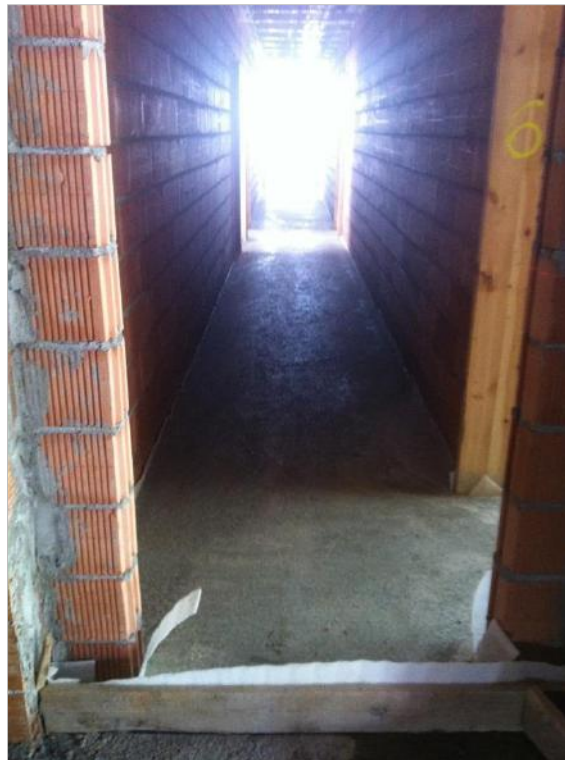
Figura 76: Fraguado de la capa de mortero de cemento
