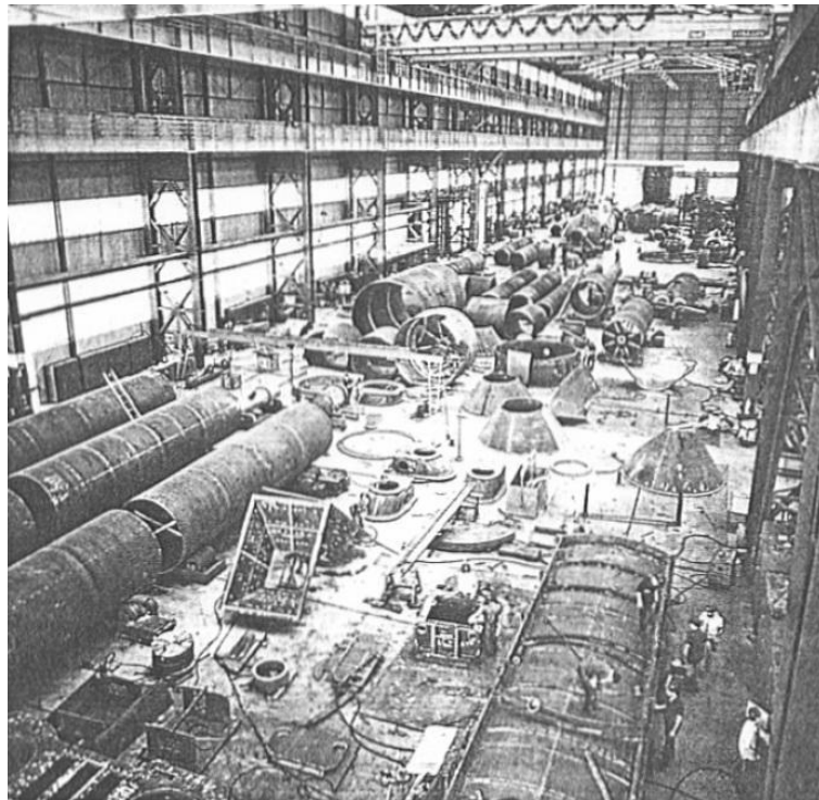
Figura 3.48 – Grande Galpão de Oficina de Fabricação de Vasos de Pressão da CONFAB S.A. (retirada de [3])
