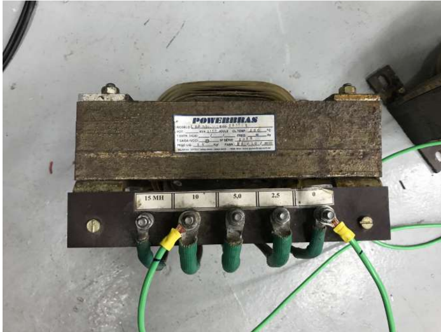
Figura 7.9: Indutor da fase a conectado entre o ponto de acoplamento do sistema e a rede local para a obtenção de perfil de tensão desequilibrado.
