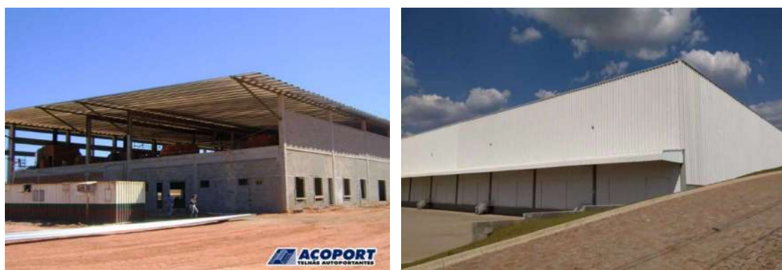
Figura 2.5 - Exemplos de aplicações de telhas de aço formadas a frio de perfil trapezoidal Fonte: (AÇOPORT, 2018) e (STANCK, 2018)
