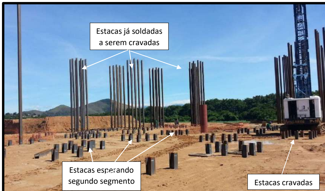
Figura 3.11 Processo de cravação
