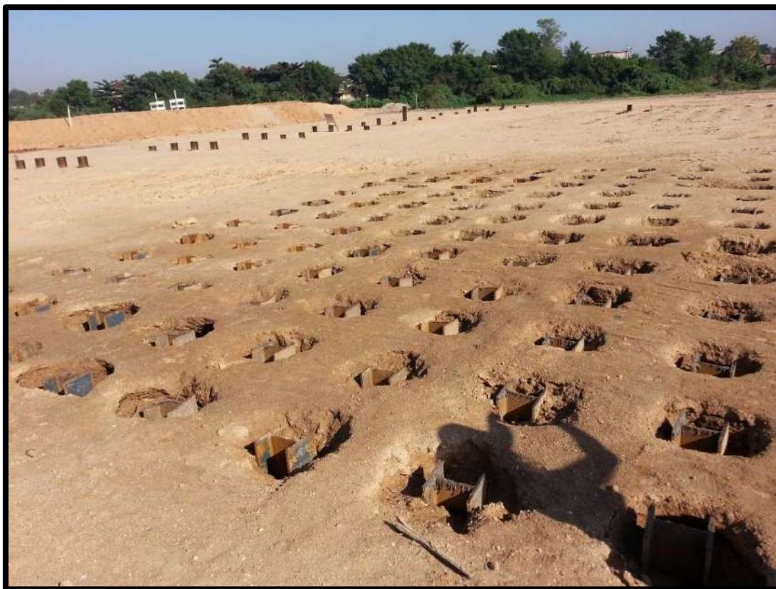
Figura 3.12 Grupo de estacas cravadas e arrasadas
