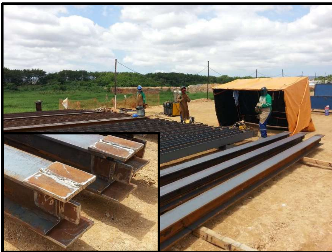
Figura 3.9 Central de soldagem e emendas com talas metálicas soldadas
