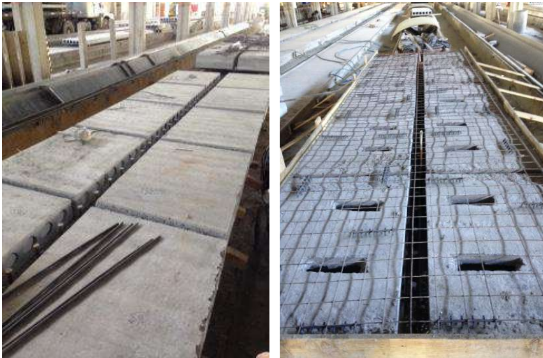
Figura 3.3: Sequência executiva dos protótipos, (a) posicionamento das placas e (b) posicionamento da tela Q138. (Fonte: BATISTA e LANDESMANN, 2016).
