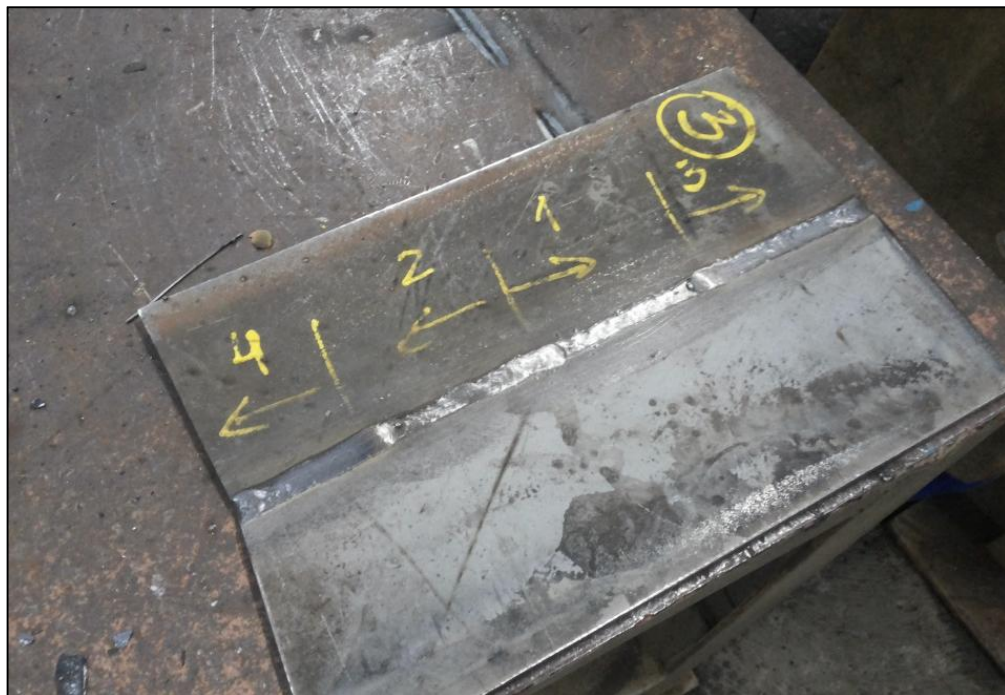
Figura 13 –Pós execução da solda passe à ré, onde o soldador promove a soldagem do meio para as pontas de forma intercalada. A marcação da mesma forma que o anterior indica o onde começou e terminou cada passe seguindo a sequência numérica.
