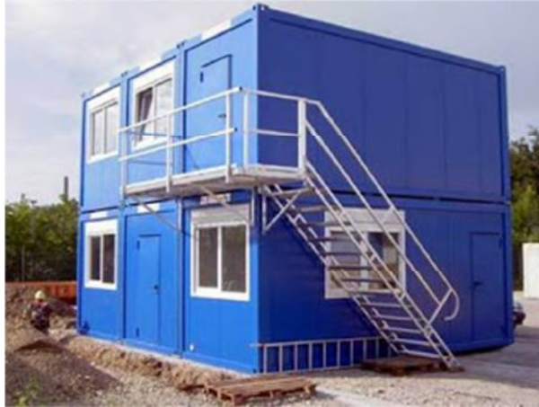
Figura 5 – Exemplo de Arranjo de containers ( http://sp.quebarato.com.br , 2014)
