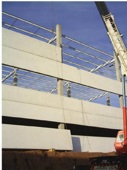
Figura 42 - Montagem de fachada pré-fabricada. ( http://www.perville.com.br , 2014)
