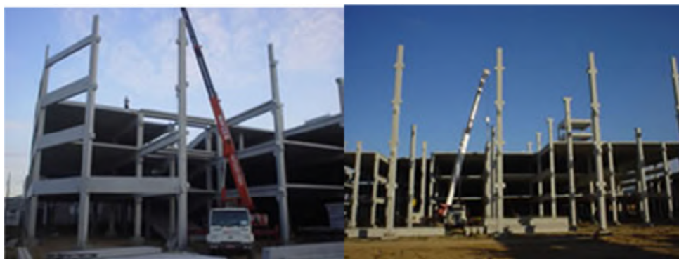
Figura 9 – Montagem de estrutura de concreto pré-moldado ( www.mwguindastes.com.br , 2014)
