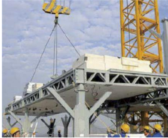
Figura 35 - Posicionamento da "main board" sobre os pilares. (www.broad.com, 2014)
