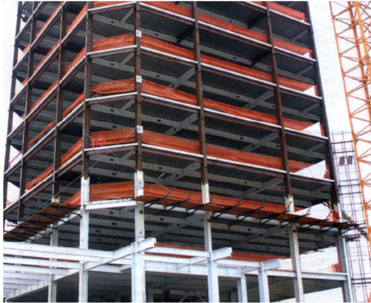
Figura 14 - Estrutura metálica montada. ( http://www.cbca-acobrasil.org.br/ , 2013)
