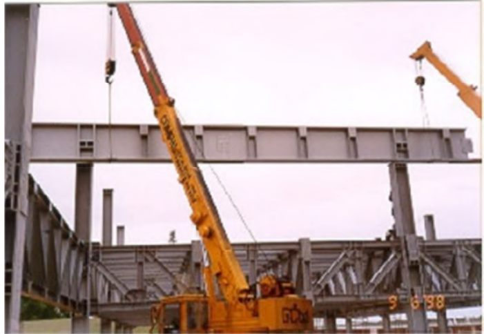
Figura 12 - Montagem de estrutura metálica. (www.ufsm.br, 2013)
