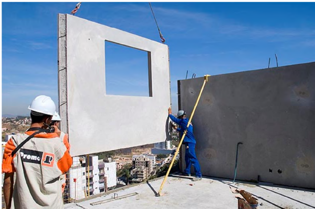
Figura 32 - Montagem de uma parede pré-fabricada ( http://comunidade.maiscomunidade.com , 2014)
