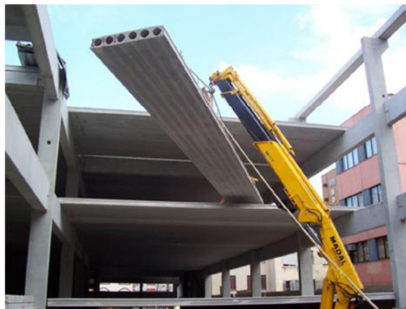
Figura 10 – Içamento de laje alveolar para posicionamento na estrutura (www.adove.com.br, 2014)
