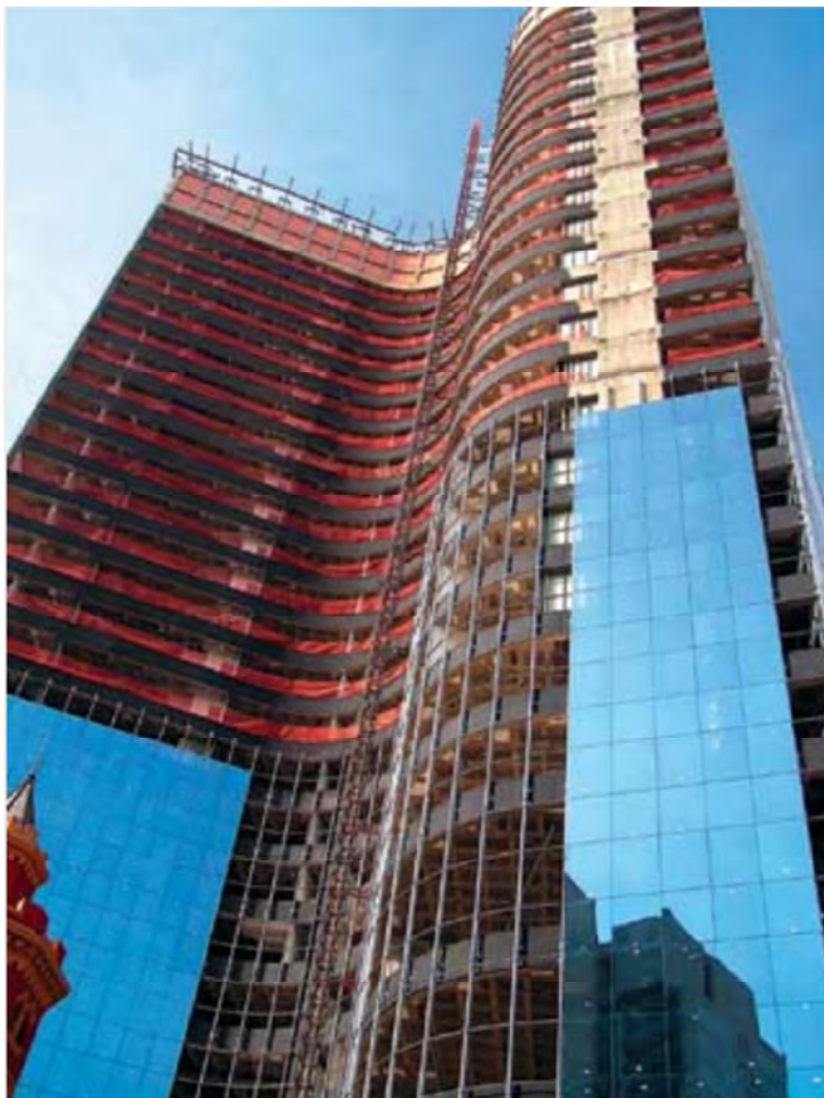
Figura 28 - Montagem dos painéis modulares. (www.arcoweb.com.br, 2014)
