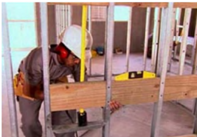
Figura 22 - Reforço de madeira na estrutura de aço galvanizado (www.portaldrywall.com.br, 2014)
