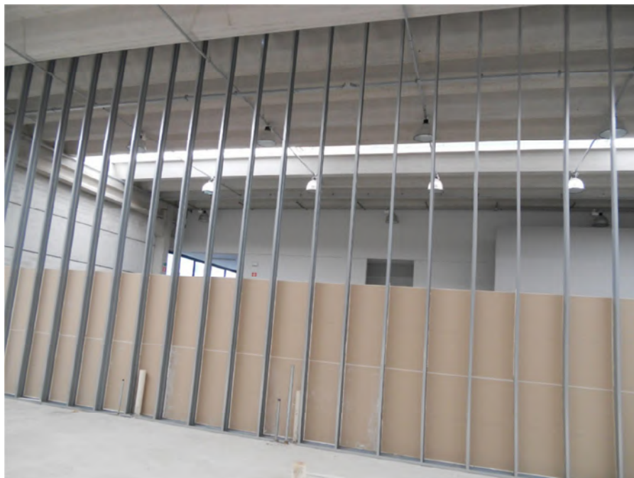
Figura 19 - Estrutura da parede montada ( www.facilitieservicos.com.br , 2013)
