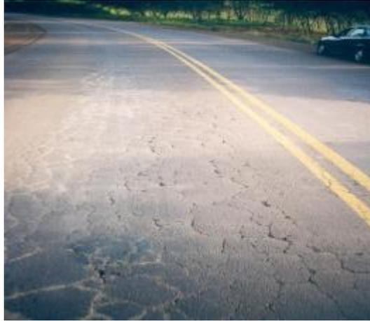
*Figura 3 - Trincas Interligadas (FONTES, 2009)*
